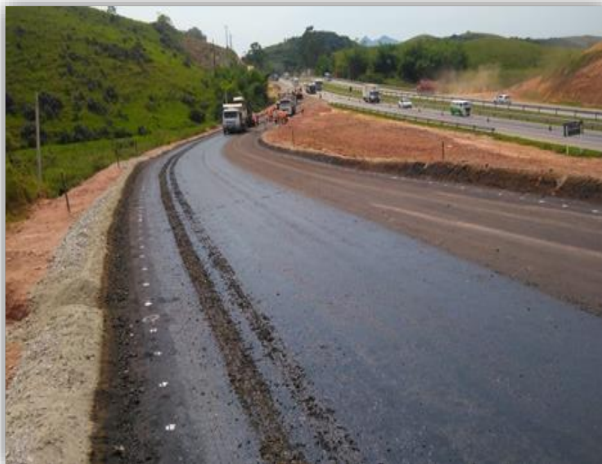
Figura 01 – Imprimação - km 204
