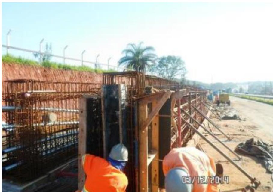
*Figura 02 – Montagem de formas e concretagem das vigas da OAE*
