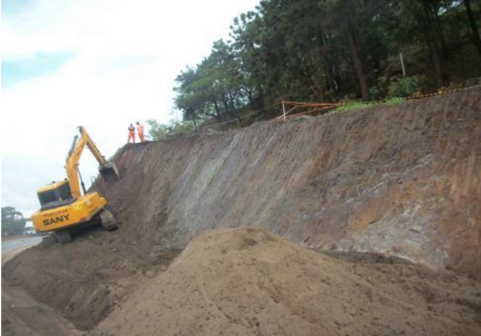
*Figura 01 – Corte de talude para alargamento de faixa*
