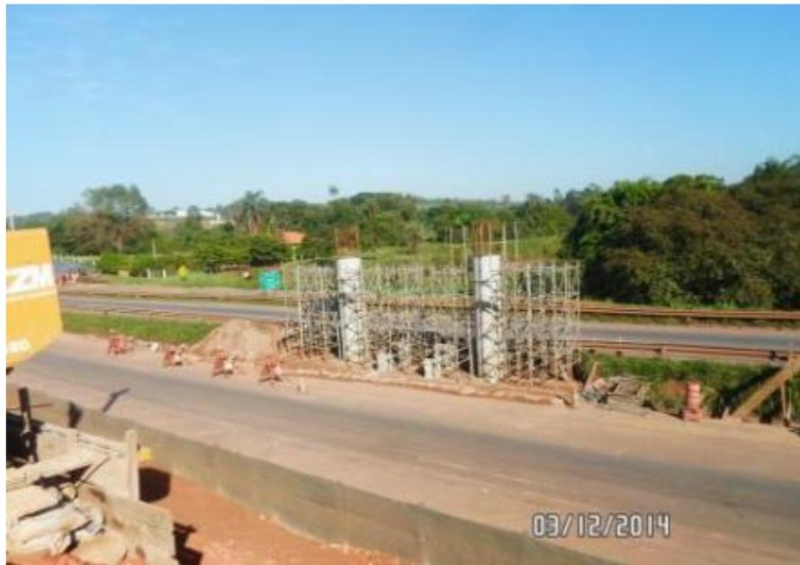
*Figura 01 – Execução dos pilares centrais da OAE*
