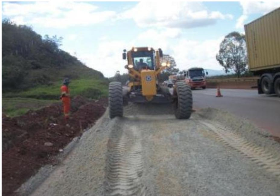
*Figura 06 – Lançamento e compactação de camada BGS*
