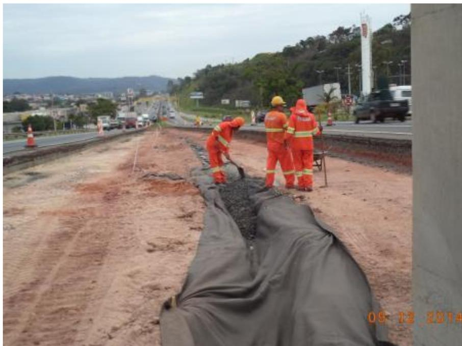
*Figura 04 – Execução de dreno de pavimento*
