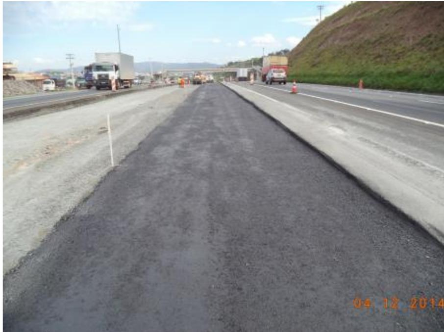
*Figura 03 – Imprimação da camada de base*
