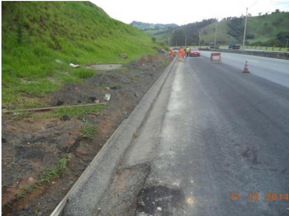
*Figura 05 – Execução de dispositivo de drenagem*
