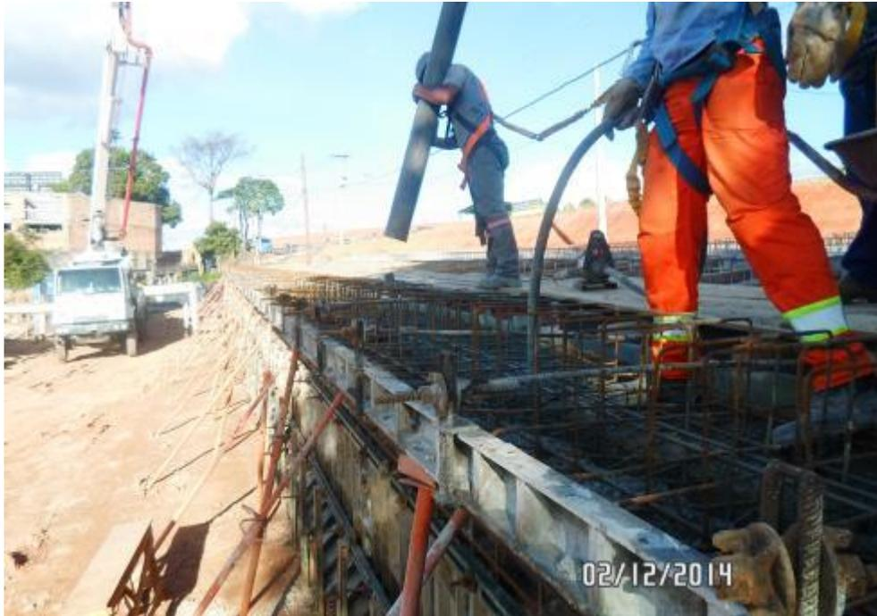
*Figura 01 – Concretagem de vigas da OAE*
