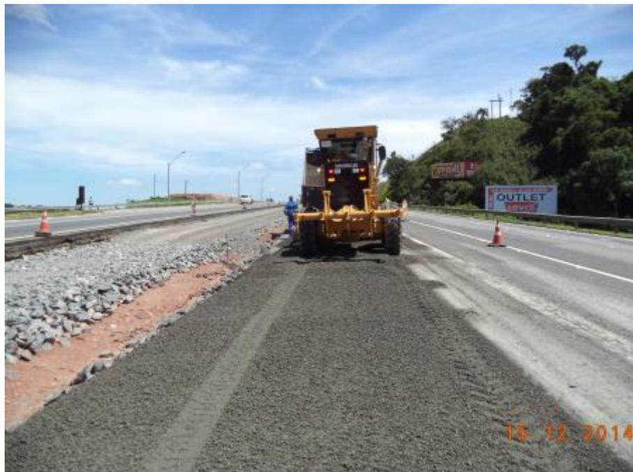
*Figura 06 – Lançamento e compactação de camada BGS*
