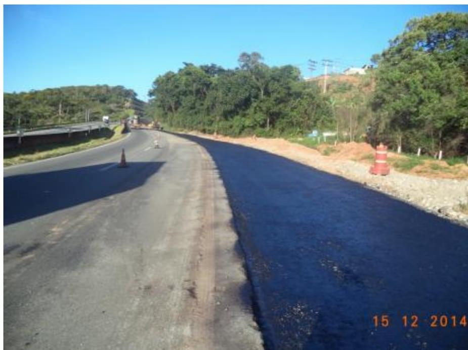
*Figura 06 – Imprimação da camada de base*
