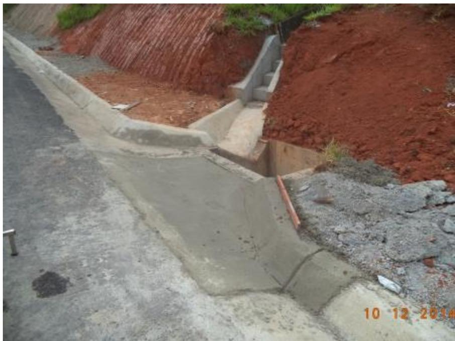
*Figura 01 – Execução de dispositivos de drenagem*
