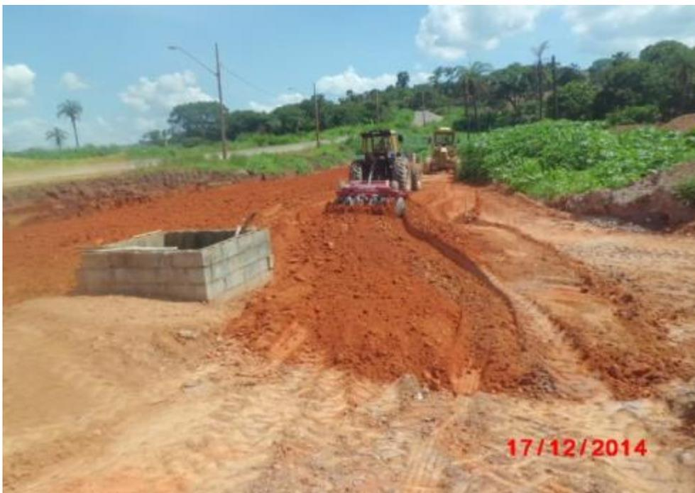
*Figura 04 – Tratamento e compactação de sub leito*
