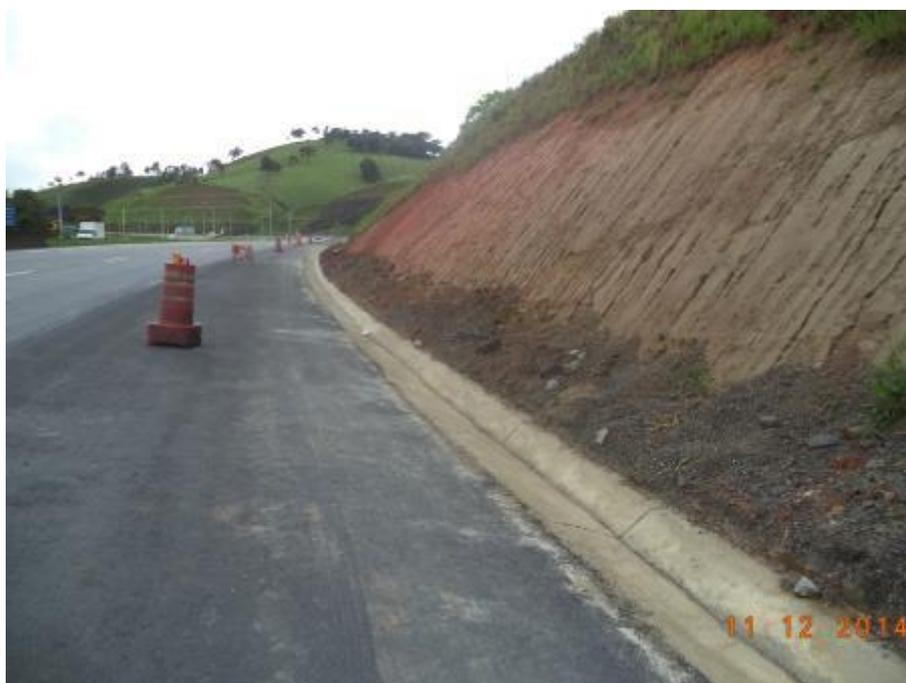
*Figura 04 – Execução de dispositivo de drenagem*
