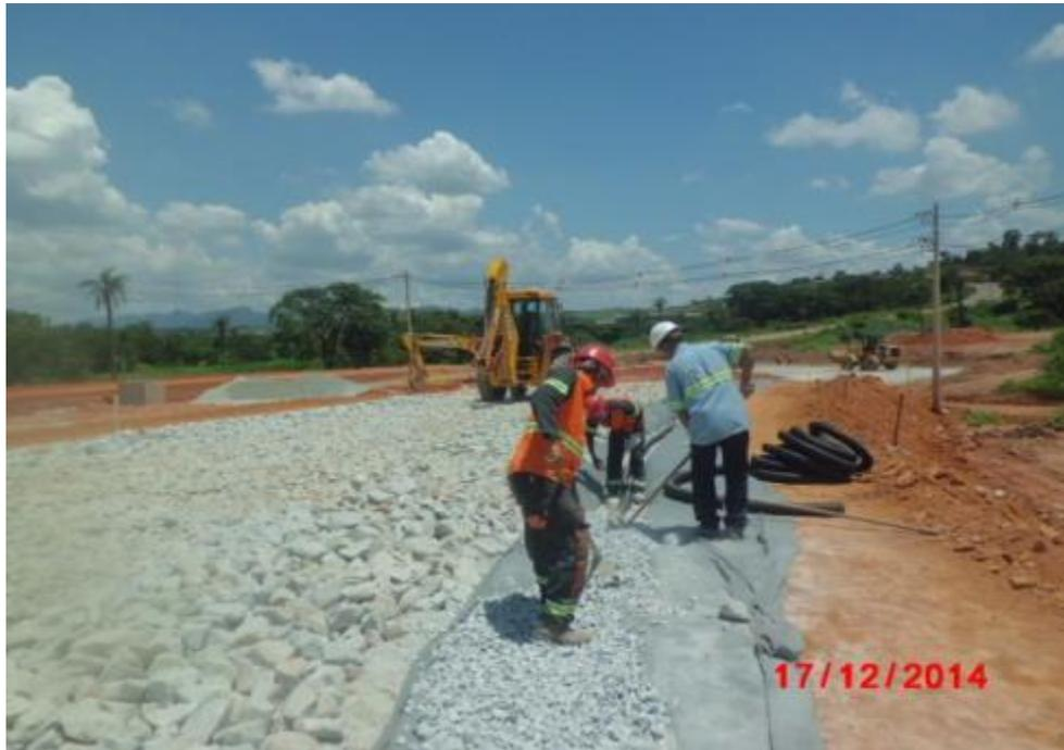
*Figura 03 – Execução de dreno de pavimento e reforço da base*
