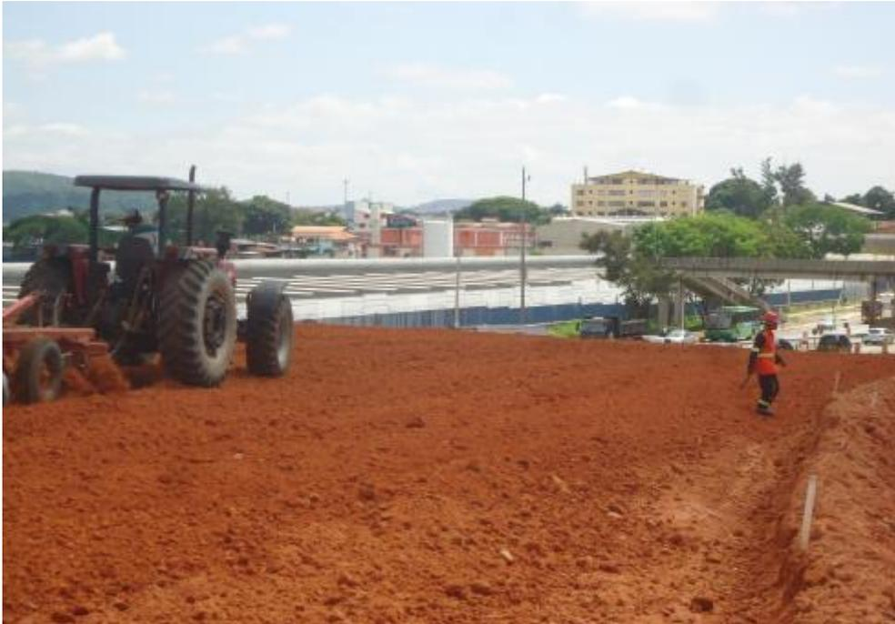
*Figura 05 – Tratamento e compactação de sub leito*
