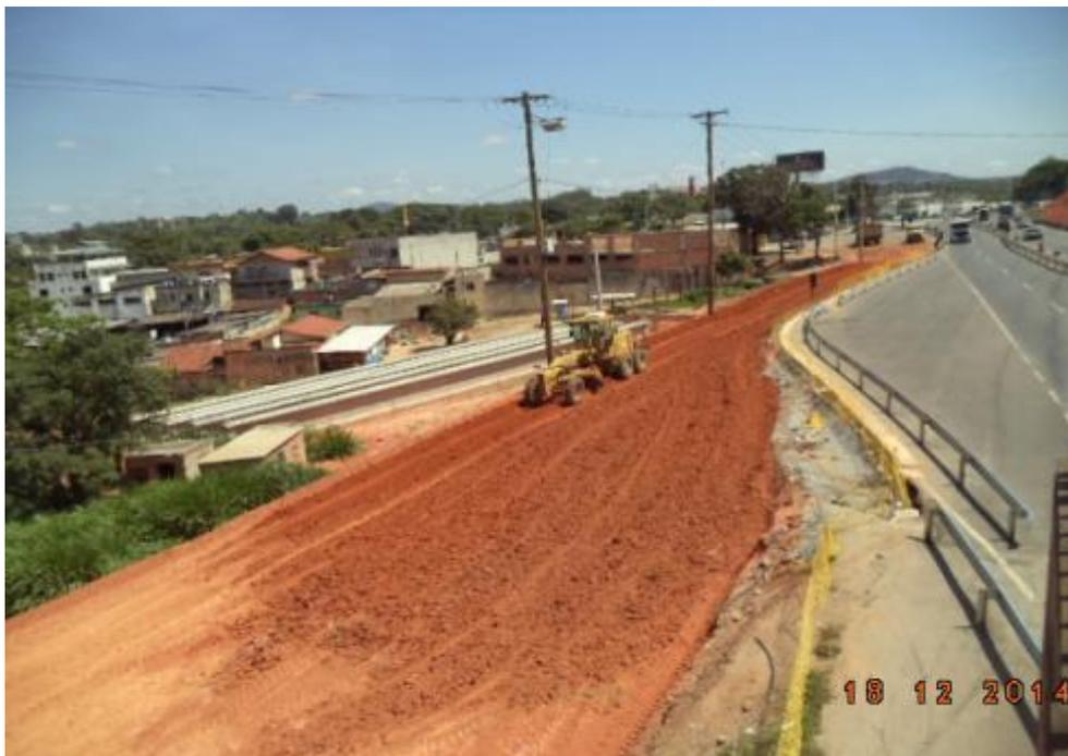
*Figura 06 – Tratamento e compactação de sub leito*
