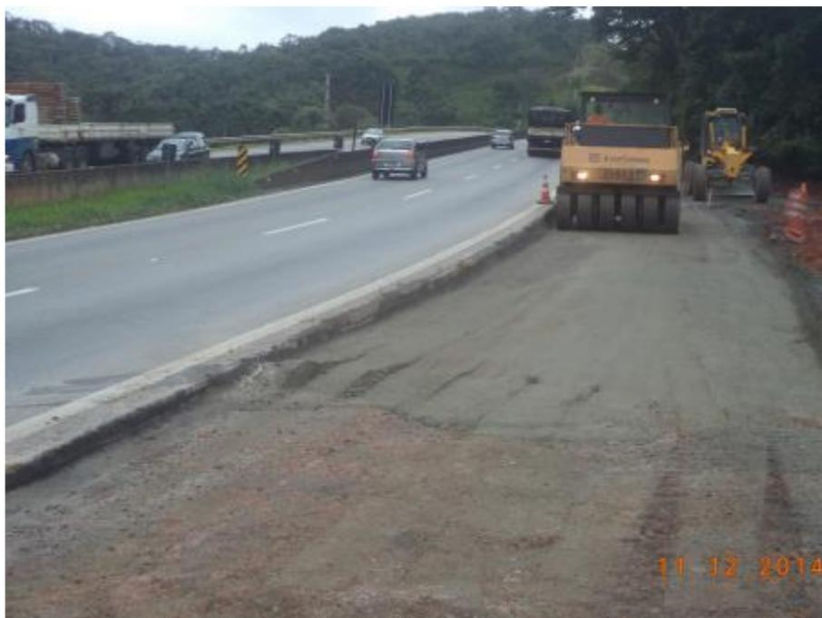
*Figura 03 – Lançamento e compactação de camada BGS*
