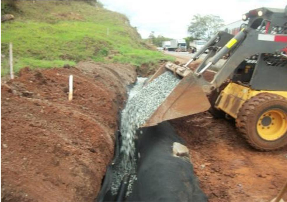
*Figura 03 – Execução de dreno de pavimento*
