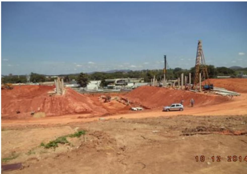
*Figura 02 – Cravação de estacas para execução da base da OAE*
