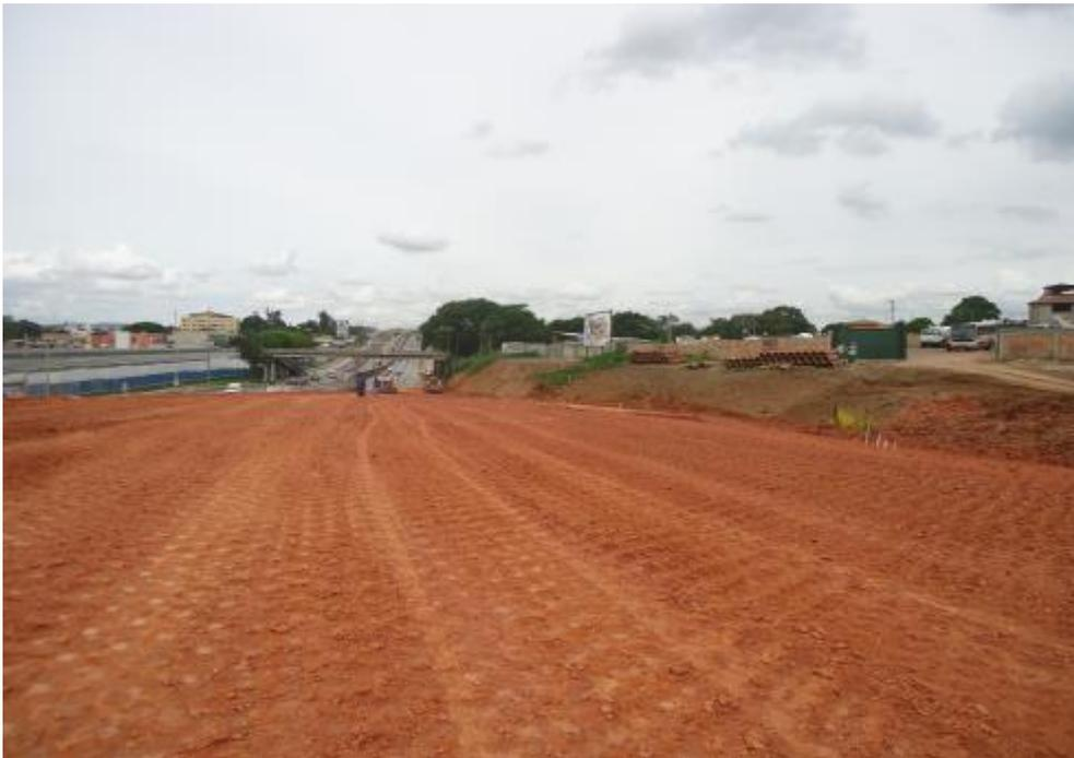
*Figura 03 – Tratamento e compactação de sub leito*
