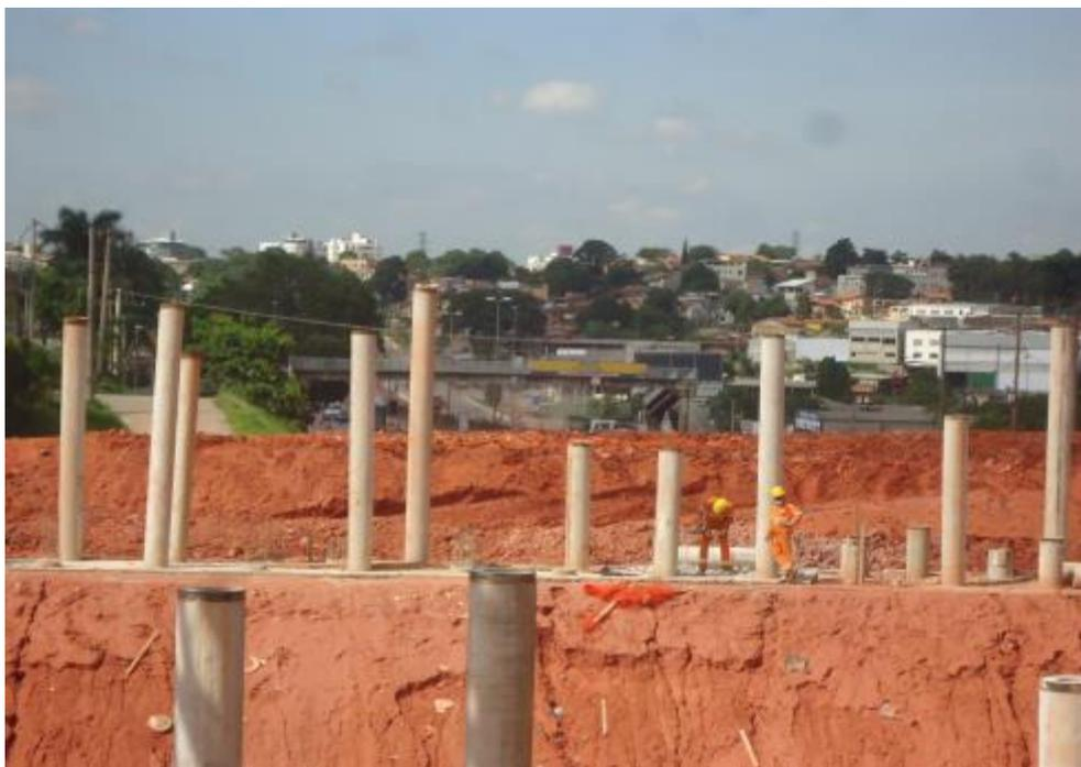
*Figura 04 – Cravação de estacas para execução da base da OAE*
