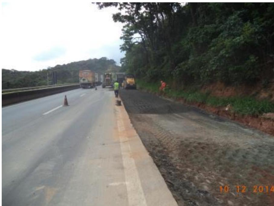
*Figura 02 – Lançamento e compactação de camada BGS*
