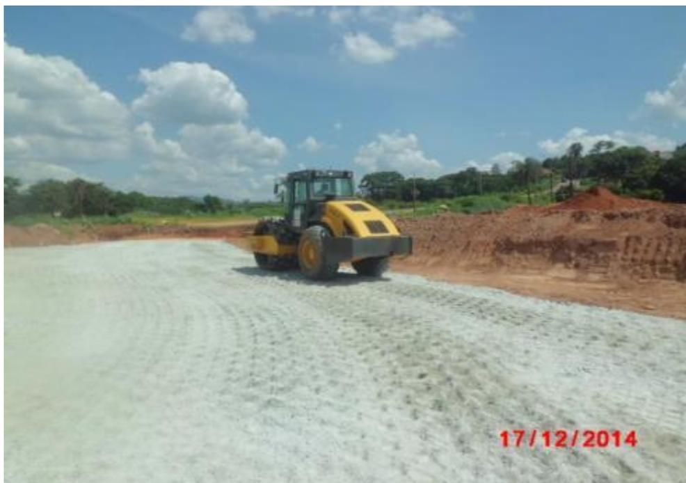
*Figura 06 – Compactação da camada base do pavimento*
