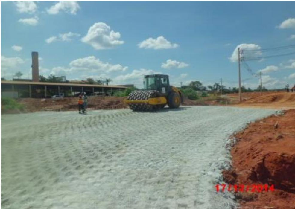
*Figura 05 – Compactação da camada base do pavimento*
