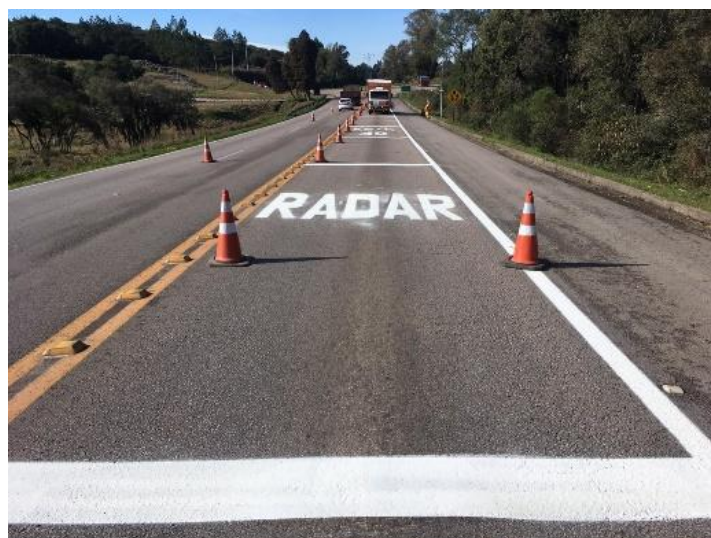
Figura 03 – Serviços de sinalização horizontal BR-392/RS – Rio Grande – Pelotas – Santana da Boa Vista / km 099+500
