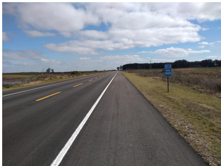
Figura 02 – Serviços de recuperação do pavimento BR-116/RS – Trecho Pelotas – Jaguarão / km 562+000
