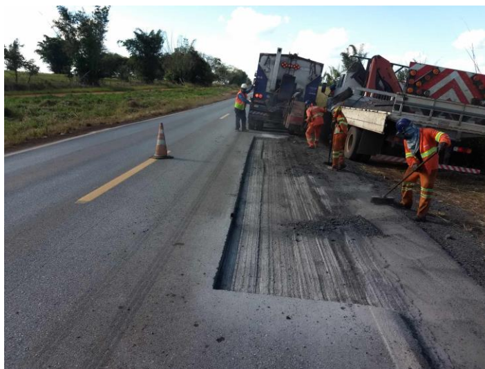
Figura 1 – Execução de reparos localizados. km (BR-163) 543+000
