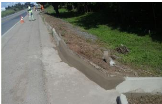
Figura 11 – Recuperação de Drenagem Superficial km (BR-364) 490+000
