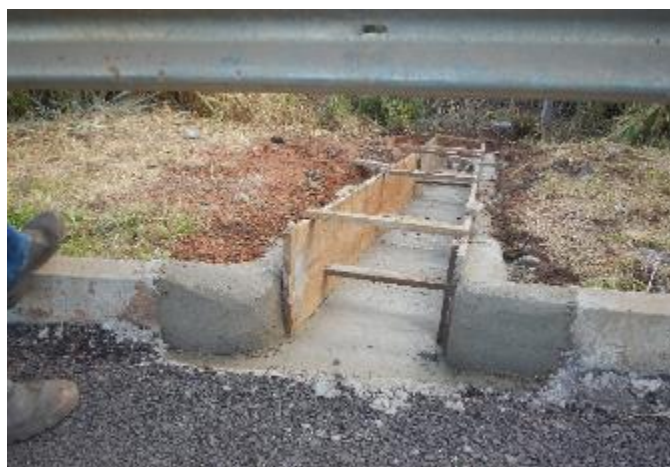
Figura 10 – Limpeza e Recuperação de Drenagem Superficial km (BR-163) 45+550 Sul
