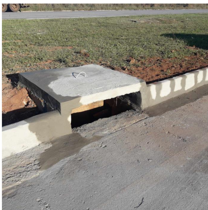
Figura 12 – Limpeza e Recuperação de OAC km (BR-163) 600+000
