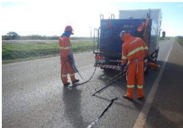
Figura 5 – Aplicação de Sela Trinca km (BR-163) 22+000 Norte
