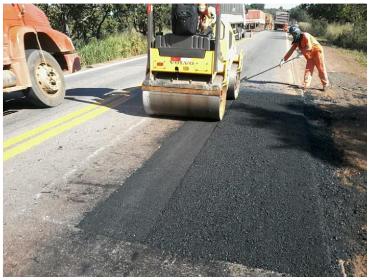
Figura 3 – Execução de reparos localizados. km (BR-364) 537+100
