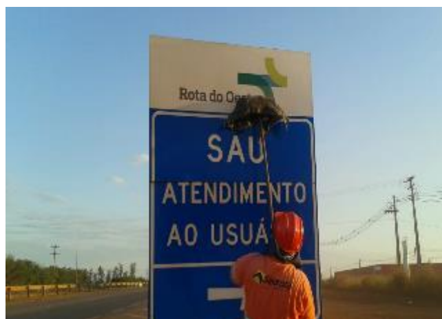
Figura 18 – Limpeza de Sinalização Vertical km (BR-163) 117+700
