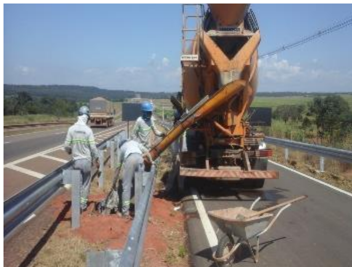
Figura 17 – Concretagem das bases dos postes – PPV01 km (BR-163) 108+800
