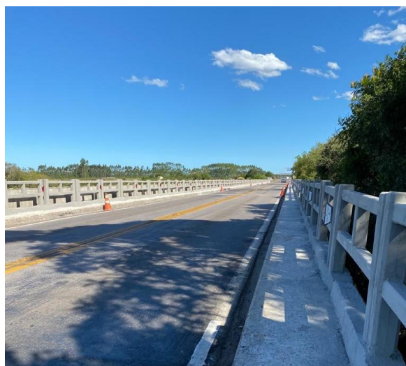
Figura 02 – Conclusão da obra sobre a ponte do Arroio Evaristo BR-116/RS – Trecho Camaquã – Pelotas / km 429+569
