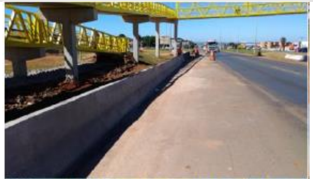
Foto 04: Instalação das barreiras New Jersey
