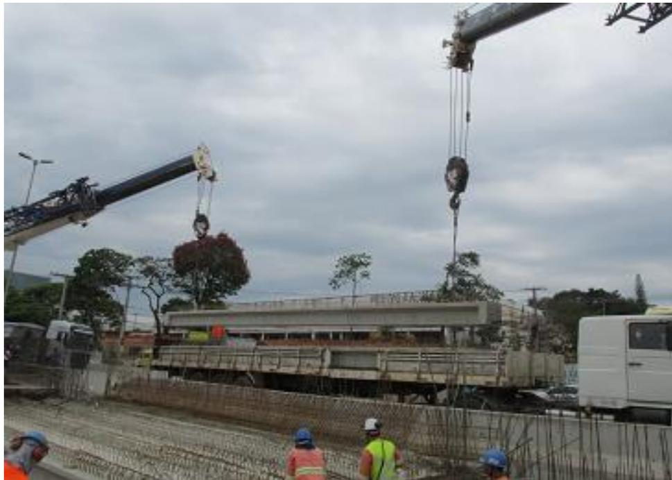
*Figura 01 – Lançamento das vigas pré-moldadas*
