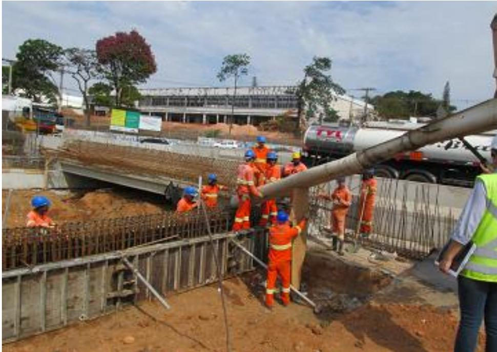
*Figura 03 – Concretagem da viga VC4*
