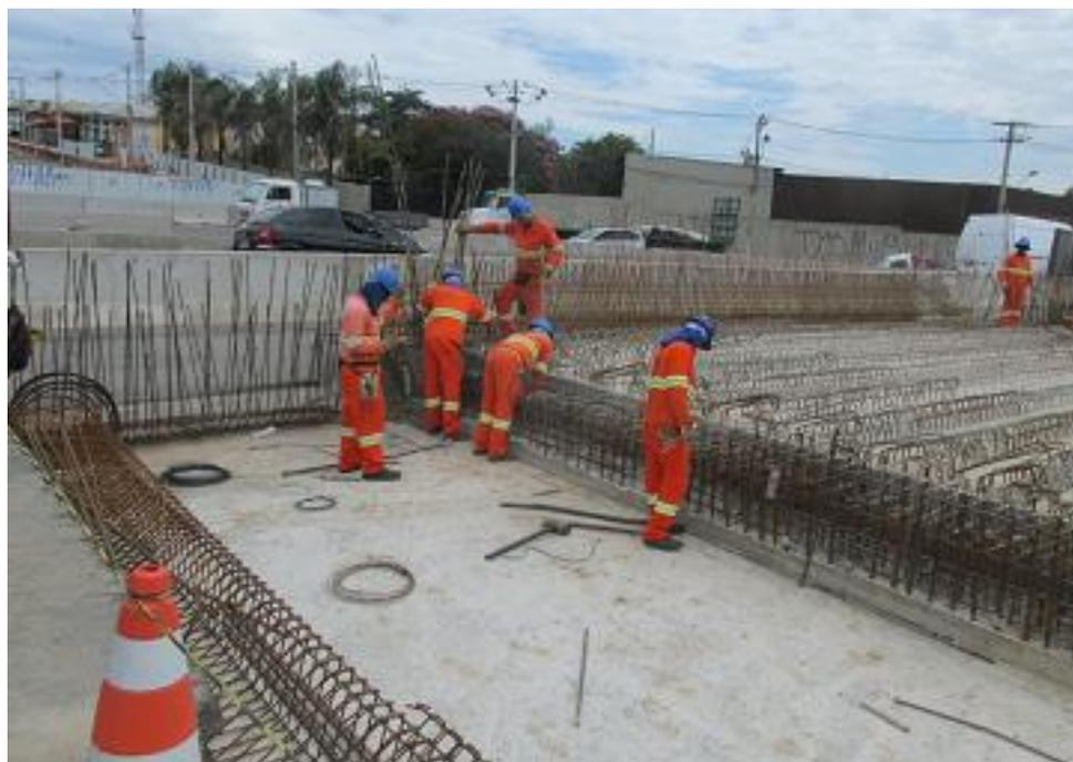
*Figura 02 – Armação da laje da trincheira*
