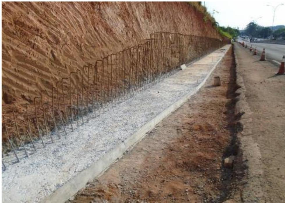
*Figura 05 – Execução do muro de contenção*
