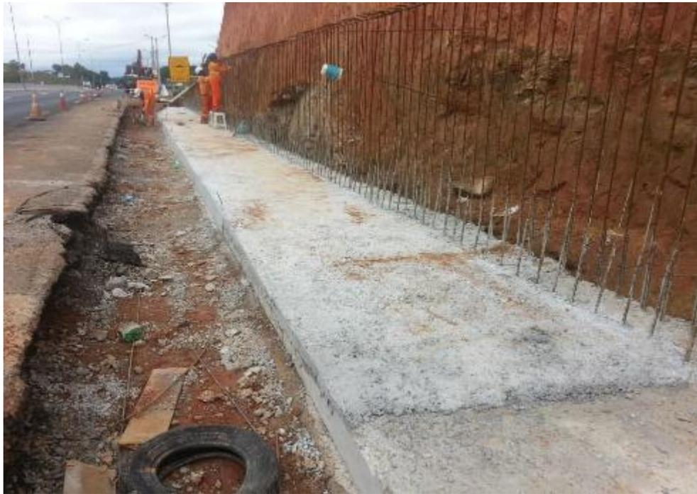
*Figura 03 – Execução do muro de contenção*
