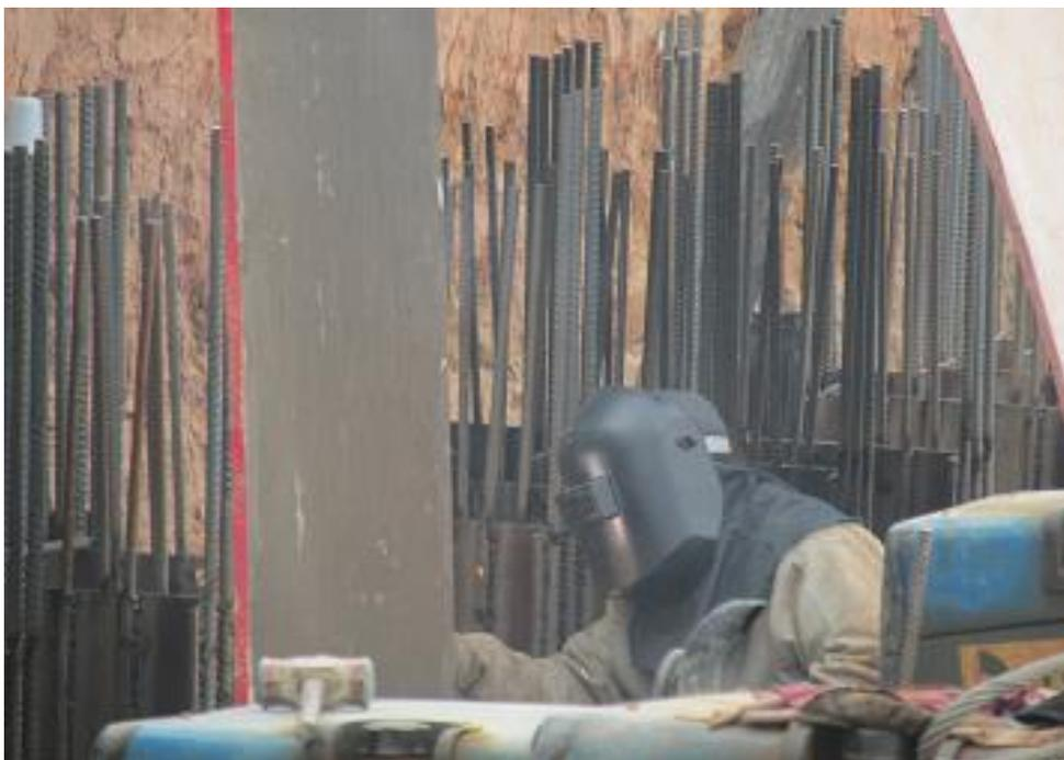
*Figura 06 – Solda das esperas da viga VC3*
