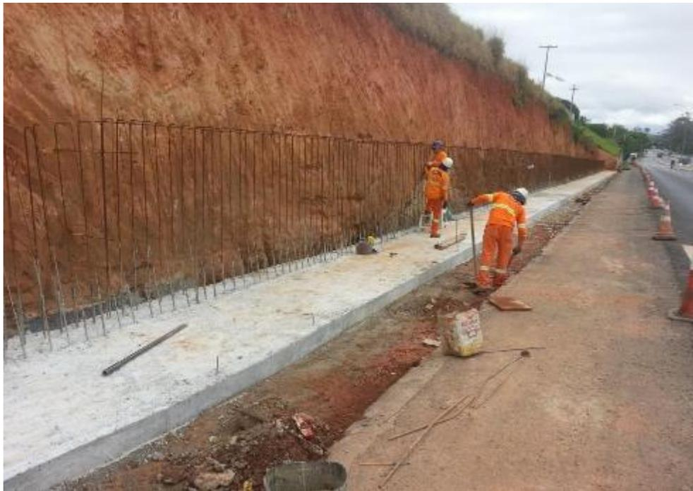
*Figura 01 – Execução do muro de contenção*
