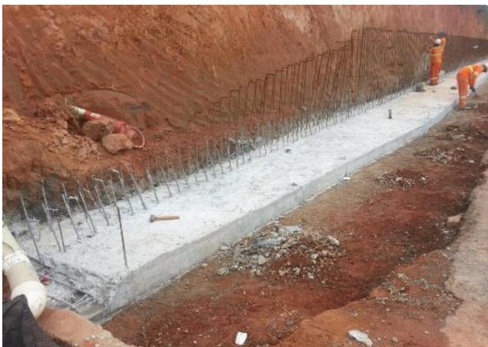
*Figura 02 – Execução do muro de contenção*
