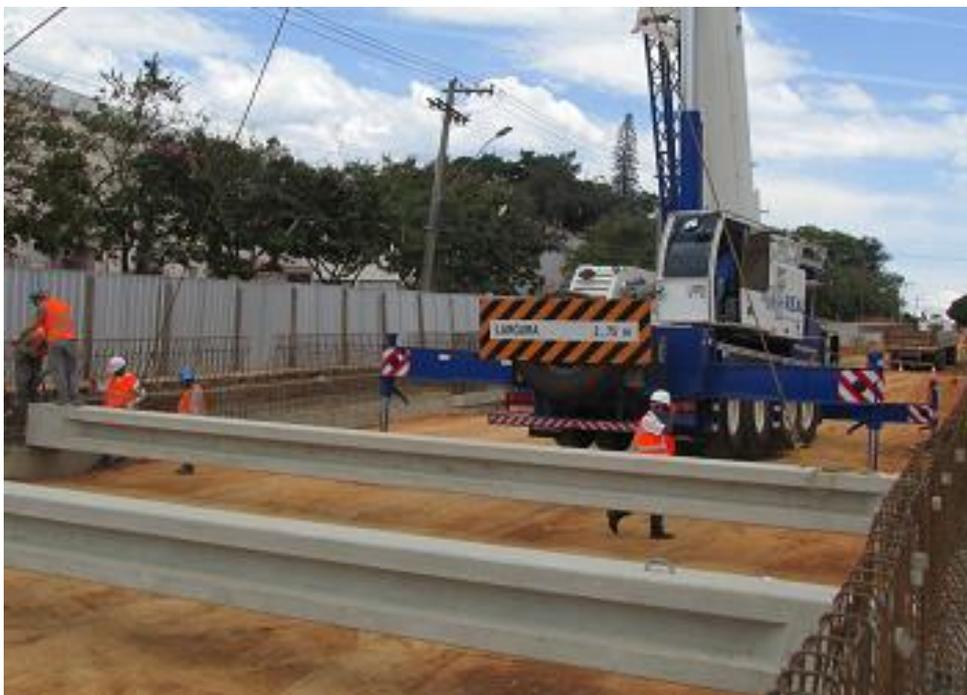
*Figura 04 – Lançamento de Estroncas*
