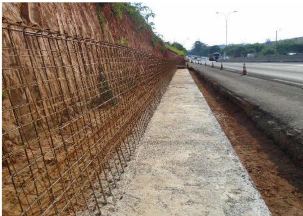
*Figura 06 – Execução do muro de contenção*
