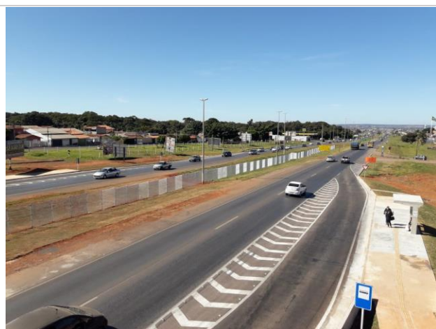
Foto 01: Tela antiofuscante instalada
