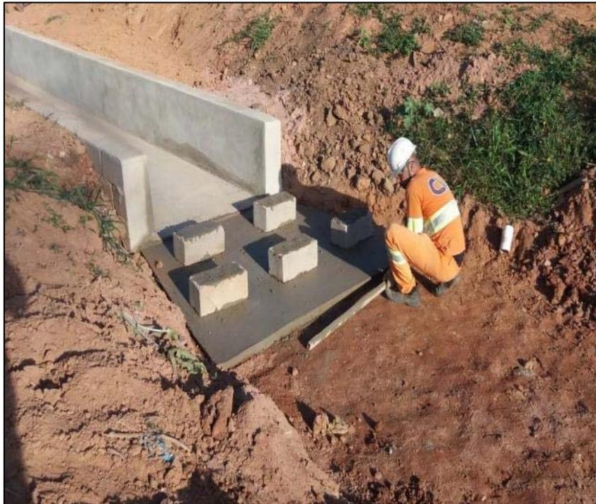
*Figura 03 – Execução de dispositivo de drenagem*
