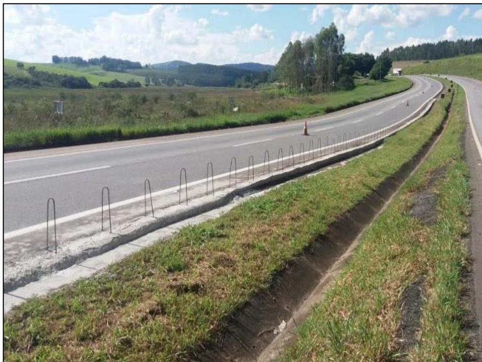
*Figura 01 – Execução da base e implantação de estrutura metálica*
