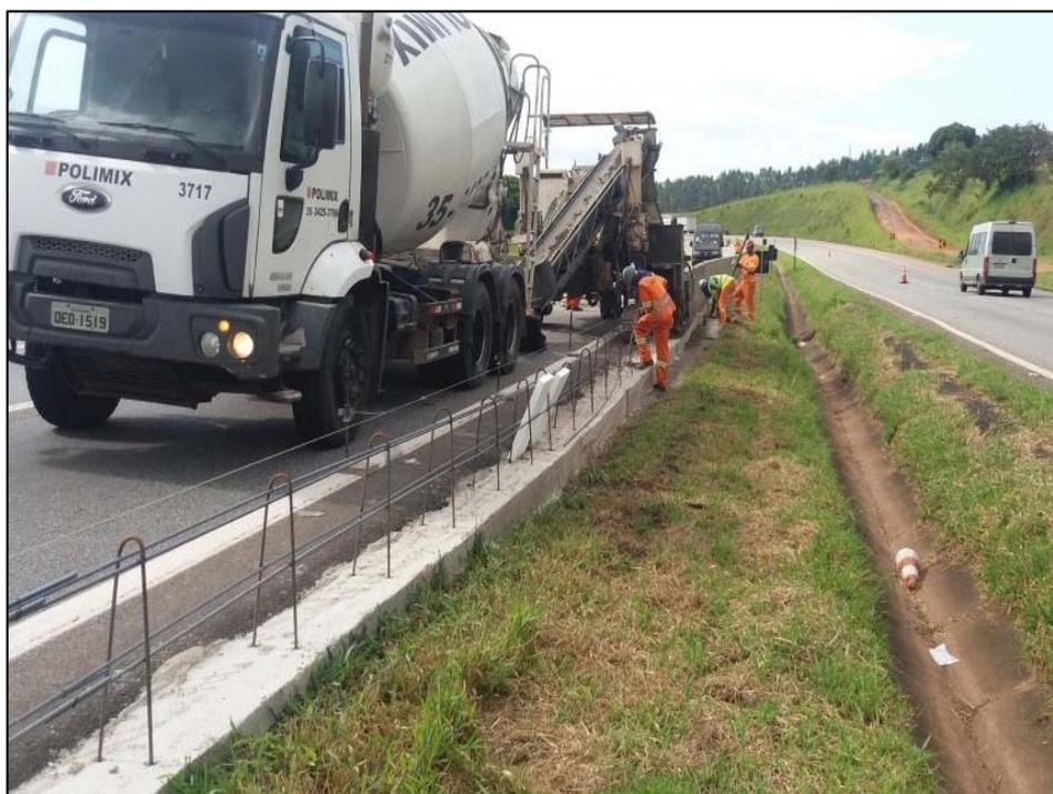
*Figura 02 – Concretagem da barreira*
