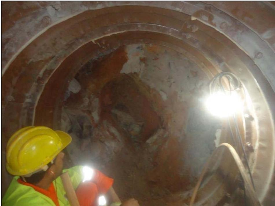
*Figura 05 – Execução do túnel liner*
