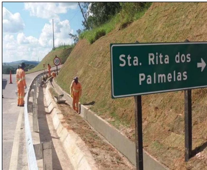
*Figura 02 – Execução de dispositivo de drenagem*
