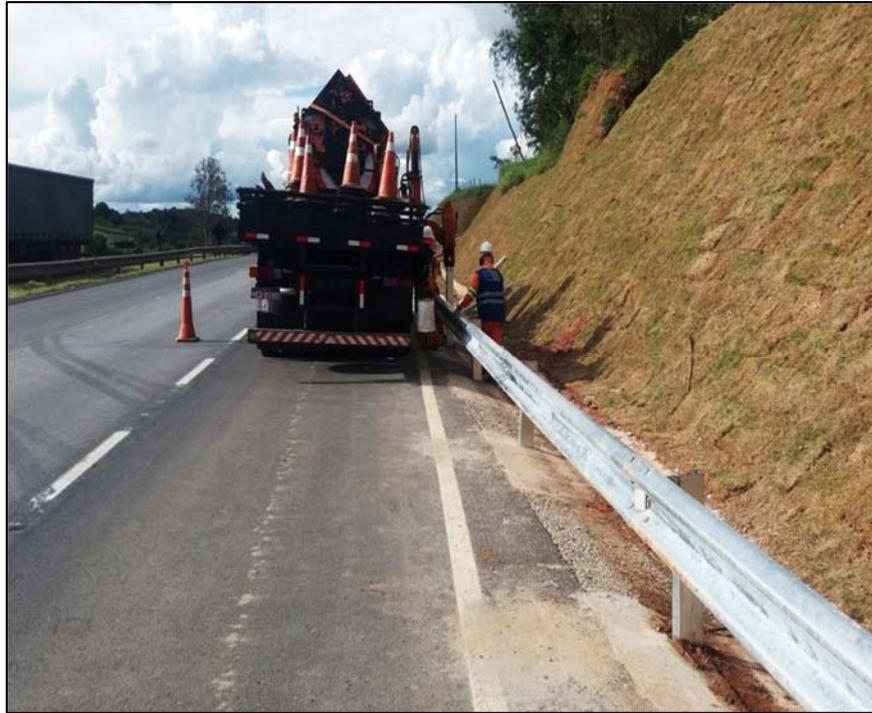
*Figura 01 – Instalação de defesa metálica*
