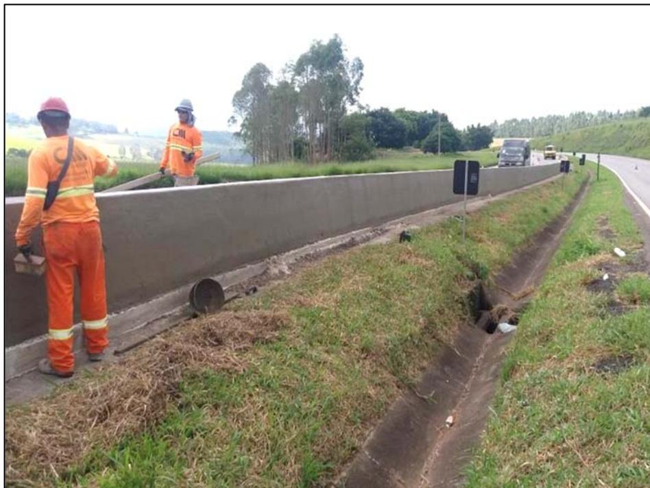
*Figura 03 – Concretagem da barreira*
