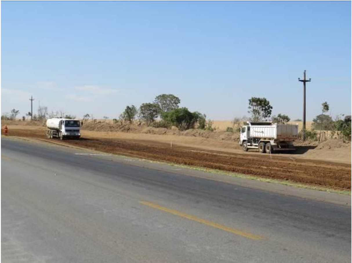
Imagem 12: Terraplanagem trecho 4 (duplicação)
