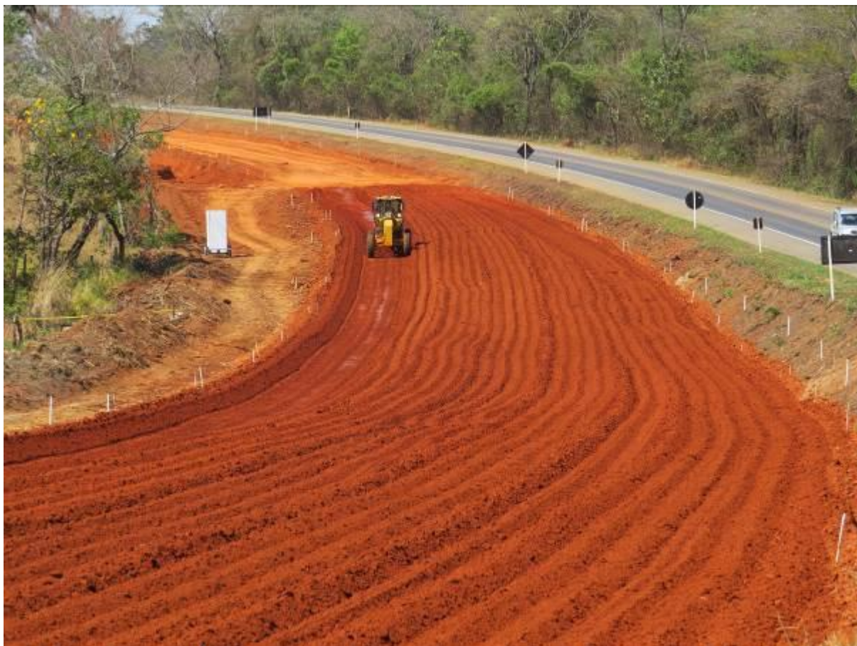
Imagem 10: Terraplanagem trecho 2 (duplicação)
