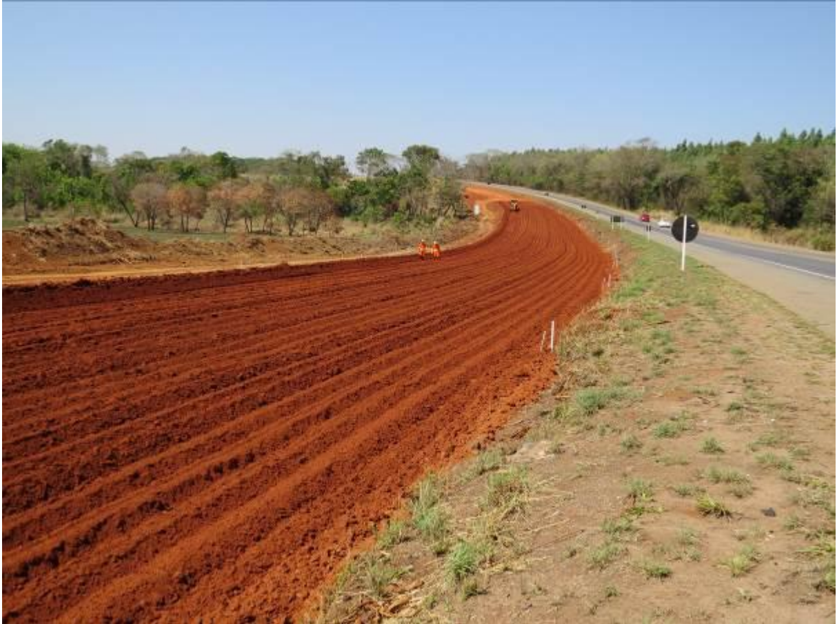
Imagem 9: Terraplanagem trecho 2 (duplicação)
