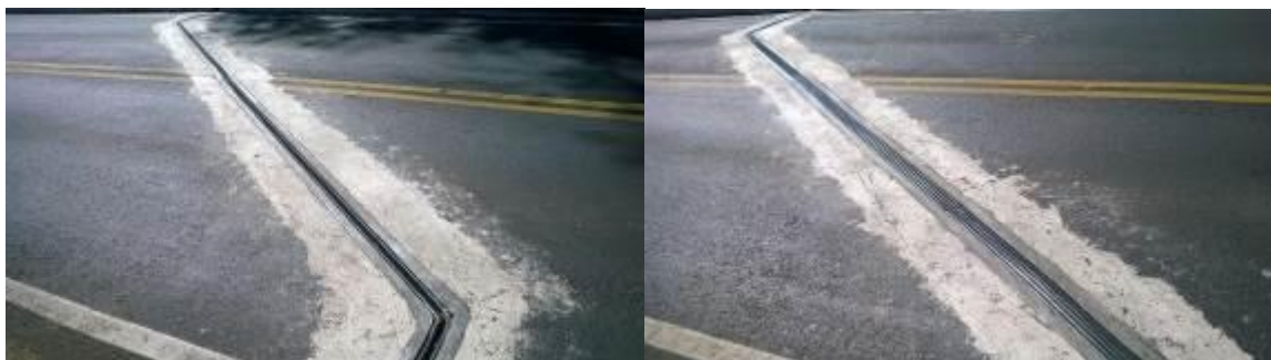
Imagem 7: Juntas de dilatação recuperadas do viaduto em Conselheiro Lafaiete (MG)
