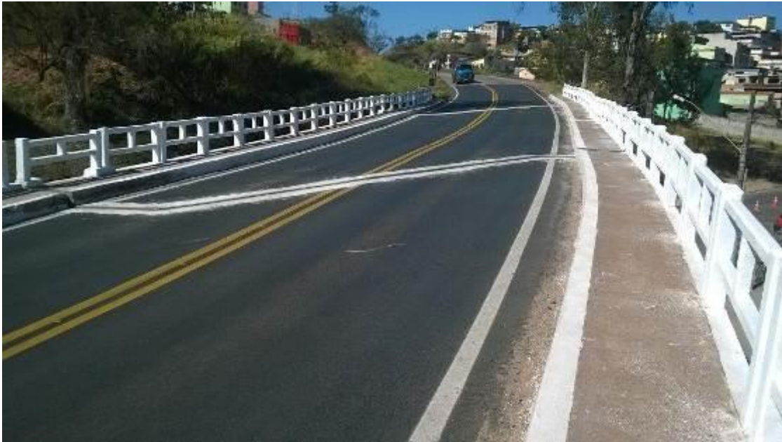
Imagem 5: Viaduto recuperado no Km 630 da rodovia, em Conselheiro Lafaiete (MG)
