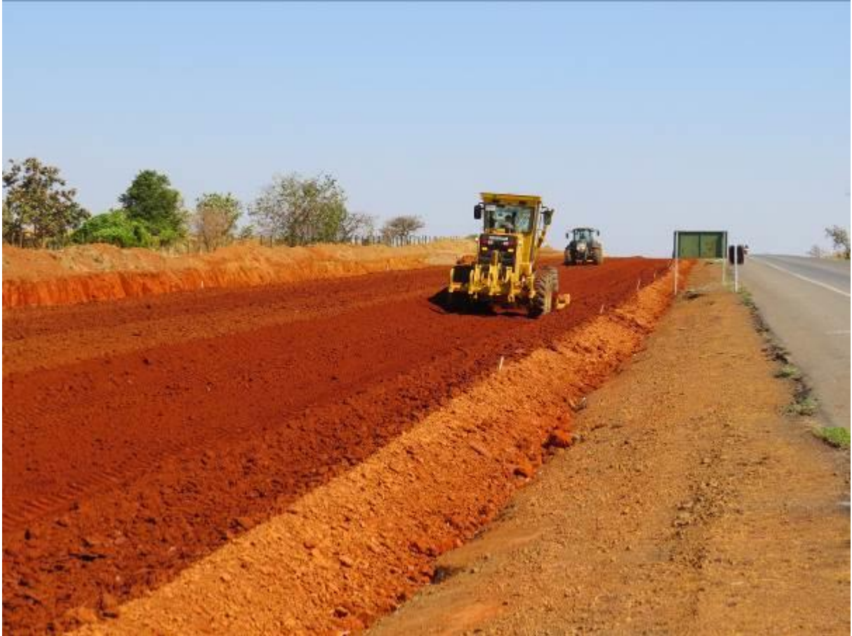
Imagem 11: Terraplanagem trecho 3 (duplicação)
