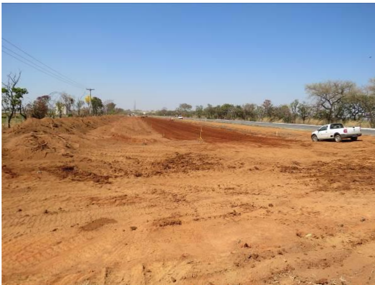
Imagem 8: Terraplanagem trecho 1 (duplicação)
