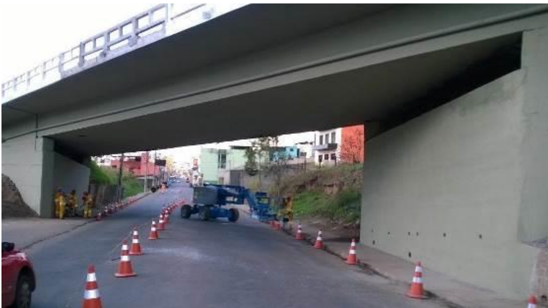
Imagem 6: O viaduto ganhou nova pintura, dentre outras melhorias
