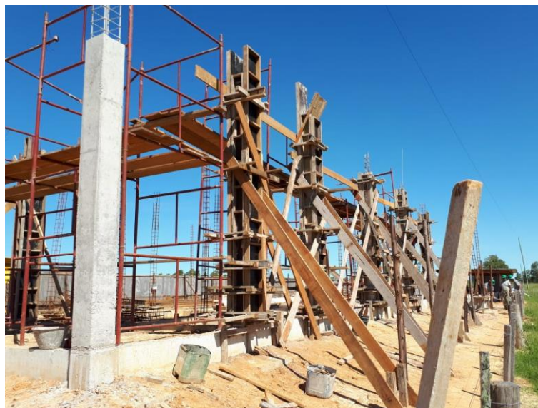
Figura 03 – Concretagem dos pilares – Base Operacional - BR-392/RS – Trecho: Pelotas – Rio Grande / km 033,059
