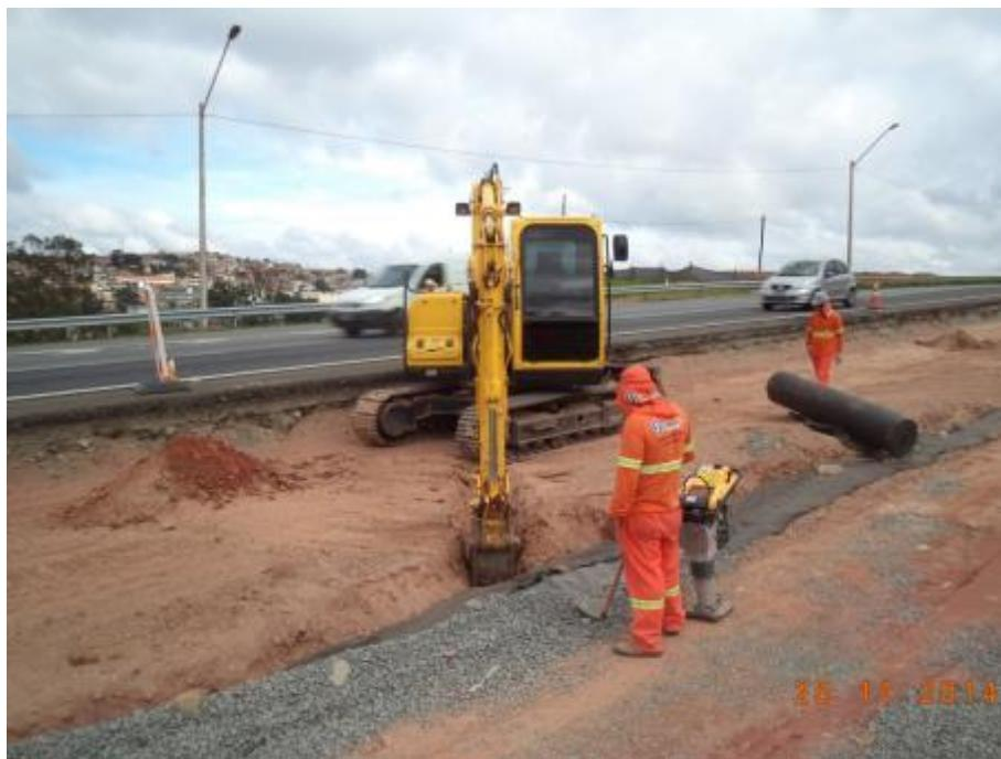
*Figura 35 – Execução dreno de pavimento*
