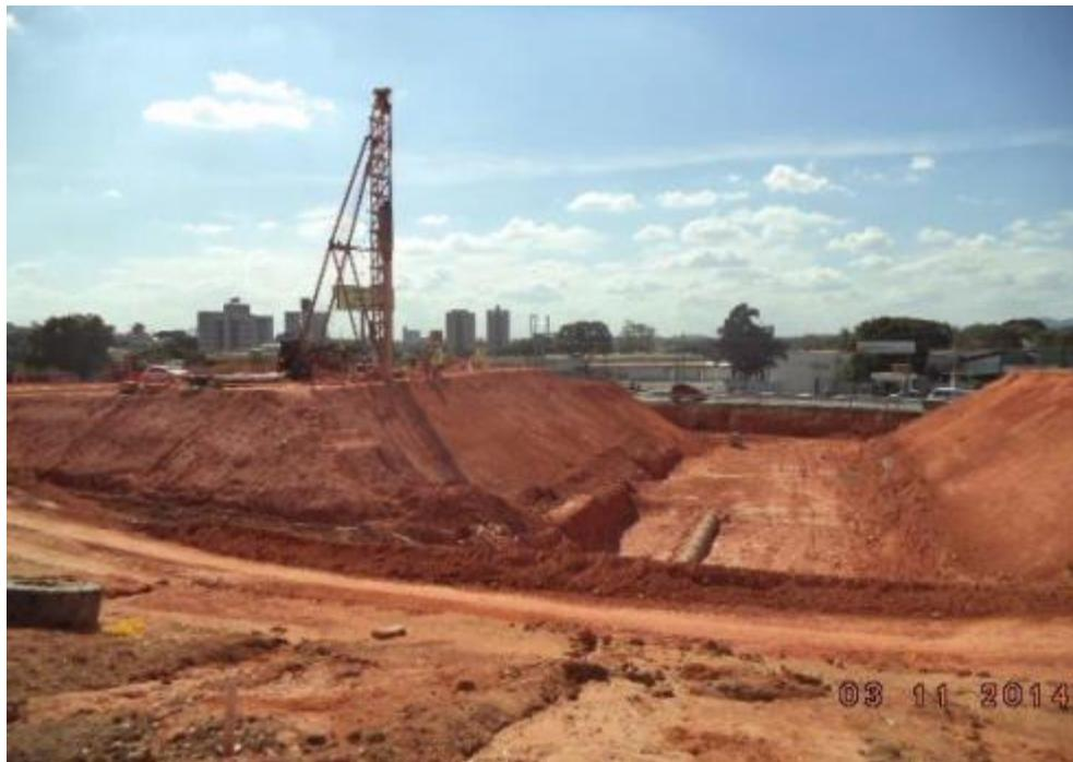
*Figura 10 – Tratamento e compactação de sub leito*
