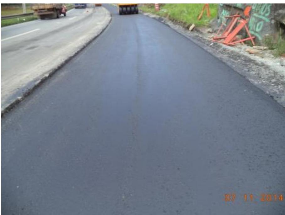
Figura 15 – Aplicação da camada de binder no Km 921,9 ao 921,58
