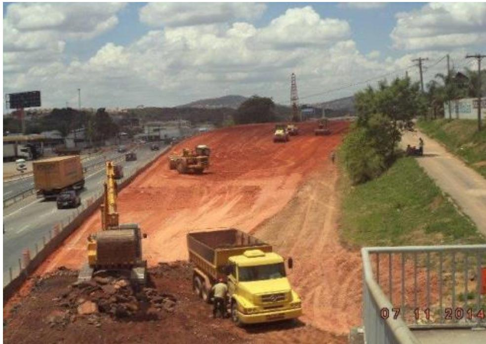
*Figura 08 – Tratamento e compactação de sub leito*
