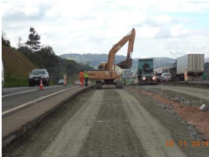
*Figura 28 – Travamento da camada de base com bica corrida*
