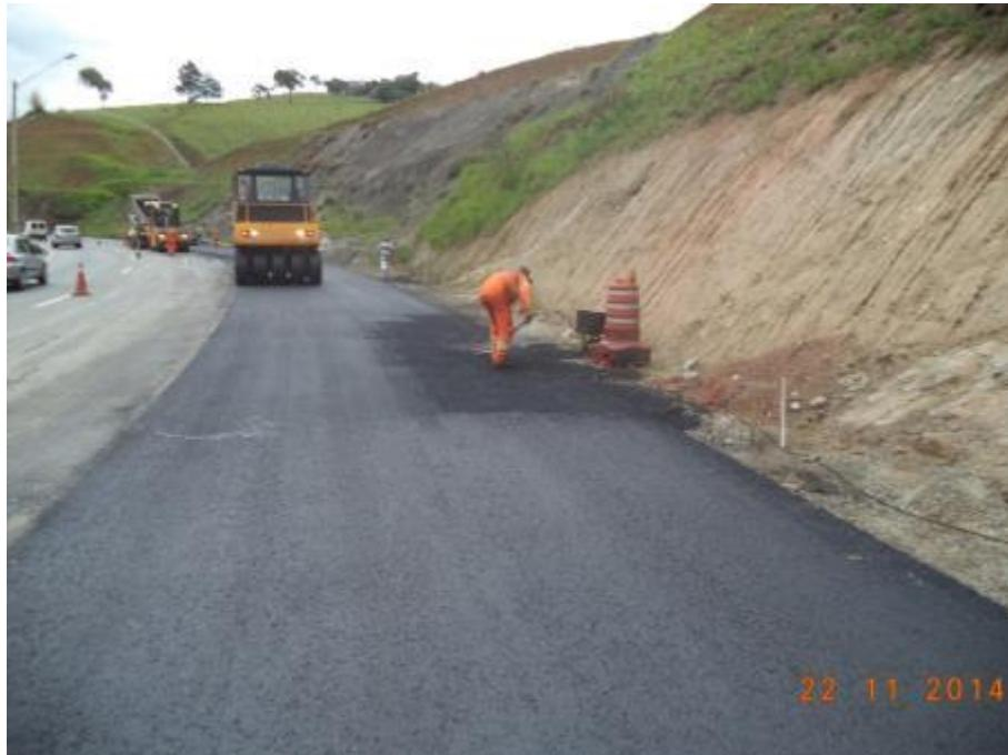
Figura 18 – Aplicação da camada de capa no Km 921,85 ao 921,62
