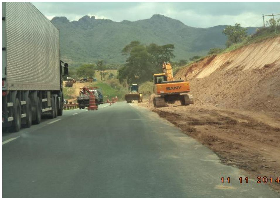
*Figura 23 – Lançamento e compactação de base*
