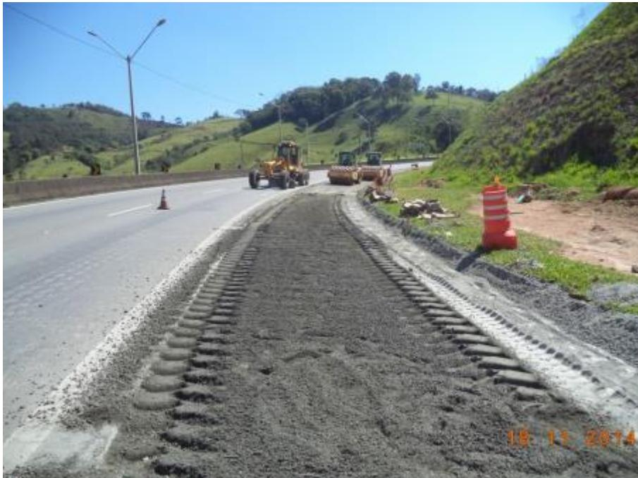
*Figura 16 – Pintura de ligação da base reciclada no Km 921,14 ao 920,95*
