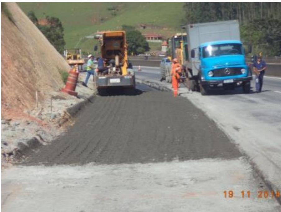
*Figura 17 – Compactação da camada BGTC - Km 922 ao 921,16*
