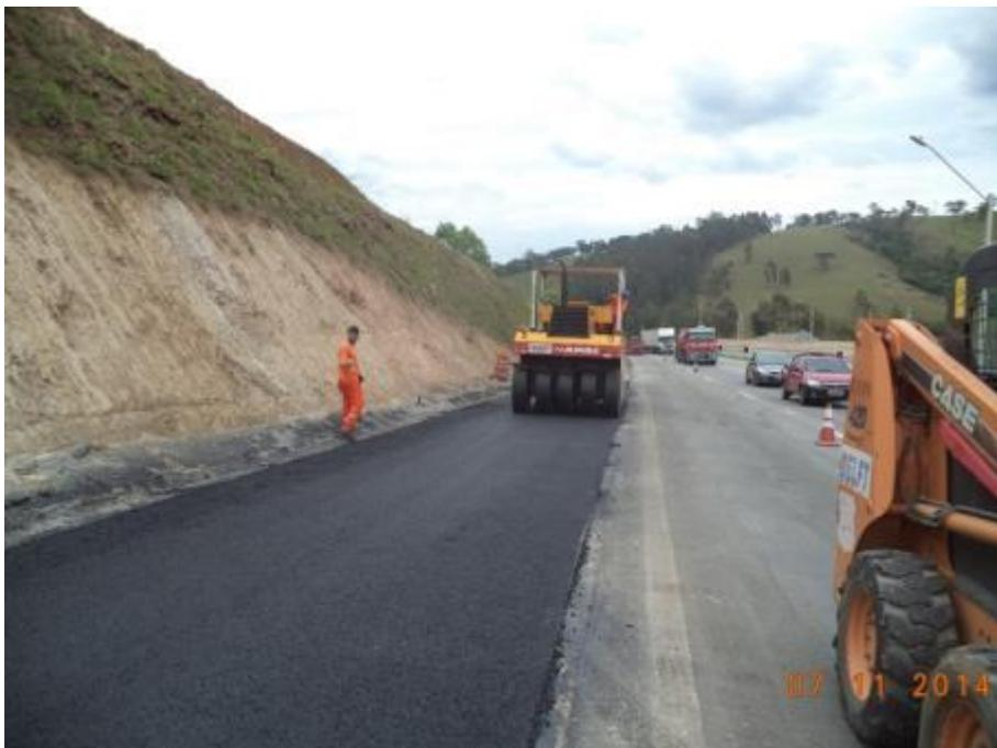
Figura 14 – Aplicação da camada de binder no Km 921,9 ao 921,58
