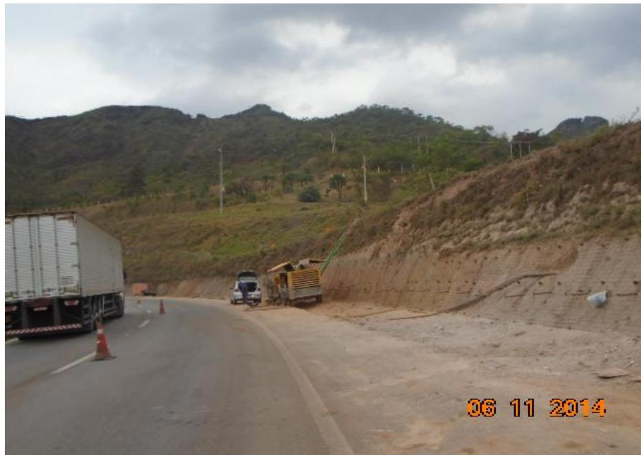
*Figura 22 – Lançamento e compactação de base*
