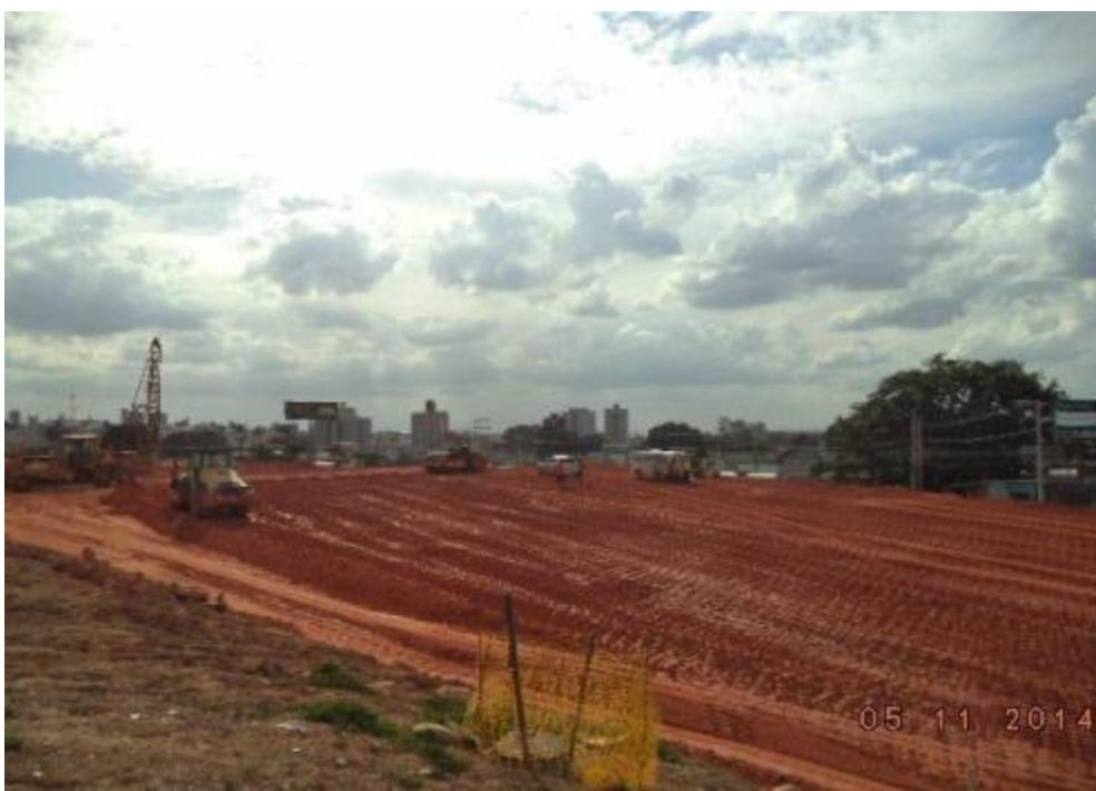
*Figura 09 – Reforço de sub leito e lançamento de base*
