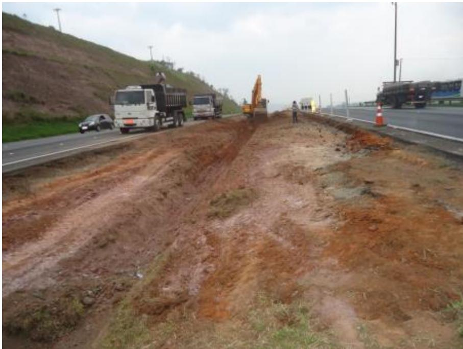
*Figura 32 – Limpeza para execução da obra*
