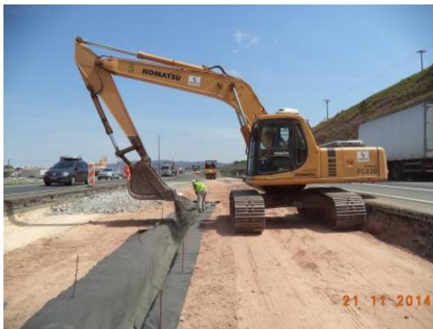
*Figura 31 – Execução de dreno de pavimento - Km 41,400*
