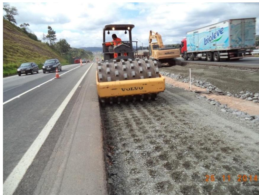
*Figura 29 – Compactação da camada de base*
