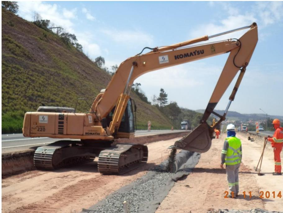
*Figura 30 – Execução de dreno de pavimento*
