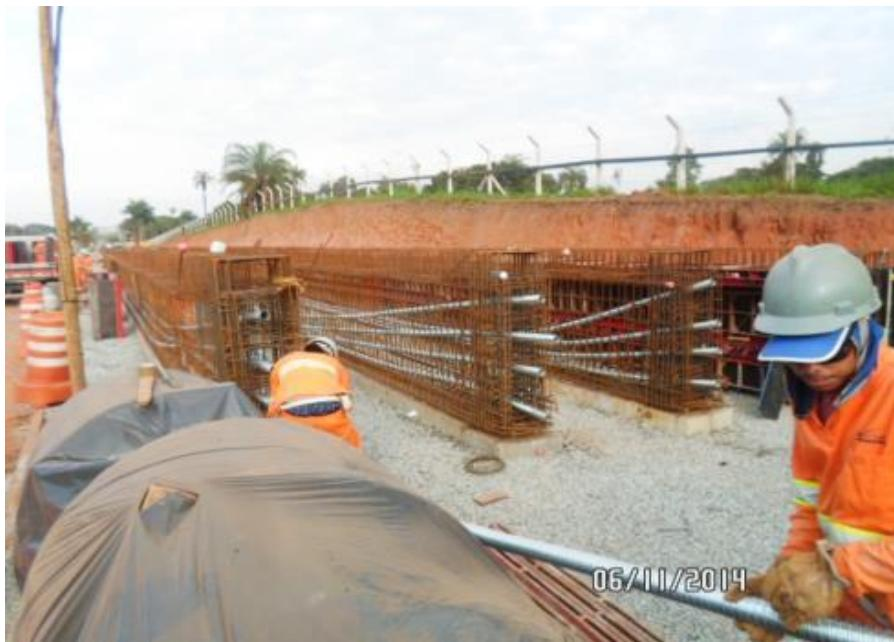
*Figura 02 – Montagem de ferragens de viga*
