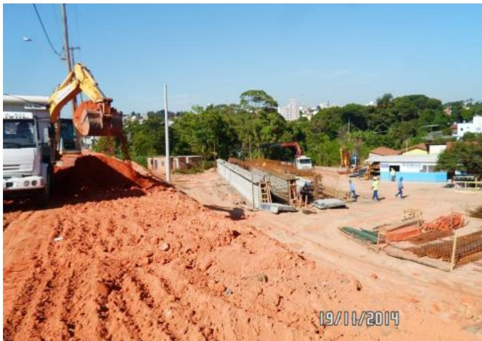
*Figura 11 – Tratamento e compactação de sub leito*
