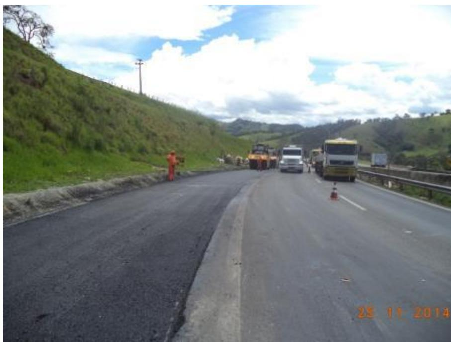
Figura 19 – Aplicação da camada de capa no Km 921,85 ao 921,62
