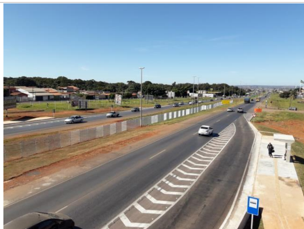
Foto 01: Tela antiofuscante instalada
