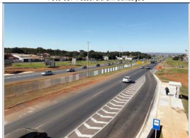
Foto 04: Baía Sul e abrigo finalizados
