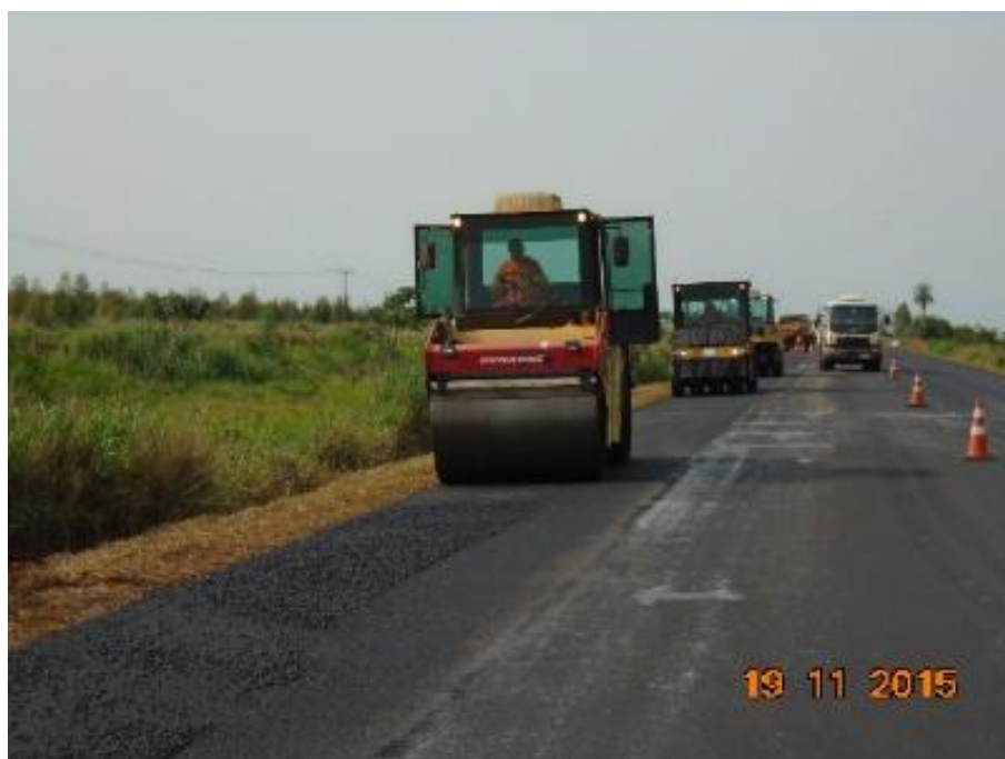
Figura 30 – Lote 2 – Restauração km 354 ao Km 355
