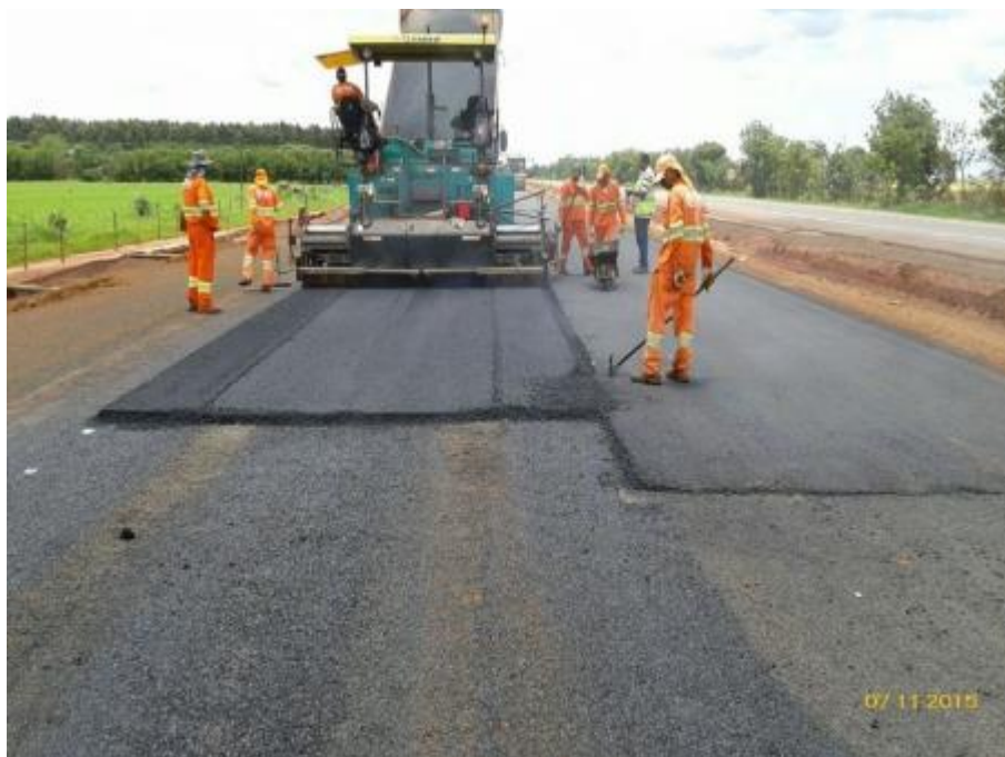
Execução de 1ª camada de CBUQ
