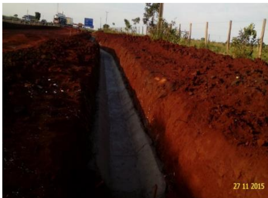
Execução de VCP
