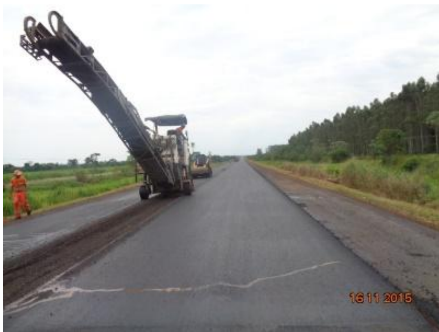
Execução da restauração
