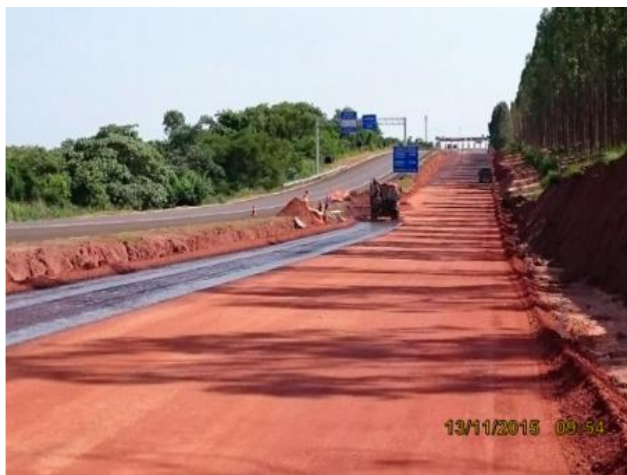
Imprimação de sub-base
