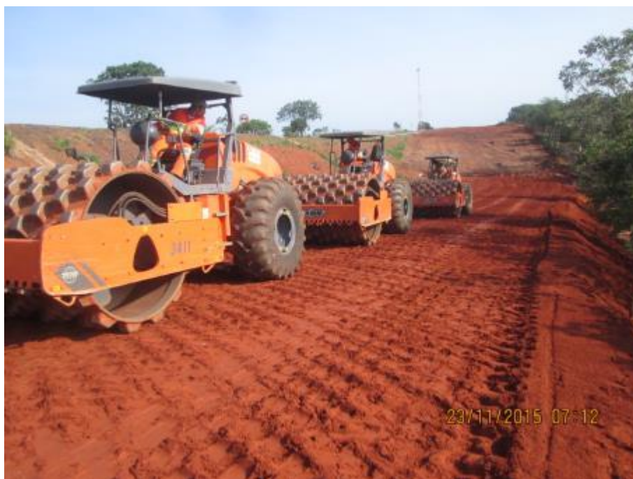
Compactação de 7ª camada de aterro
