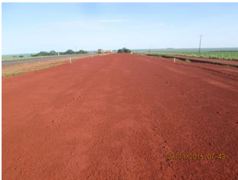
Execução da 3ª CFT
