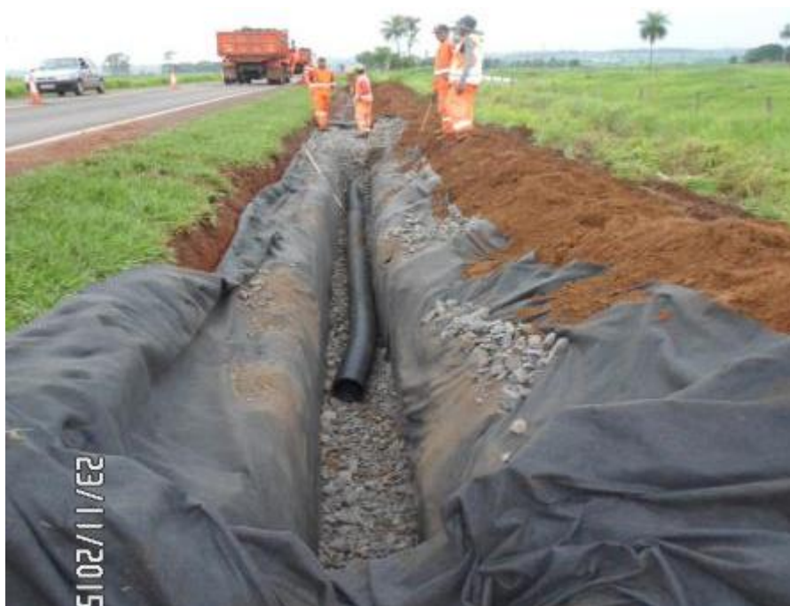
Execução de dreno
