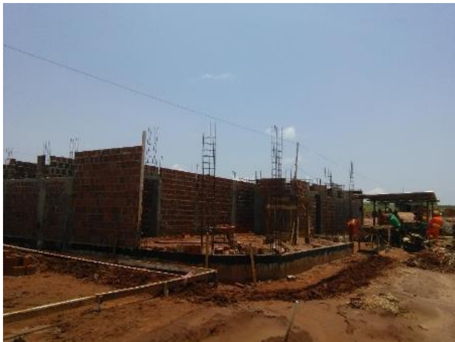
Execução da alvenaria
