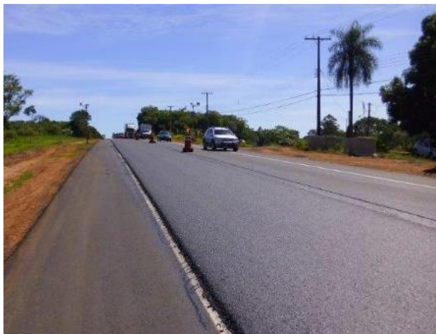
Execução da restauração
