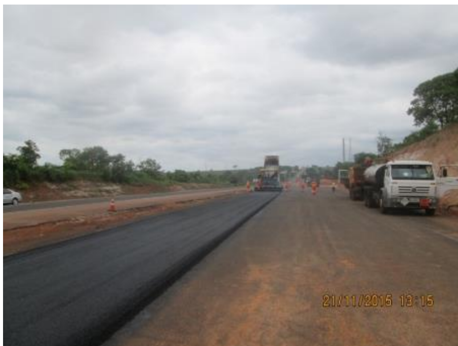
Execução de 1ª Camada de CBUQ
