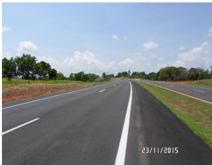
Execução da restauração
