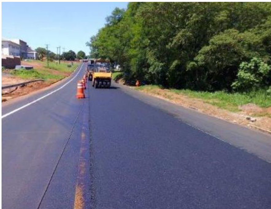
Execução da restauração
