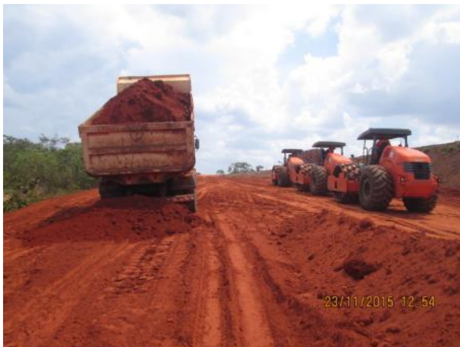
Execução de terraplenagem
