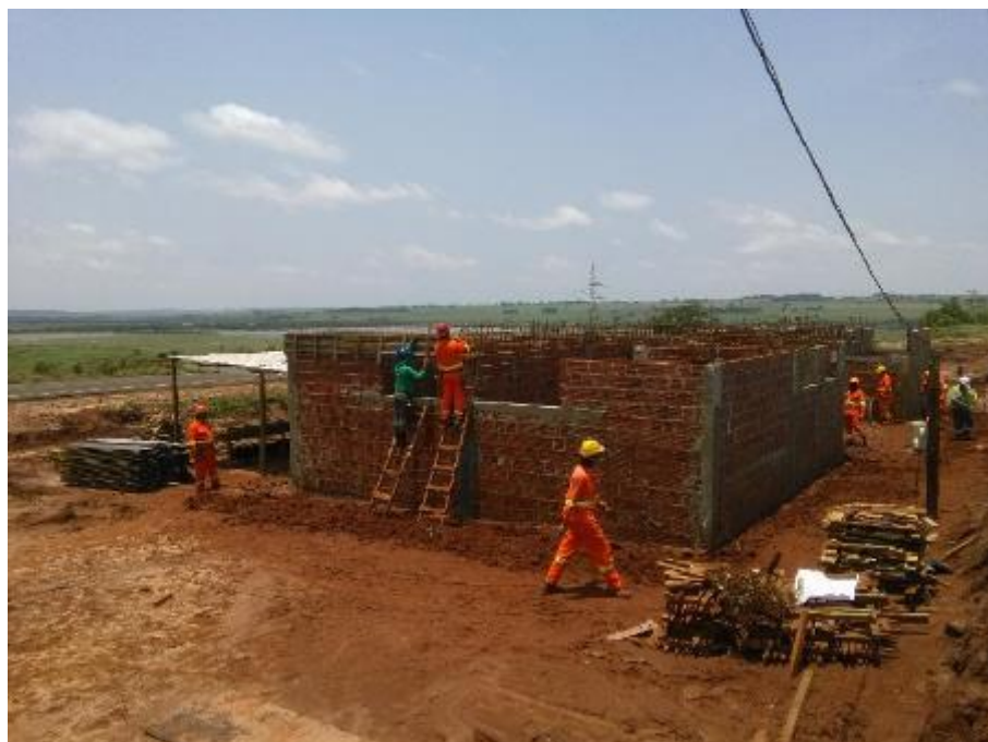
Execução das vigas Prédio da PRF
