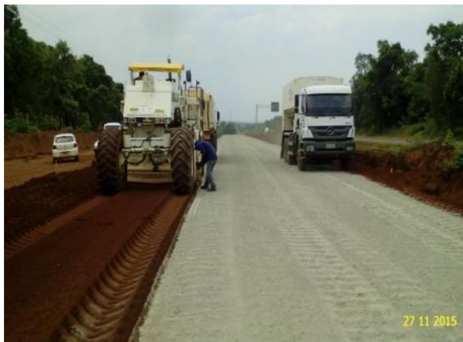
Incorporação de cimento à sub-base
