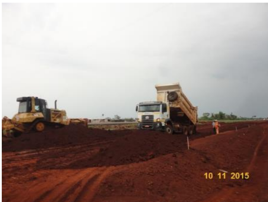
Execução de 1º CFT
