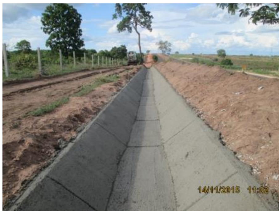
Execução de VPC
