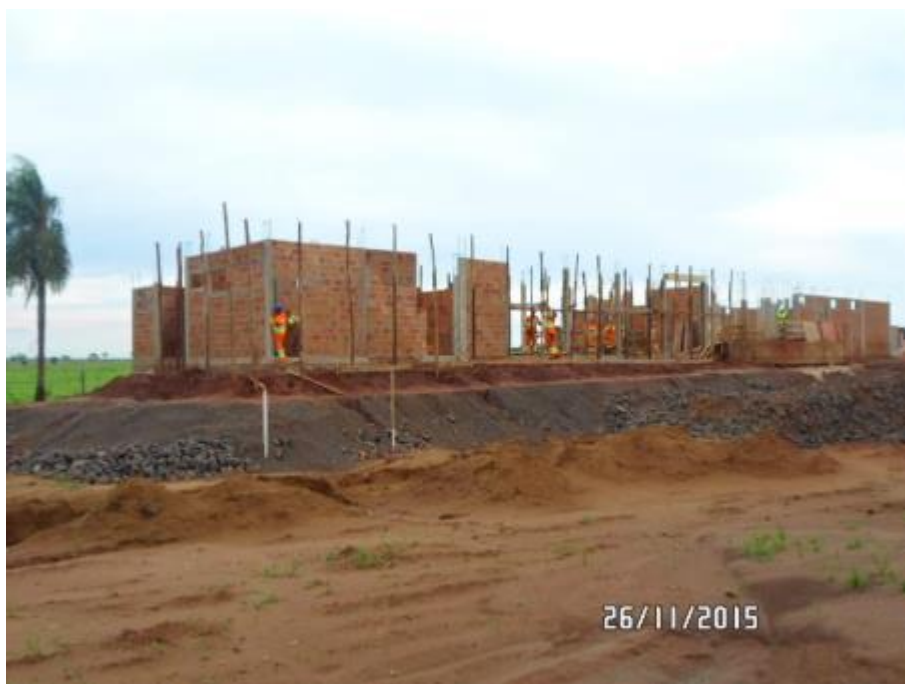
Execução das paredes e escora de laje
