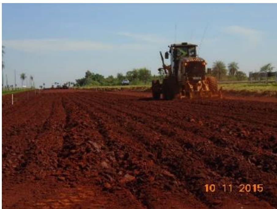
Execução de aterro
