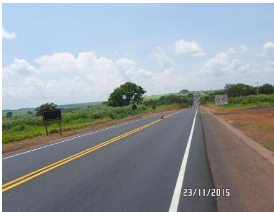
Execução da restauração
