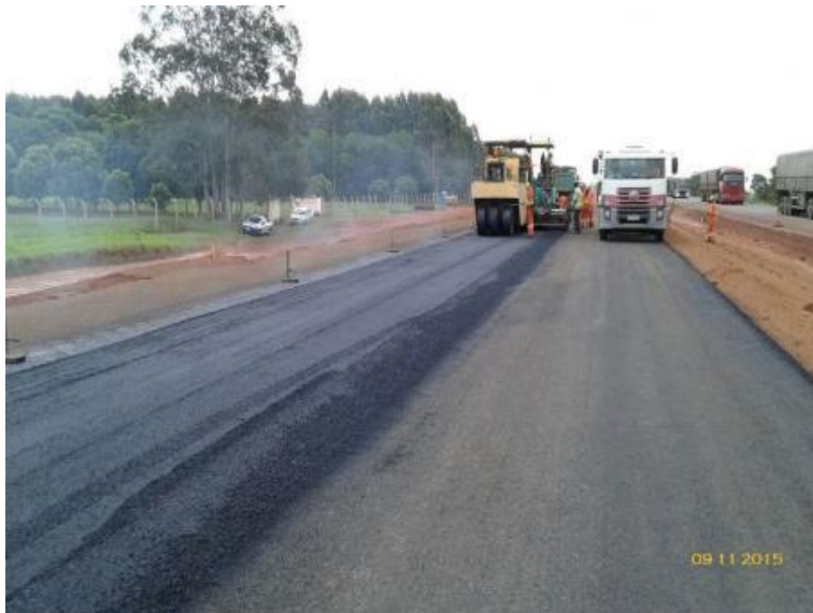
Execução de 1ª camada de CBUQ
