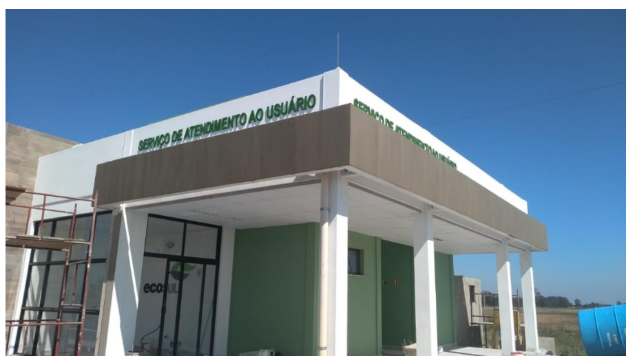
Figura 03 – Fase final de obra – Base Operacional - BR-392/RS – Trecho: Pelotas – Rio Grande / km 033,059
