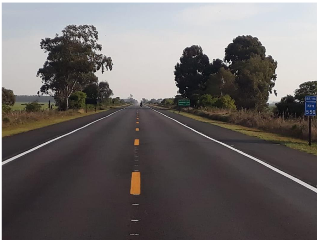
Figura 02 – Serviços de Pavimentação e Sinalização Horizontal BR-116/RS – Trecho: Pelotas – Jaguarão / km 550,000
