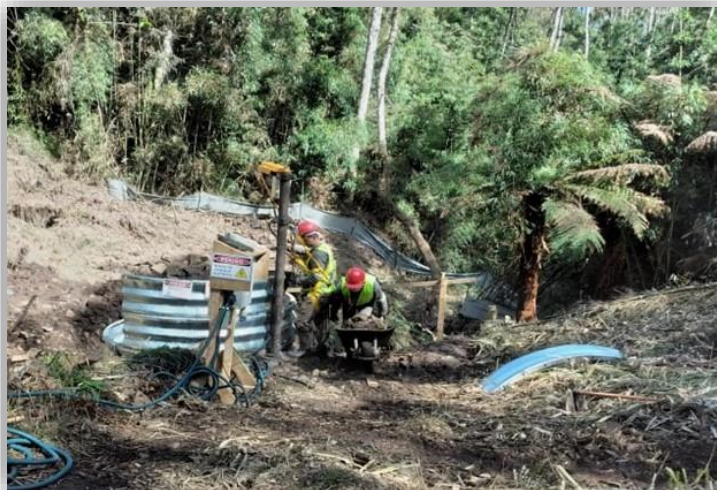
Figura 01 – Execução de Terceiras Faixas – km 115,265 ao 117,720 - Início da recuperação de Obra de Arte Corrente – OAC km117,360
