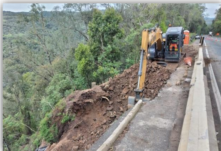
Figura 03 - Execução de estabilização de talude na BR-116/SC km303+900 pista norte – (em fase de início da execução)
