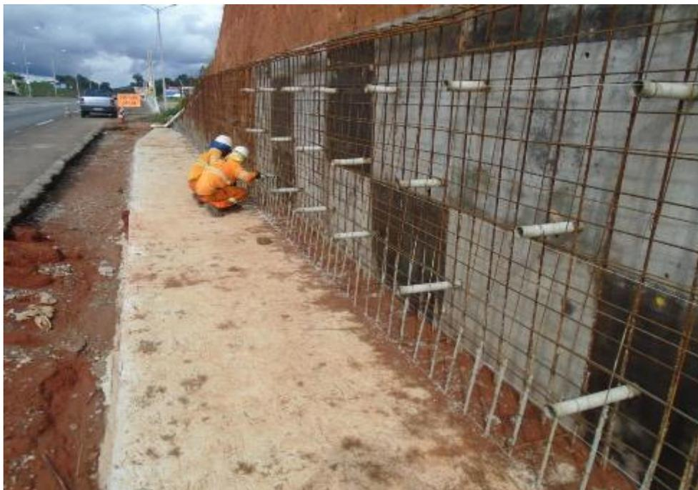
*Figura 04 – Montagem das armações e formas*
