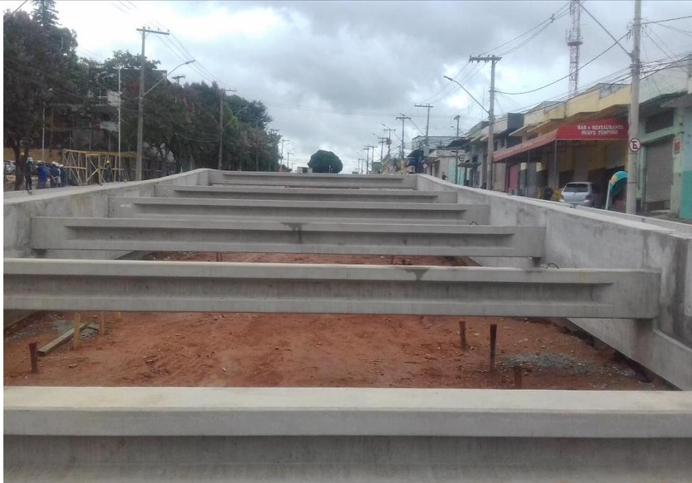
*Figura 05 – Estroncas Instaladas*
