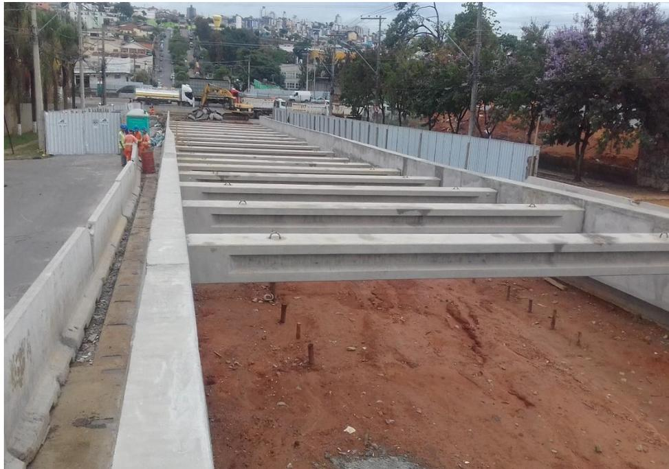
*Figura 01 – Estroncas Instaladas*
