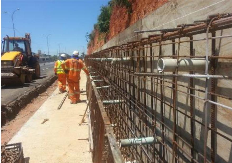
*Figura 03 – Montagem das armações e formas*
