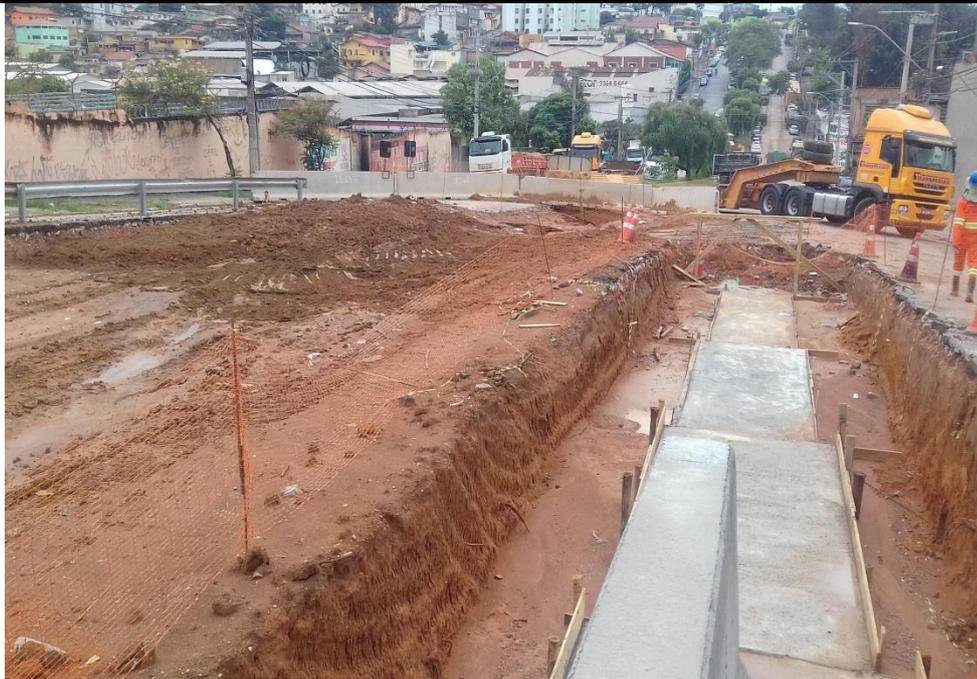
*Figura 03 – Muro de arrimo*
