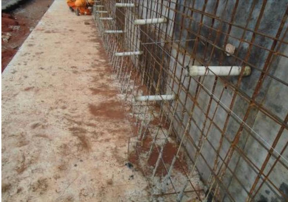
*Figura 05 – Montagem das armações e formas*
