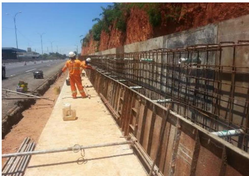
*Figura 02 – Montagem das armações e formas*
