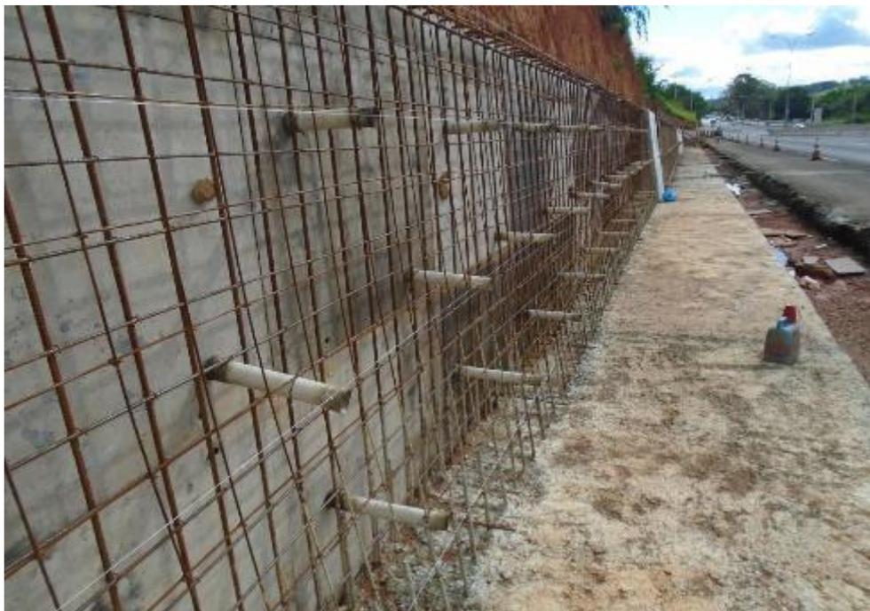
*Figura 06 – Montagem das armações e formas*
