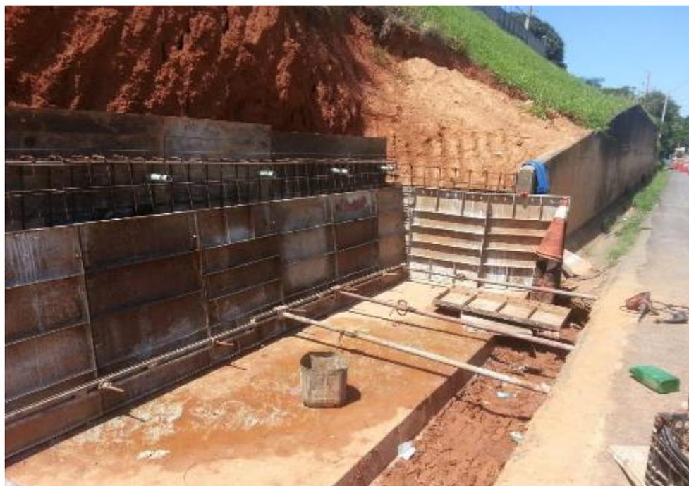
*Figura 01 – Montagem das armações e formas*
