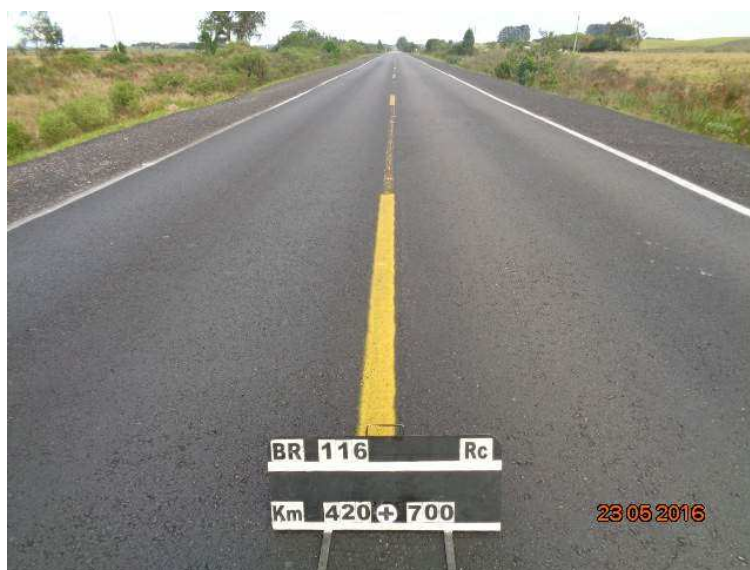
Figura 05 – Recuperação do Pavimento – BR-116/RS
