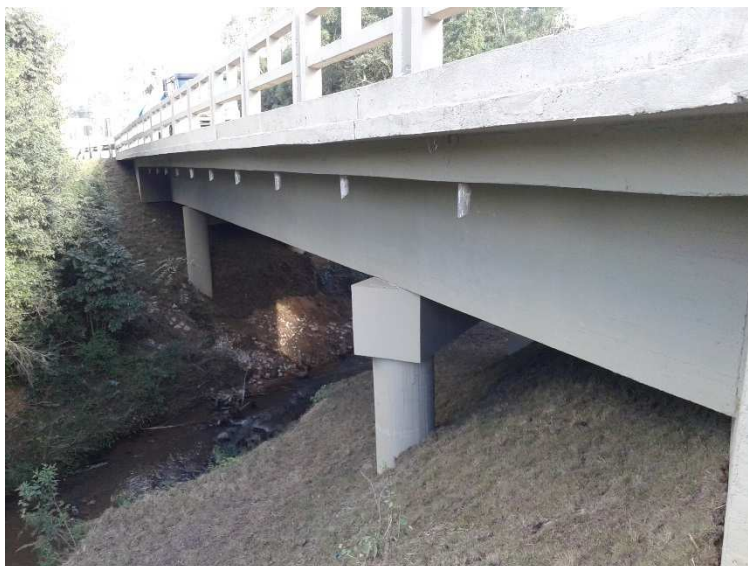
Figura 02 – Recuperação da Ponte sobre o Rio Canguçu – BR-392/RS
