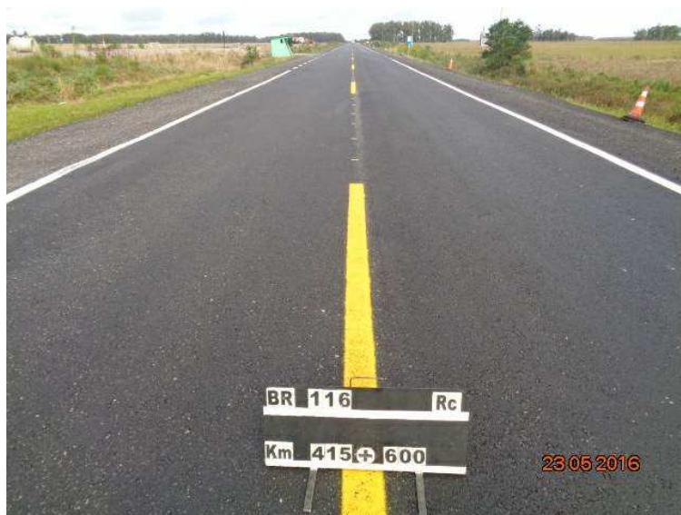
Figura 04 – Recuperação do Pavimento – BR-116/RS
