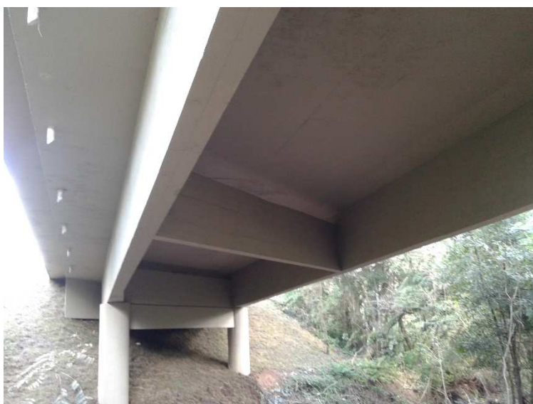
Figura 03 – Recuperação da Ponte sobre o Rio Canguçu – BR-392/RS
