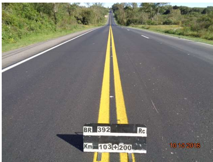
Figura 03 – Recuperação do Pavimento – BR-392/RS
