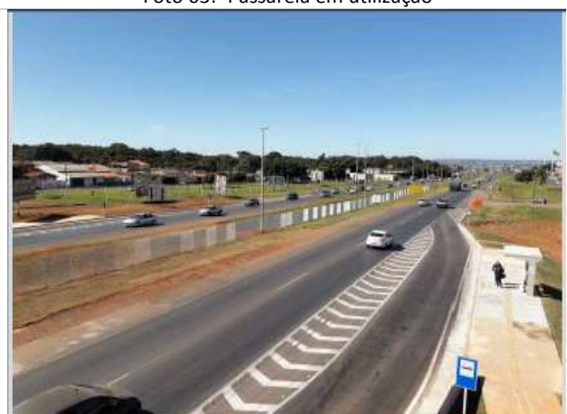
Foto 04: Baía Sul e abrigo finalizados
