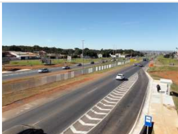
Foto 01: Tela antiofuscante instalada
