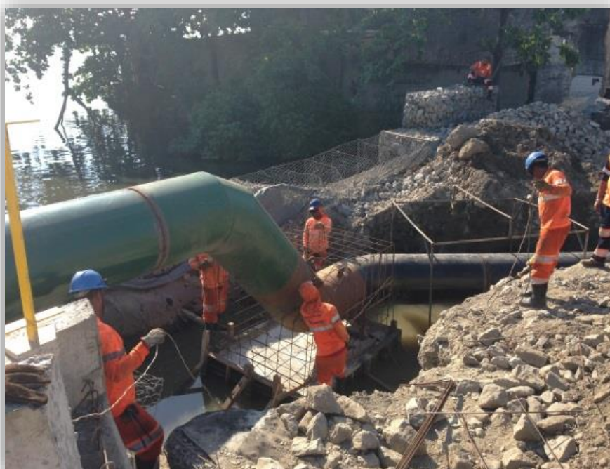
Figura 03 – Remanejamento da adutora
