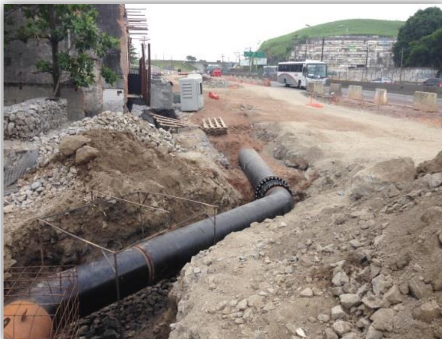
Figura 02 – Remanejamento da adutora
