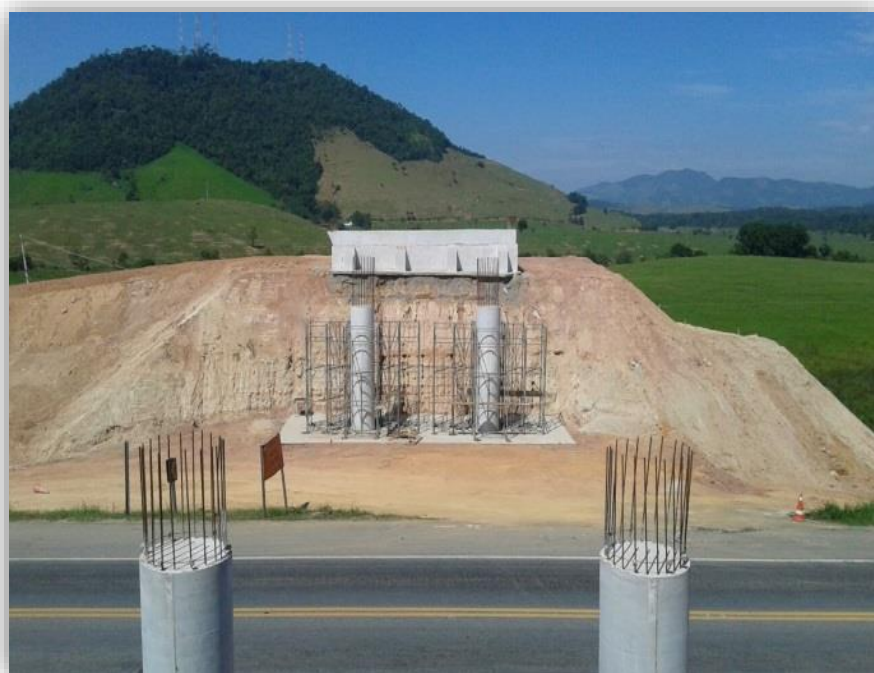
Figura 15 – Vista apoios – Obra de Arte Especial - km 253,600
