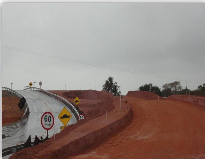
Figura 13 – Lançamento de sub-leito do Trevo em Desnível - km 138,500
