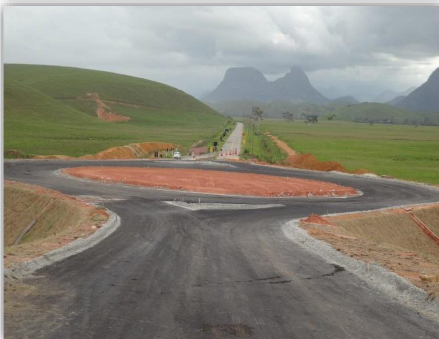
Figura 12 – Imprimação de base do Trevo em Desnível - km 125,000
