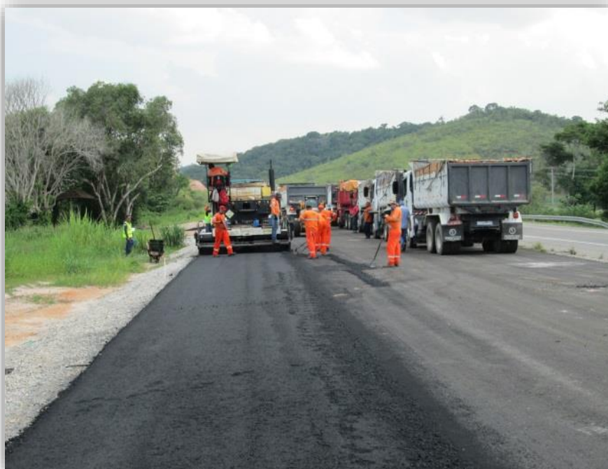
Figura 08 – Execução de capa do acostamento
