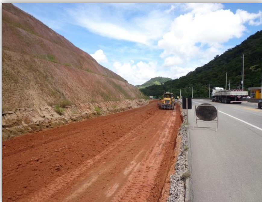
Figura 07 – Execução camada final
