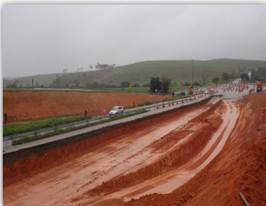
Figura 14 – Rebaixo de pista existente – Trevo em Desnível - km 144,500
