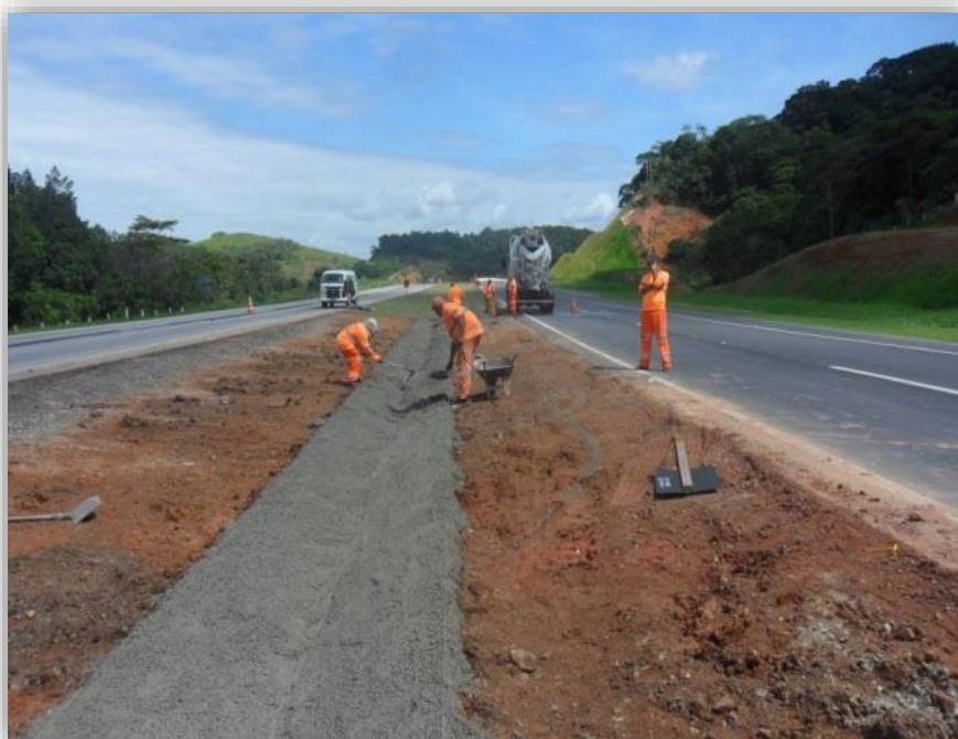
Figura 09 – Execução de sarjeta - Canteiro Central
