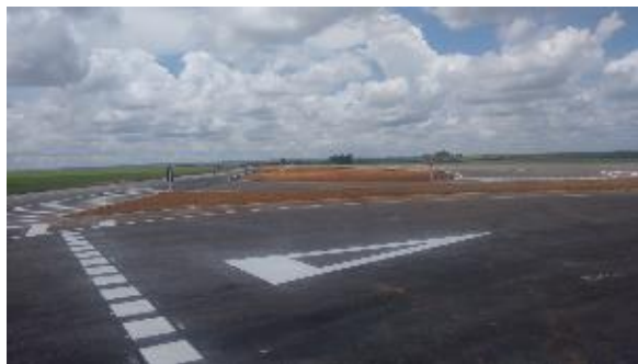
Retorno em Nível - Km 120+700/GO: Sinalização horizontal e vertical da ilha
