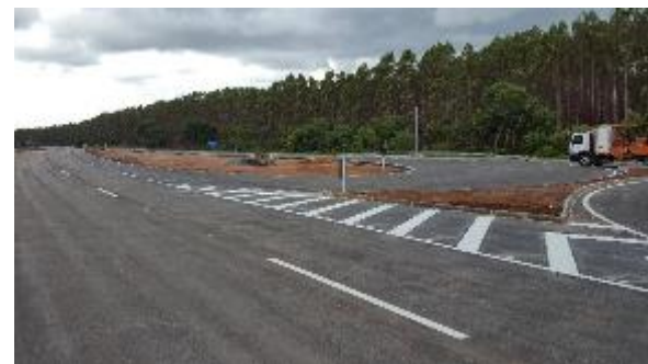
Retorno em Nível - 172+000/MG: Sinalização horizontal das faixas de rolamento – Pista Sul
