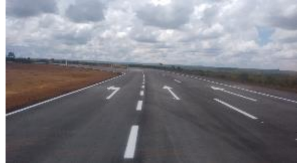
Retorno em Nível - Km 115+000/GO: Sinalização horizontal das faixas de rolamento e taper de desaceleração – Pista Norte
