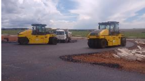
Retorno em Nível – Km 71+300/GO: Compactação das alças do retorno
