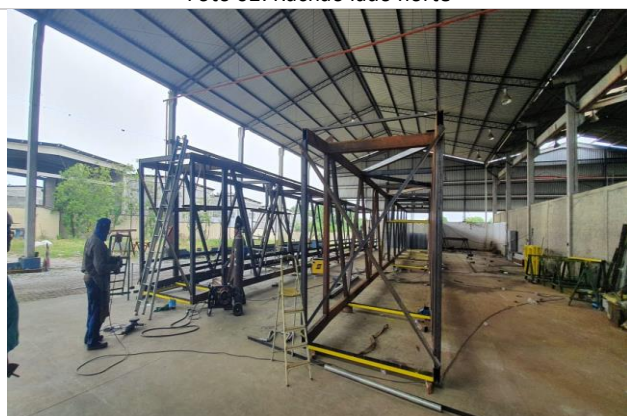
Foto 04: Execução da travessia
