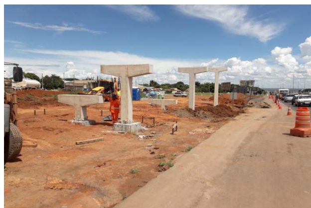
Foto 05: Lançamento dos pilares Norte
