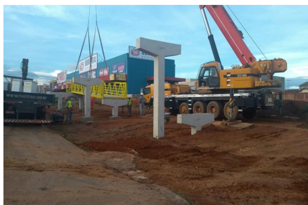
Foto 06: Montagem Rampa Norte
