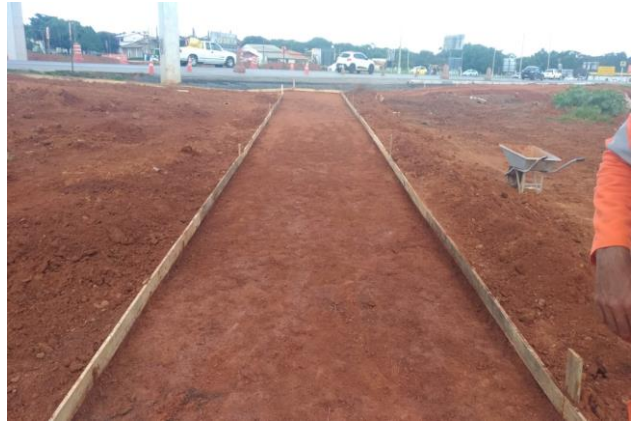
Foto 08: Execução da calçada lado norte
