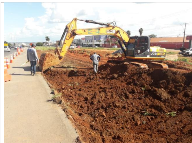
Foto 01: Escavação lado sul
