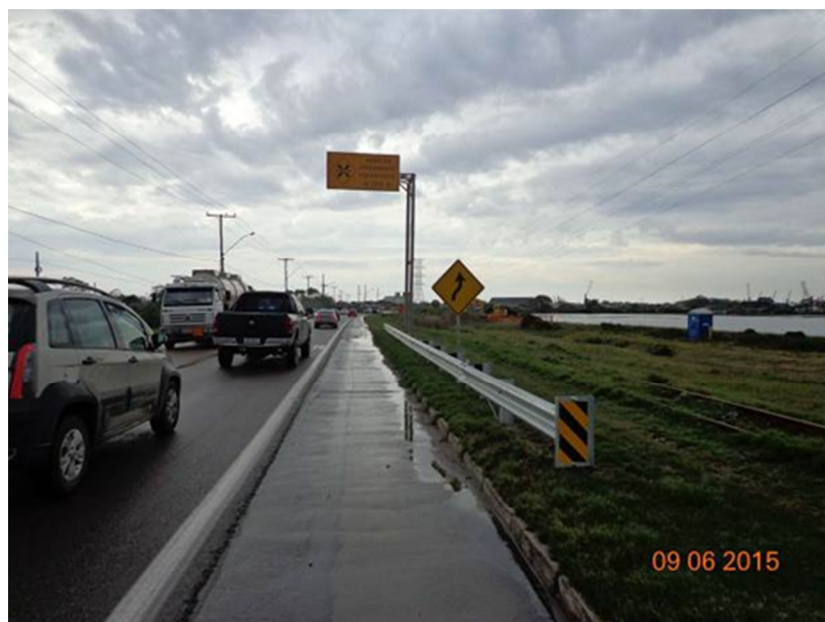
Figura 07 – Defensas metálicas – BR-392/RS
