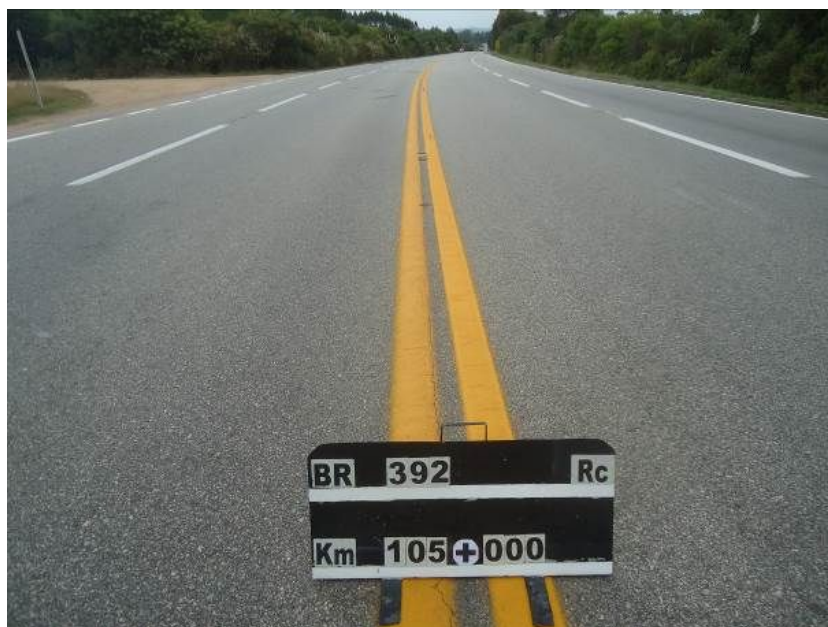
Figura 02 – Manutenção do Pavimento – BR-392/RS
