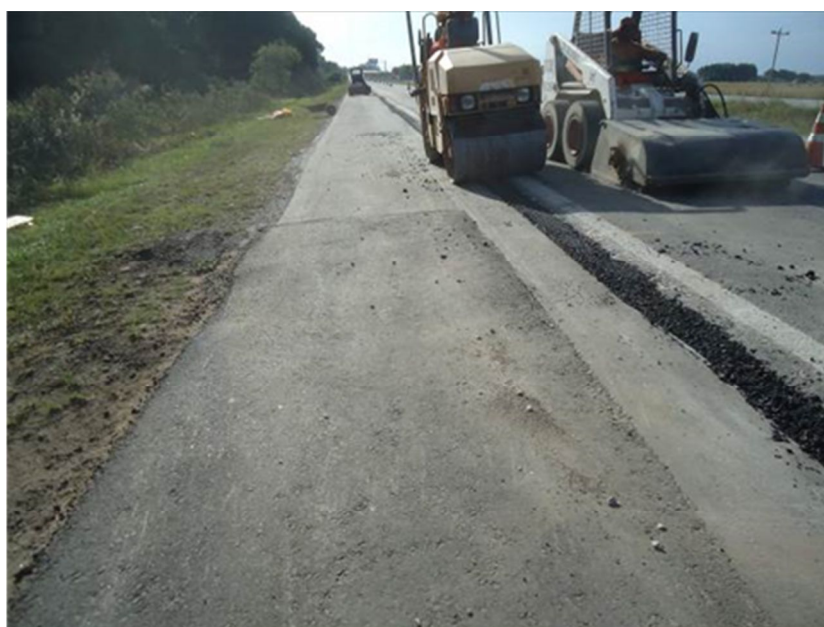
Figura 05 – Implantação drenos de pavimento – BR-116/RS
