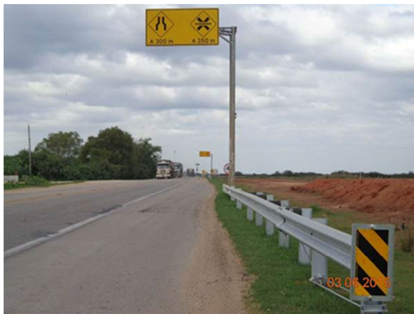
Figura 06 – Defensas Metálicas – BR-392/RS
