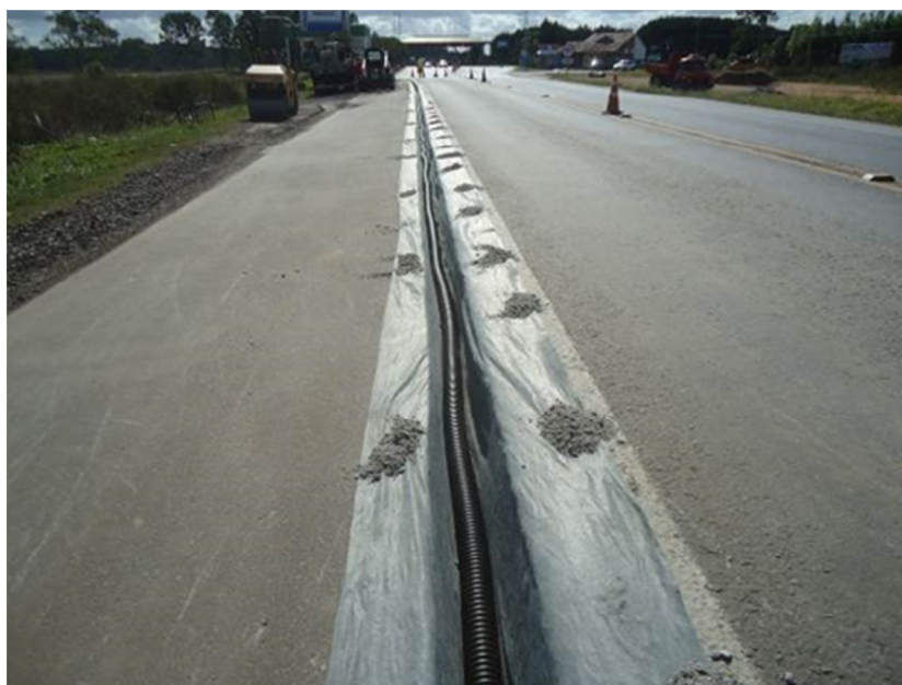
Figura 04 – Implantação drenos de pavimento – BR-116/RS
