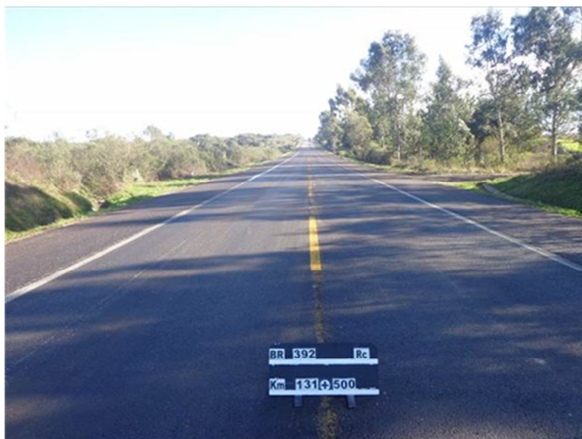
Figura 03 – Manutenção do Pavimento – BR-392/RS
