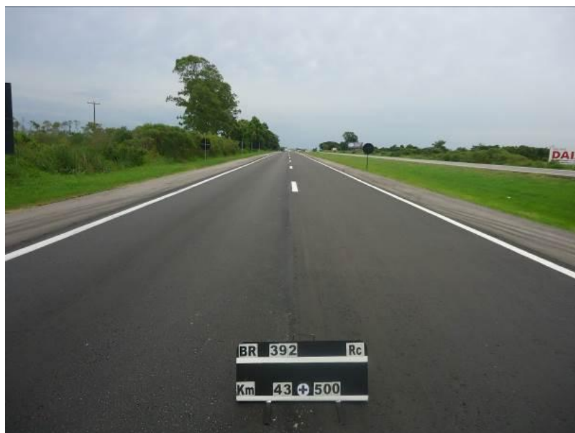
Figura 02 – Manutenção do Pavimento – BR-392/RS
