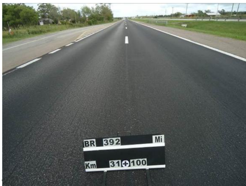
Figura 03 – Manutenção do Pavimento – BR-392/RS
