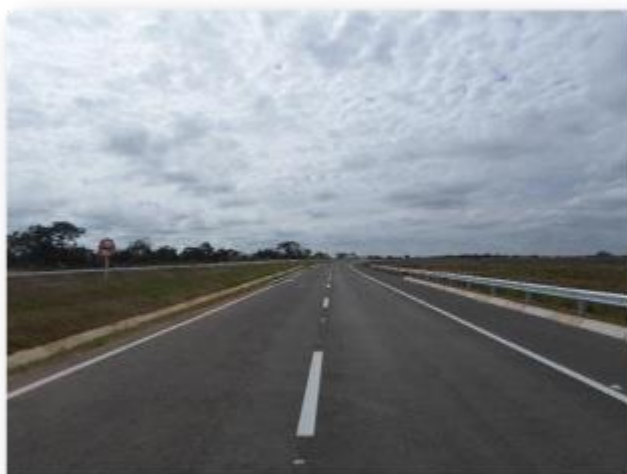
Foto 1 - Pavimentação, sinalização horizontal, sinalização vertical e defesa metálica concluídos.
