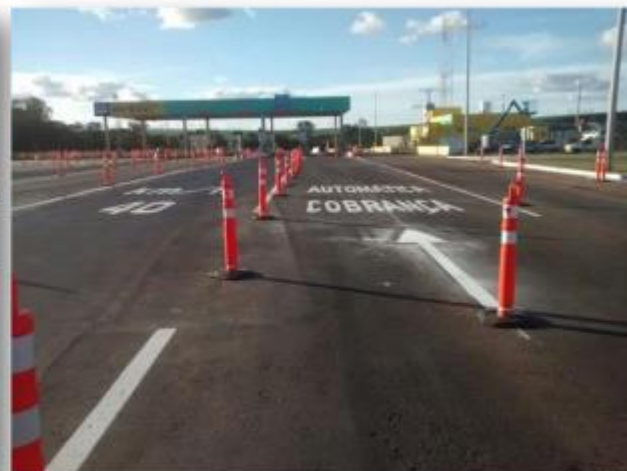
Foto 6 – Execução da Sinalização Horizontal – Legendas e Setas Indicativas.
