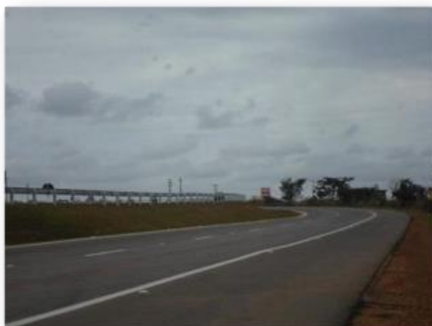
Foto 3 – Sinalizações concluídas, defesa metálica instalada.
