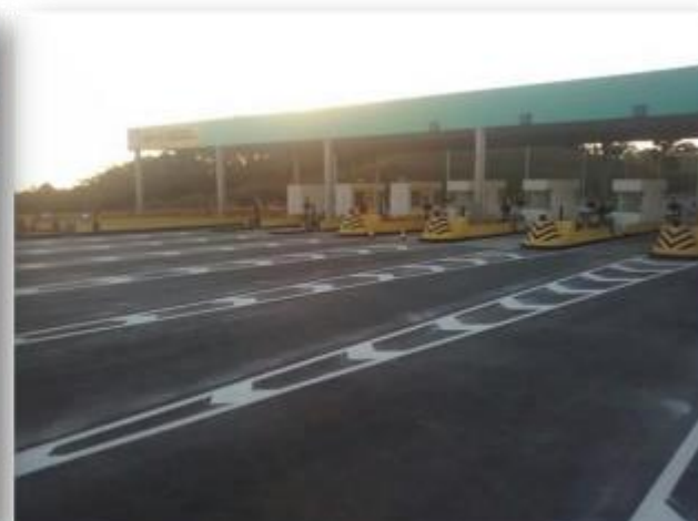
Foto 6 – Pintura dos zebraados executada.
