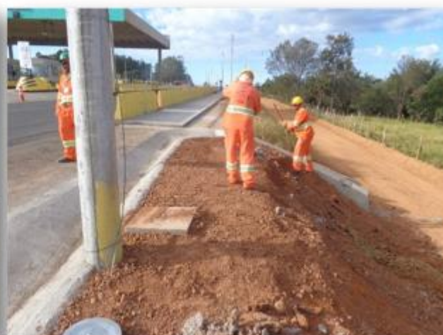
Foto 6 - Conformação do talude para execução da Hidro-semeadura.
