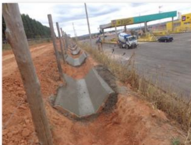
Foto 5 – Primeira etapa de concretagem da Valeta de proteção de corte no bordo do garrafão da praça..
