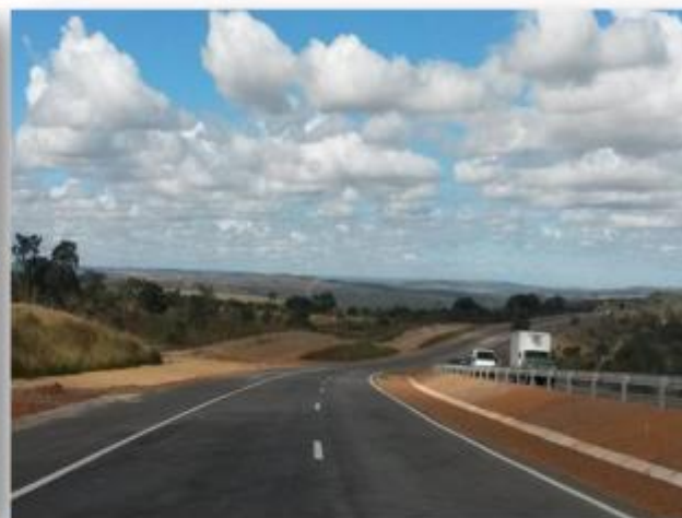
Foto 2 – Sinalização horizontal da pista nova.
