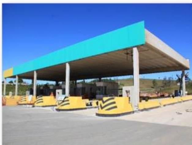
Foto 1 – Perspectiva da testeira da cobertura – Instalação dos painéis para comunicação visual.
