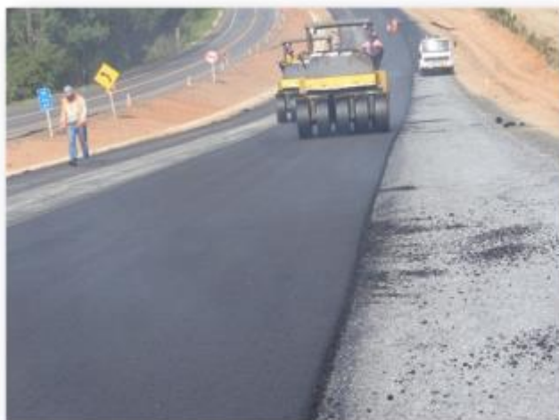
Foto 1 - Lançamento e Compactação do CBUQ.
