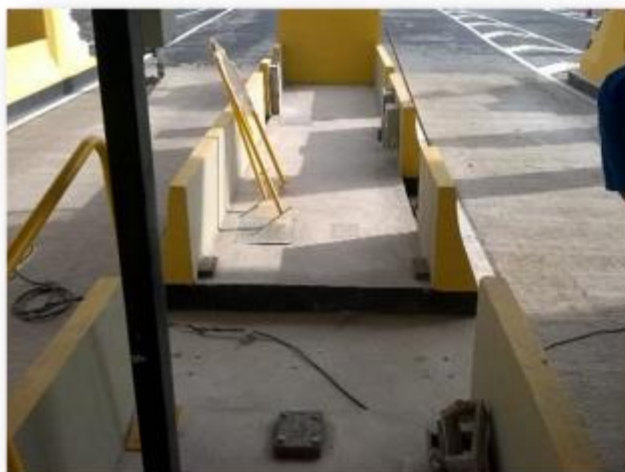
Foto 3 - Início da instalação das barras de proteção nas ilhas.
