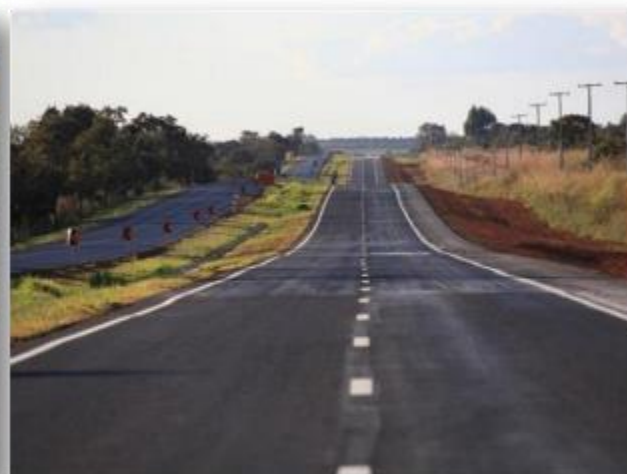
Foto 2 – Sinalização horizontal parcialmente executada.
