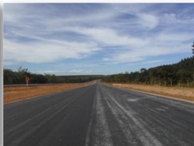
Foto 6 – Pavimento concluído, liberado para pintura da Sinalização horizontal.
