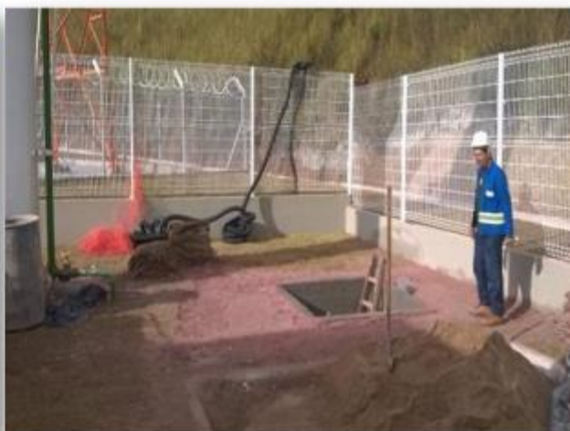
Foto 4 – Rede de drenagem contaminada - Execução da caixa de acúmulo de óleo do gerador.
