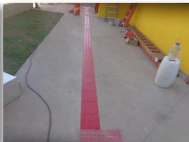
Foto 4 – Instalação do piso tátil do acesso a edificação executada.
