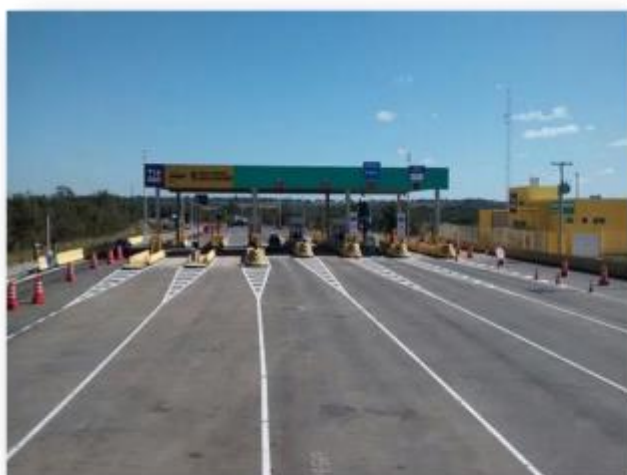
Foto 3 - Vista frontal da praça – Detalhe para os semáforos de indicação de operação na testeira da cobertura. Tráfego operando pelas faixas extralarga Norte e Sul.
