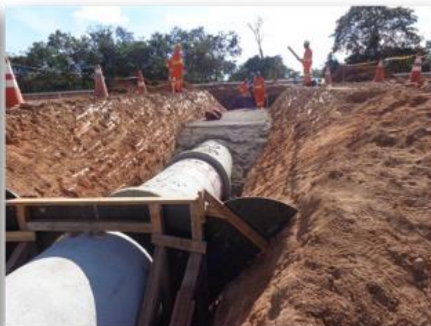
Foto 2 - Envolvimento do BSTC - Instalação das formas para segunda etapa de concretagem.
