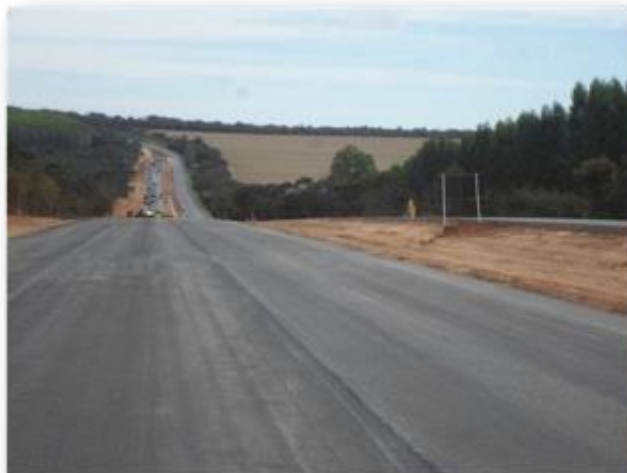
Foto 3 – Execução da pavimentação em CBUQ concluída.
