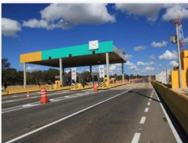
Foto 1 – Instalação dos painéis da testeira da cobertura, onde serão instalados os elementos de comunicação visual e a sinalização de operação das faixas.
