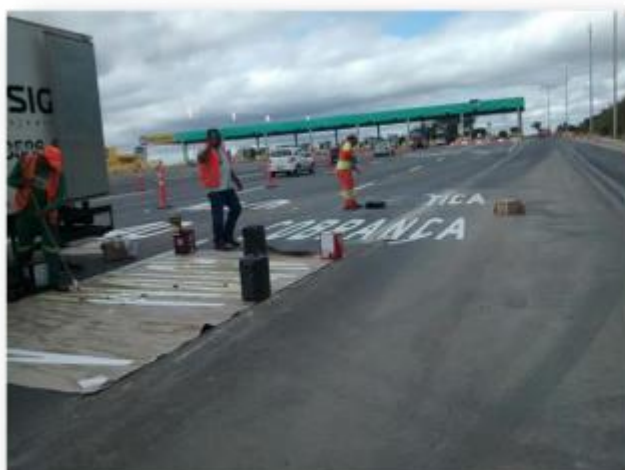
Foto 5 – Instalação da sinalização horizontal tipo legenda no pavimento.
