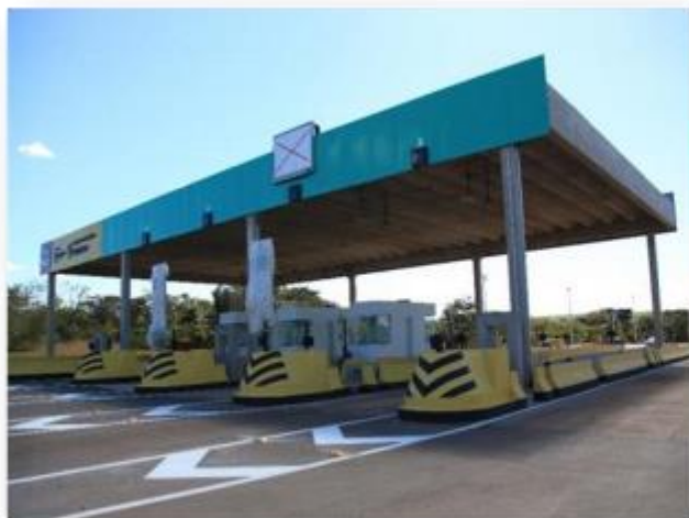
Foto 3 - Perspectiva geral da área das cabines – Elementos de comunicação visual das cabines e testeira da cobertura instalados – Sinalização horizontal executada.
