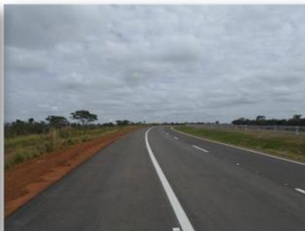
Foto 2 - Detalhe para a linha de bordo de indicação do acostamento com as taxas instaladas.
