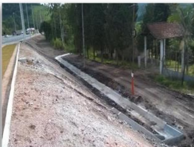
Foto 4 - Concretagem da sarjeta trapezoidal.
