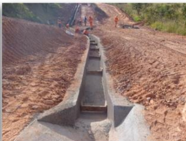
Foto 6 – Desforma e acabamento da Canaleta de drenagem BF.
