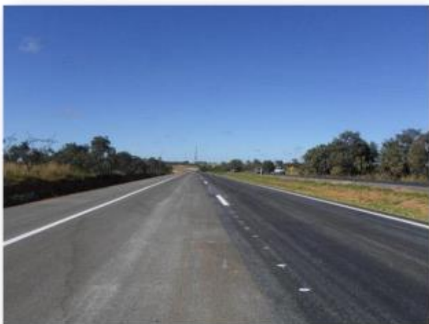
Foto 1 – Pintura das linhas de divisão de fluxo de mesmo sentido, Linhas de bordo acostamento/faixa de segurança concluídas.
