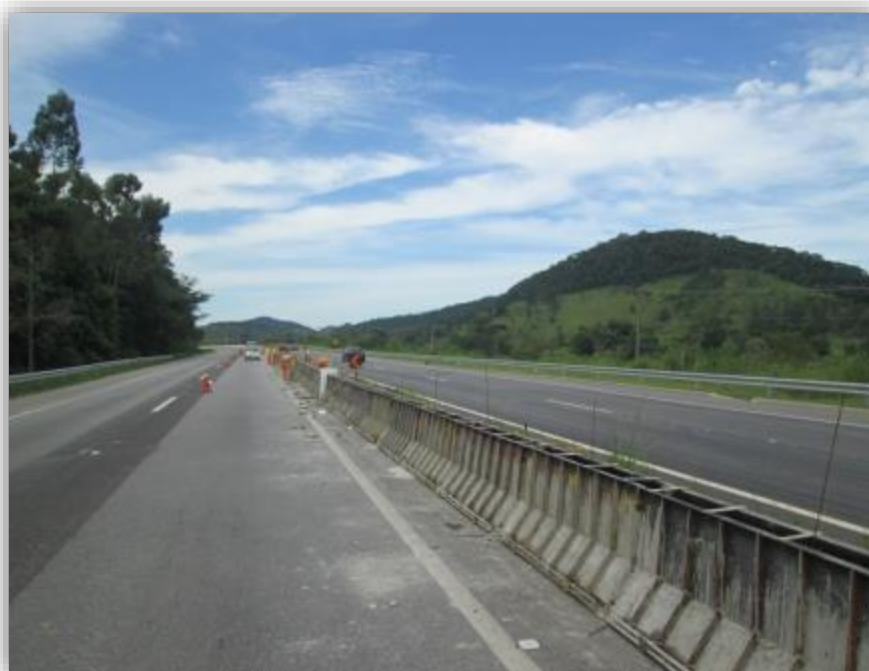
Figura 02 – Concretagem da barreira rígida
