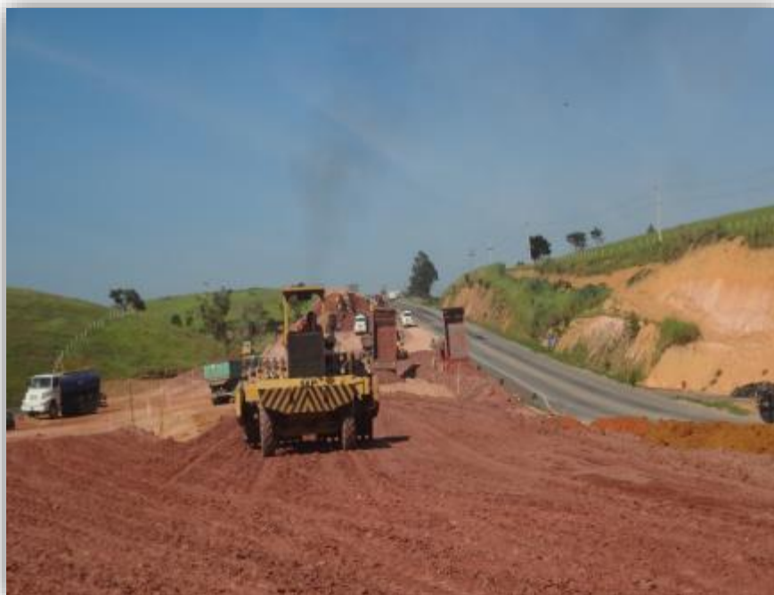
Figura 01 – Execução de terraplanagem na pista norte – km 92,800
