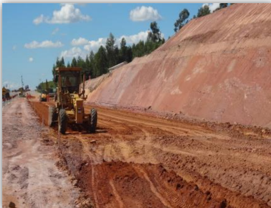
Figura 02 – Regularização do subleito – km 101,100
