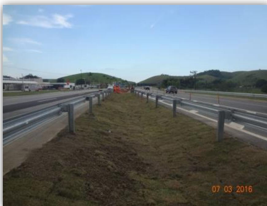
Figura 01 – Plantio de grama no canteiro central
