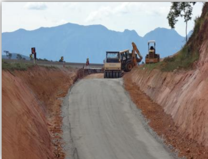
Figura 03 – Execução de Sub base – km 122,100
