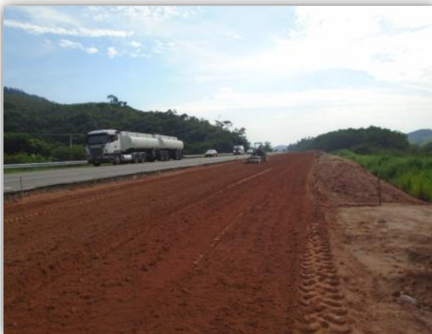
Figura 03 – Tratamento da terceira camada de solo
