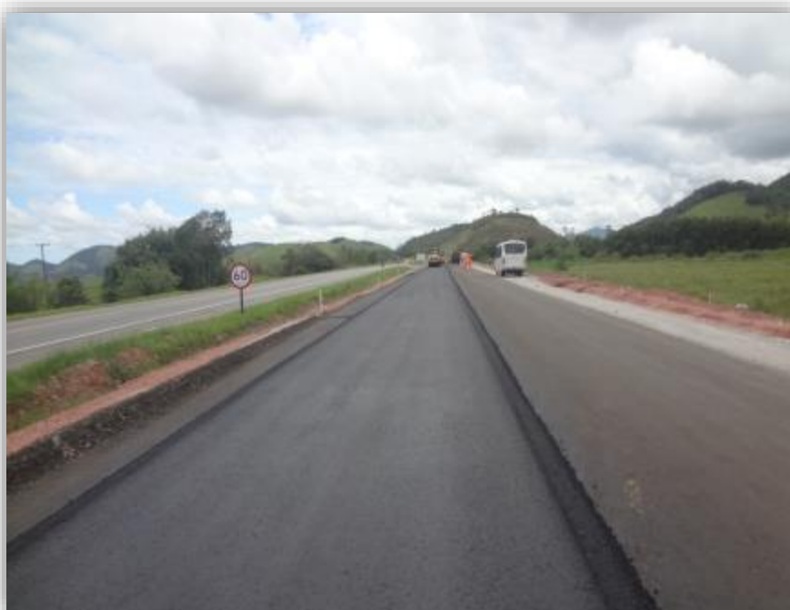
Figura 04 – Aplicação de Binder
