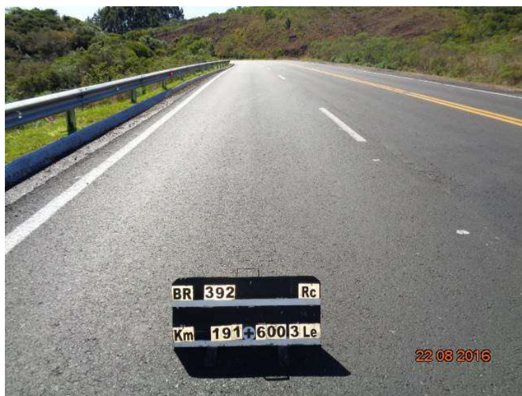
Figura 03 – Recuperação do Pavimento – BR-392/RS
