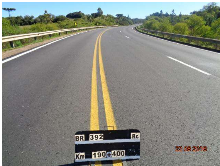
Figura 02 – Recuperação do Pavimento – BR-392/RS
