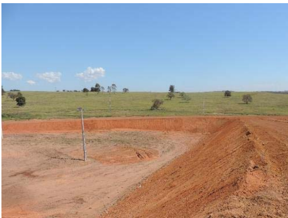
Figura 105 - Conformação de taludes da alça esquerda do Diamante 05 – km 111+000.
