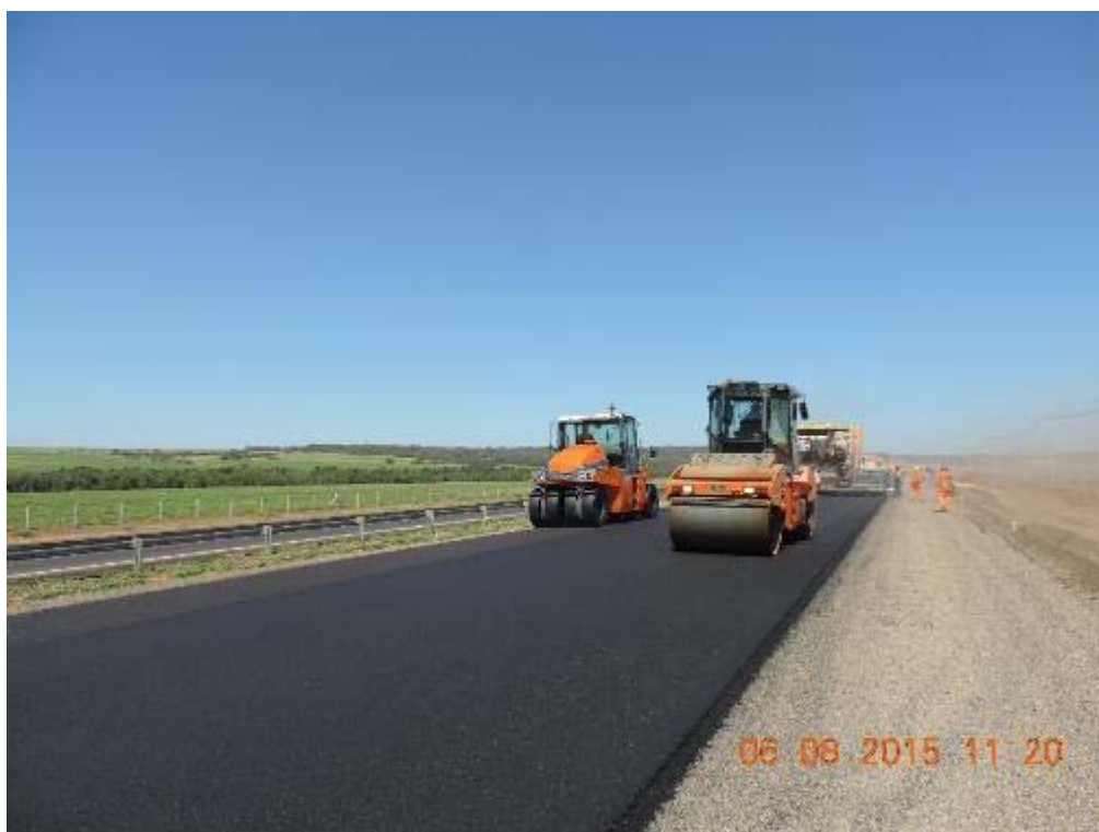
Figura 102 - Segunda camada de CBUQ na recuperação - km 108+440.
