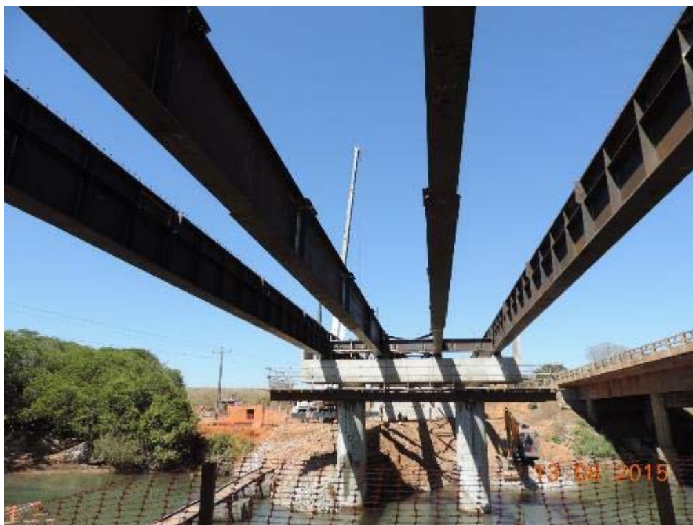
Figura 27 – Vigas lançadas no vão norte da ponte do Rio Itiquira – km 29+900.
