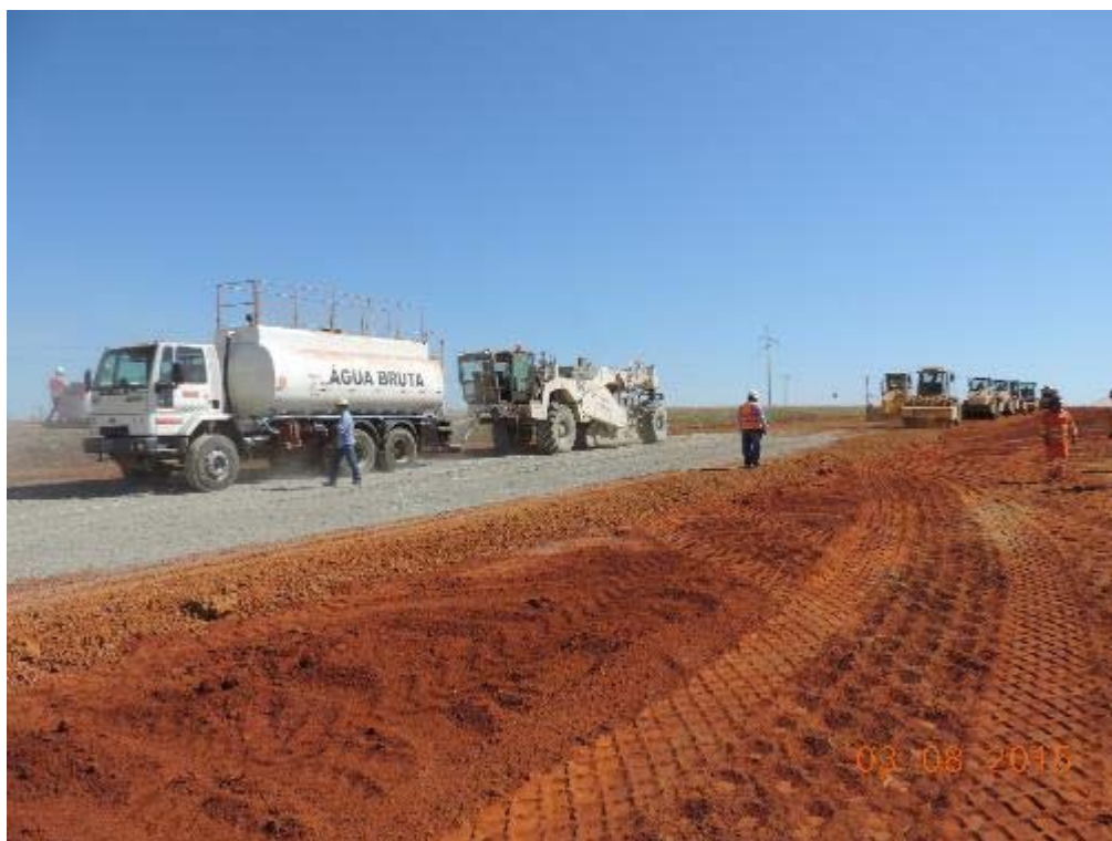
Figura 23 –Sub-base melhorada com cimento na duplicação – km 25+140.
