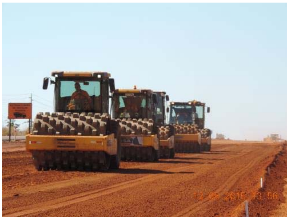
Figura 81 - Compactação de base na duplicação - km 77+550.
