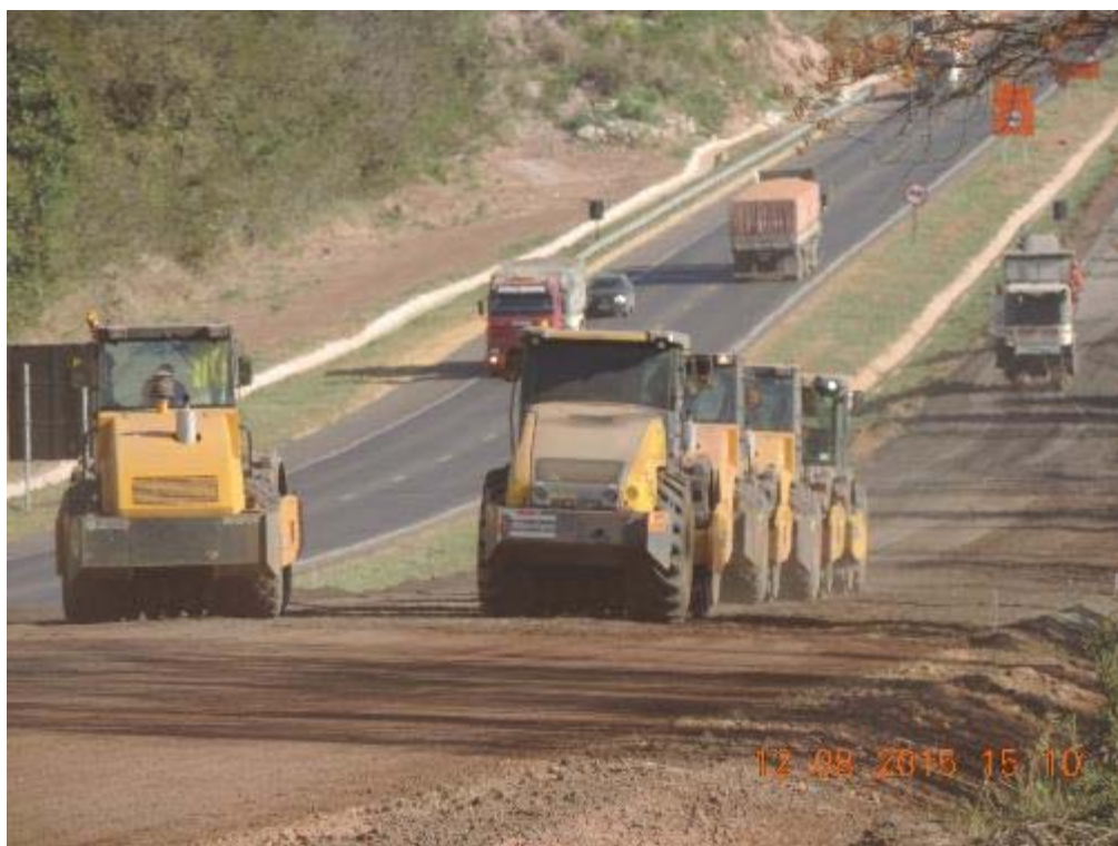
Figura 97 – Base melhorada com cimento na recuperação - km 106+600.
