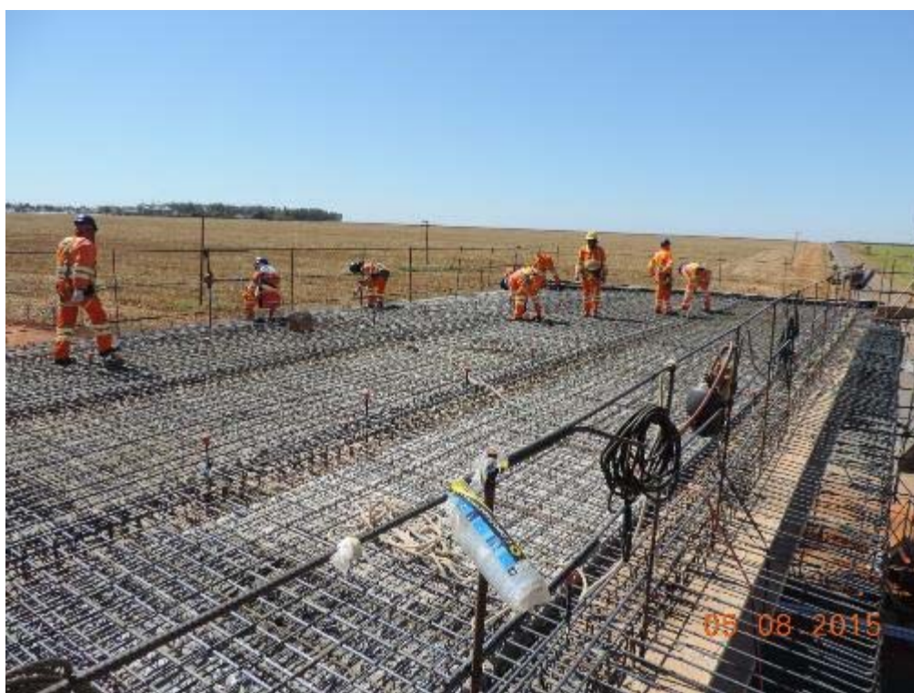
Figura 48 - Armação do tabuleiro direito do Diamante 02 – km 47+700.
