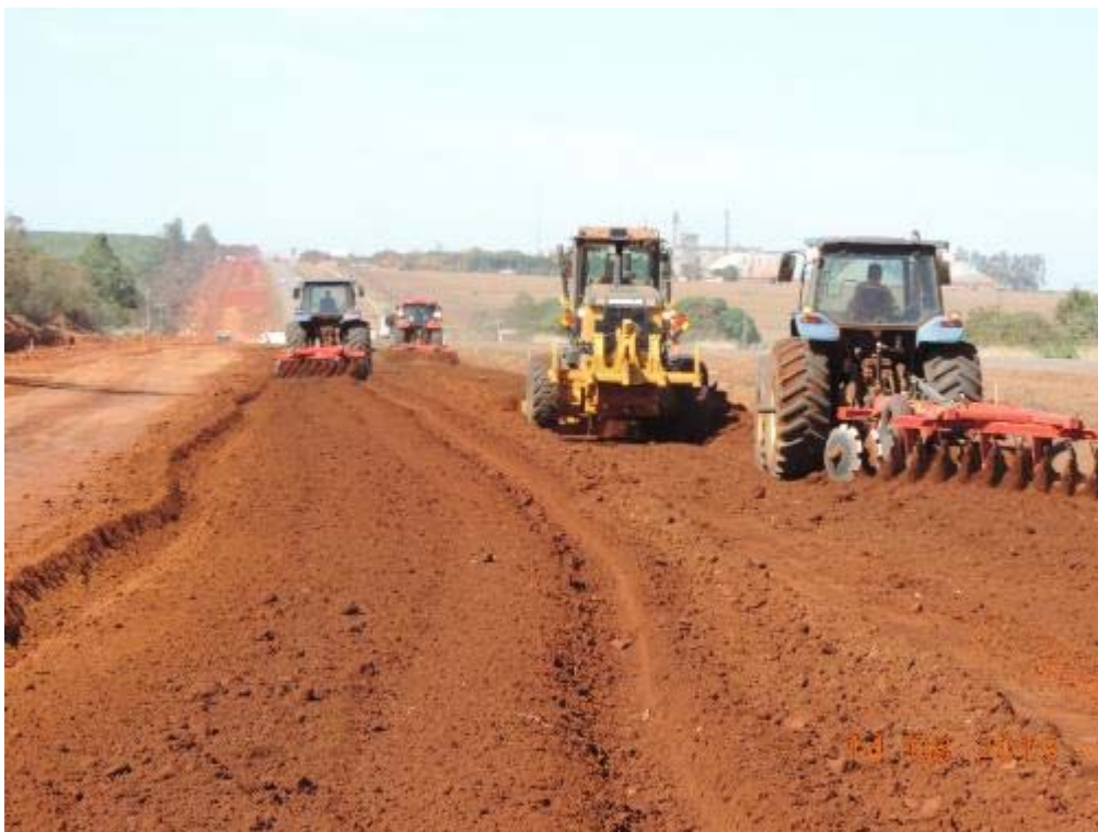
Figura 7 – Tratamento da camada de aterro na duplicação - km 13+100.
