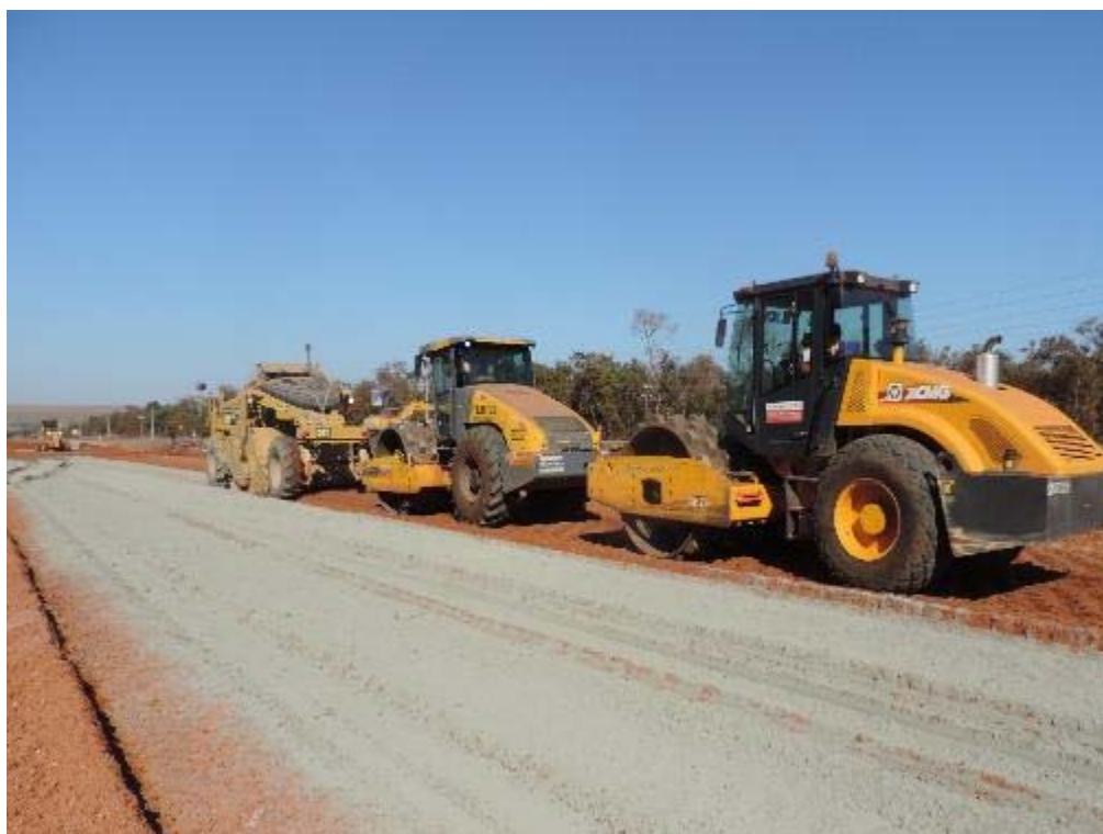
Figura 71 – Sub-base melhorada com cimento na duplicação - km 76+560.
