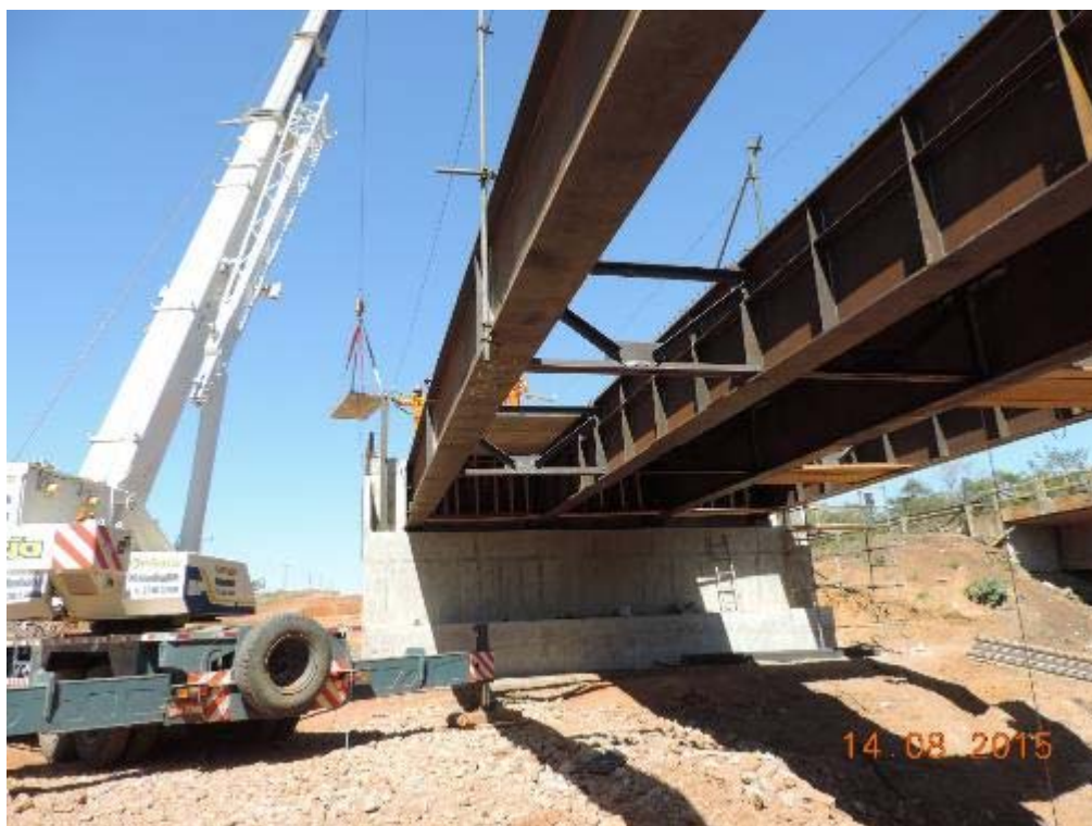
Figura 26 – Lançamento de Pré-laje na ponte do Rio Itiquira – km 29+900.
