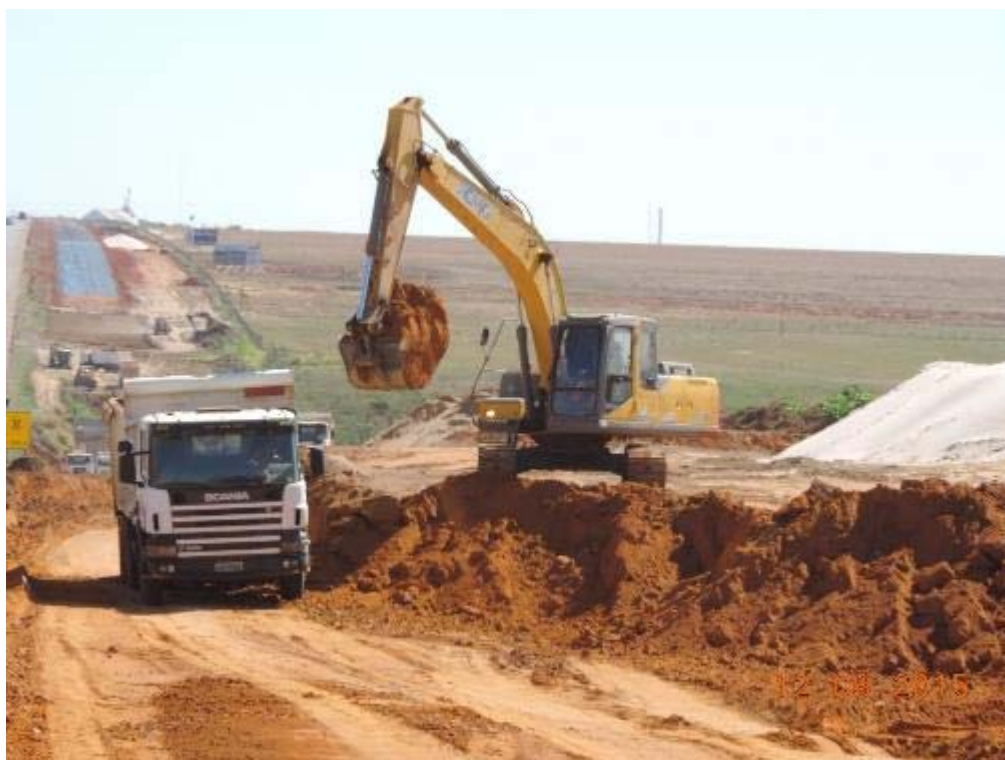
Figura 20 – Escavação de plataforma na duplicação – km 23+980.
