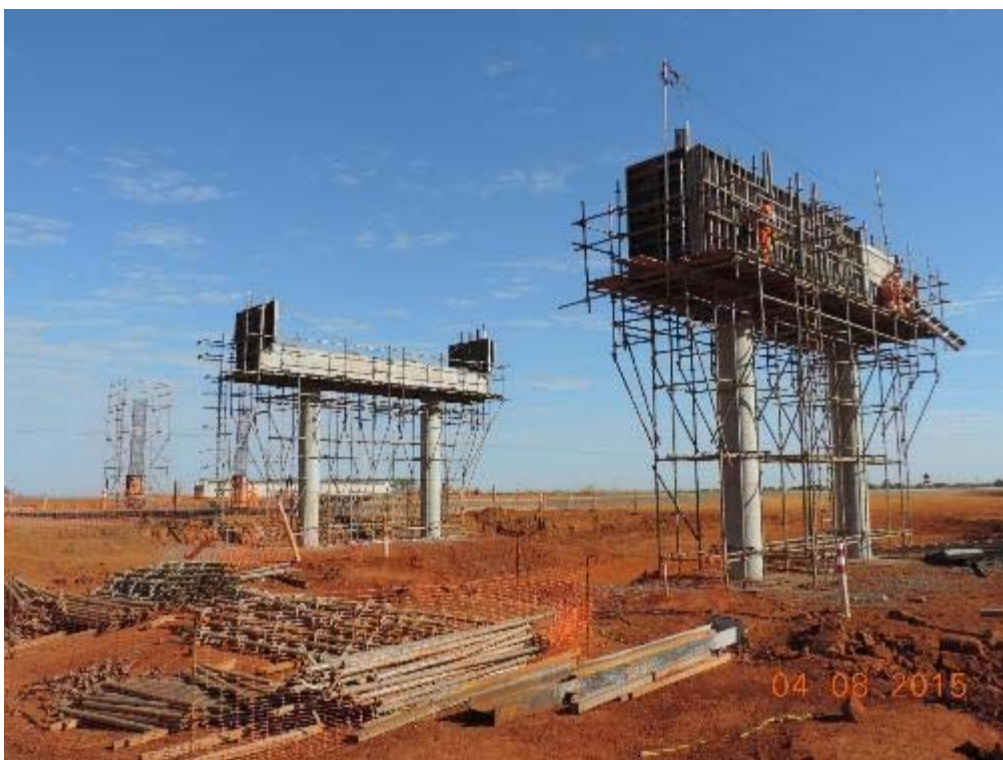
Figura 8 – Desforma da travessa E02 do Diamante 01 – km 13+800.
