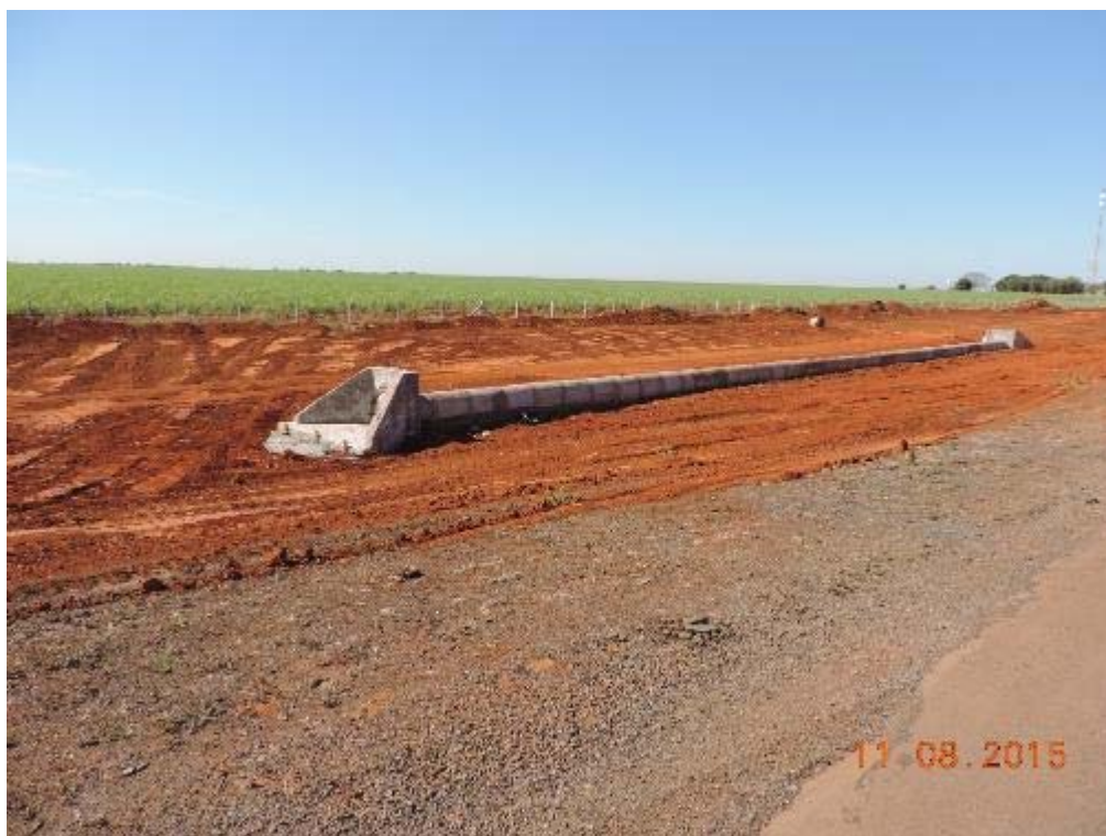
Figura 5 – Execução da decapagem no Retorno em nível 01 – km 08+000.
