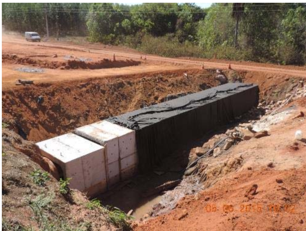
Figura 84 - Posicionamento do corpo do BSCC (2x2m) na duplicação - km 80+000.
