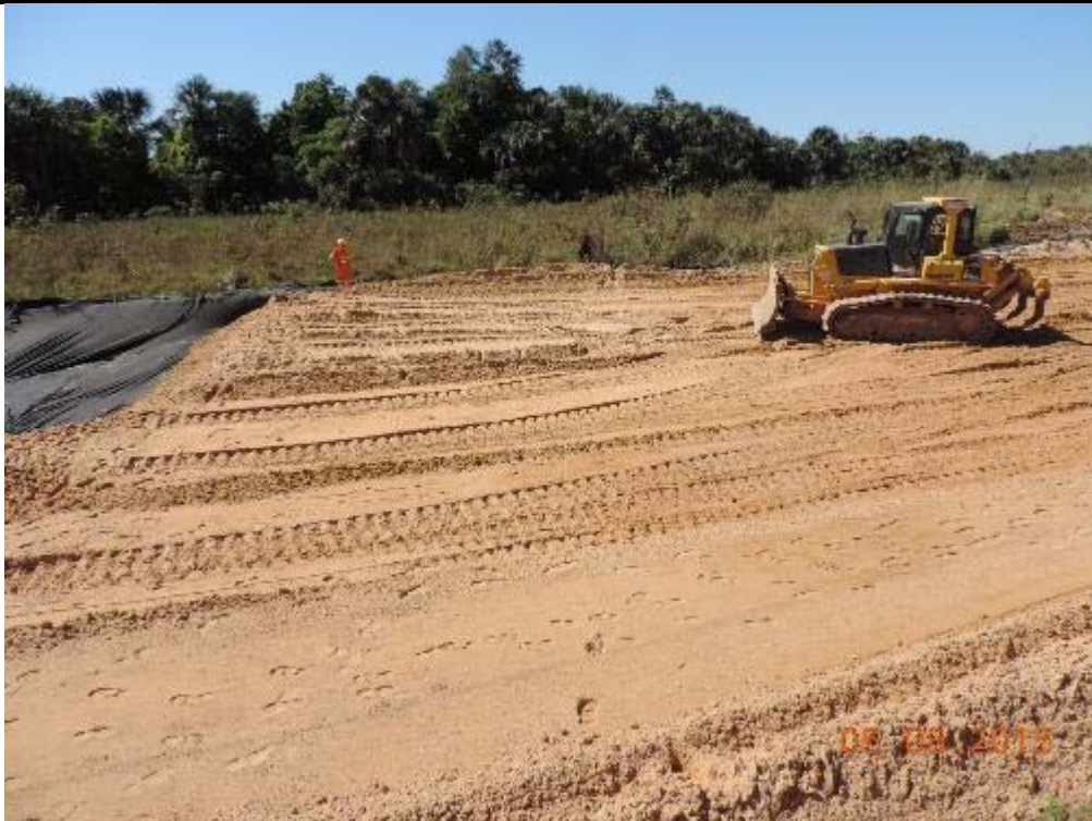
Figura 37 – Lançamento de areia sobre solo saturado na duplicação - km 37+530.
