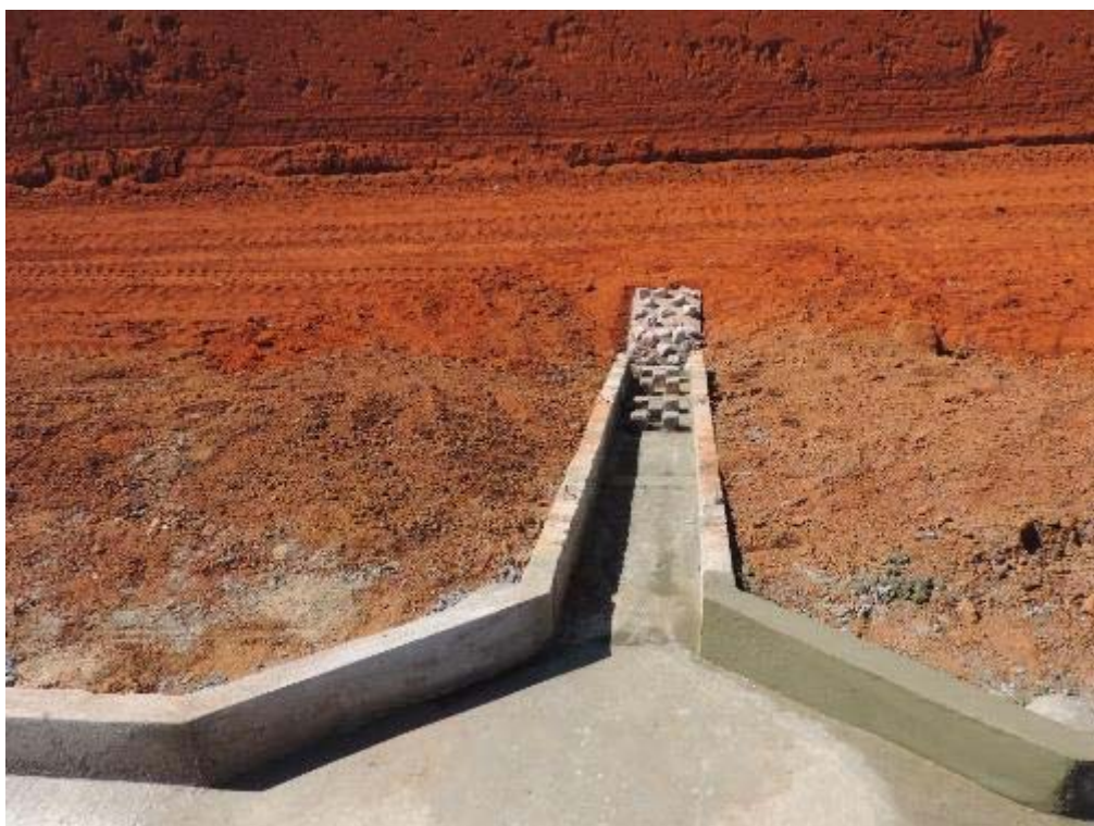
Figura 41 — Descida d'água, entrada d'água e dissipador na duplicação - km 39+260.
