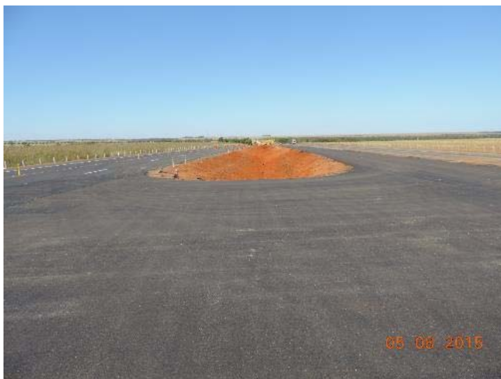
Figura 42 – CBUQ concluído no Retorno em nível 03 – km 39+700.
