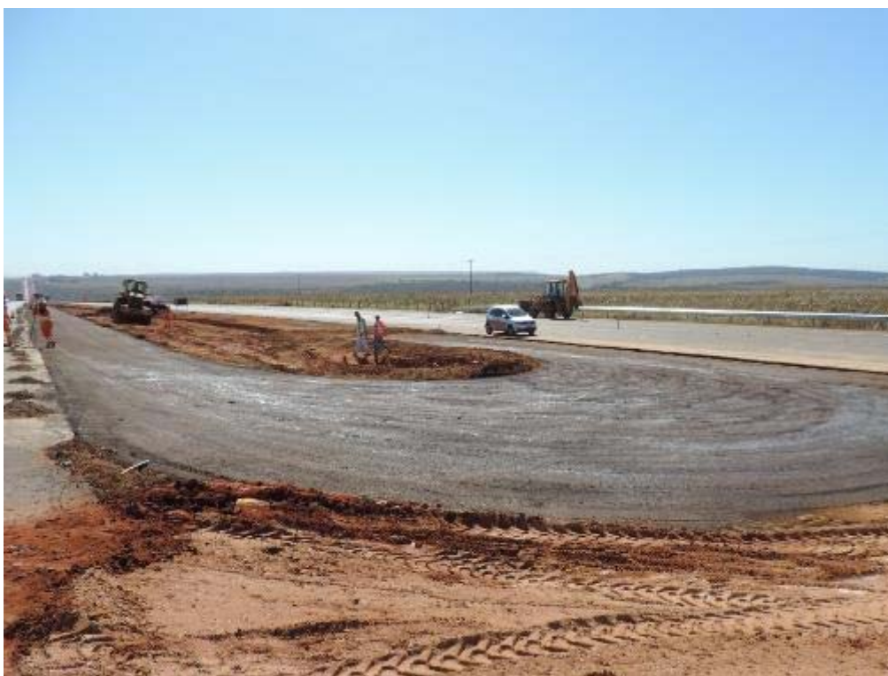
Figura 64 - Imprimação na faixa de retorno norte do Retorno em nível 05 – km 72+000.
