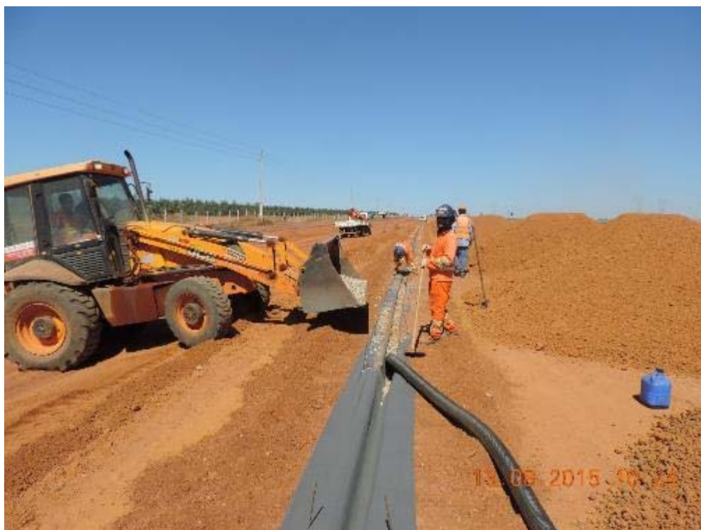
Figura 82 - Dreno do pavimento na duplicação - km 79+350.
