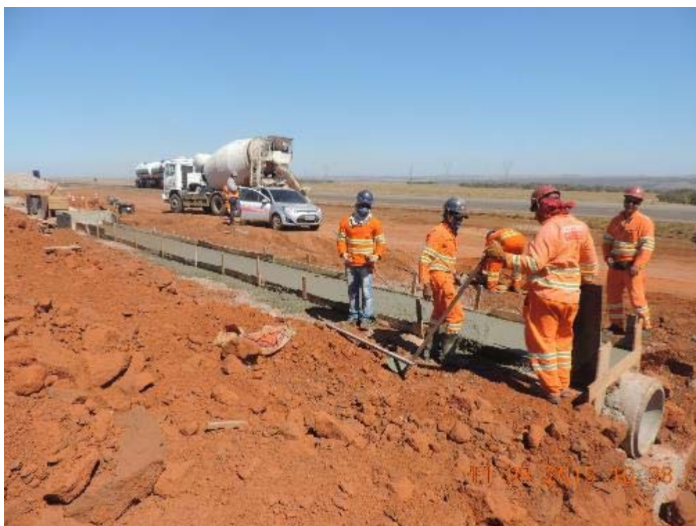
Figura 89 - Envolvamento do BSTC 600mm do Retorno em nível 06.
