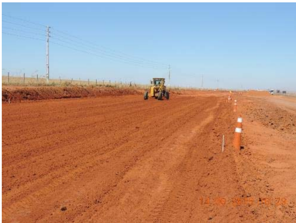
Figura 88 - Tratamento de subleito do Retorno em nível 06.
