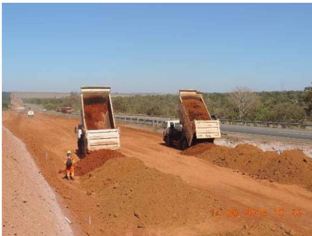
Figura 87 - Lançamento de subleito na duplicação - km 82+830.
