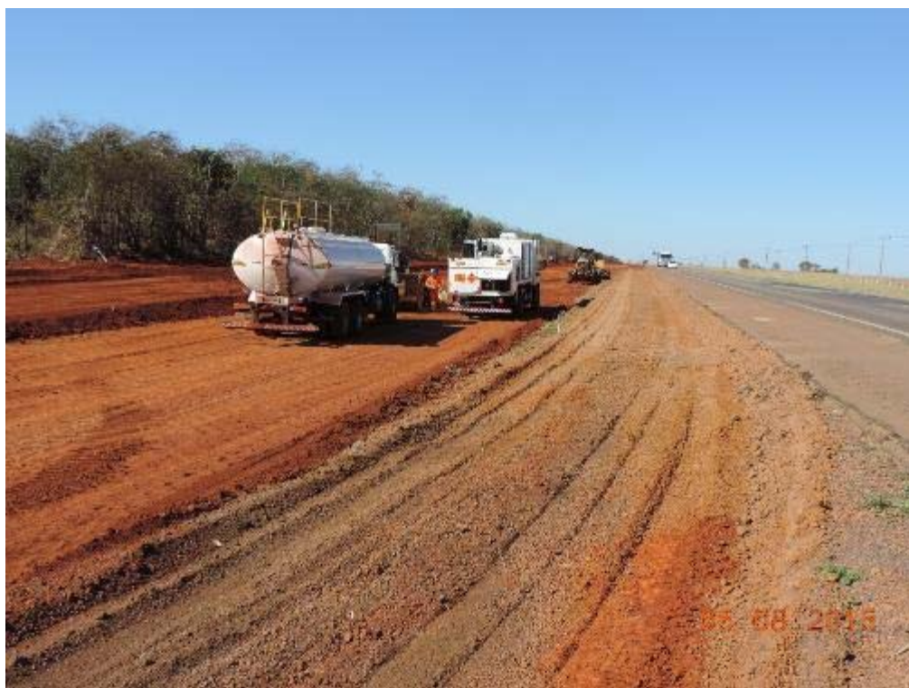
Figura 14 – Lançamento da sub-base na pista de desaceleração do Retorno em nível 02 – km 21+000.
