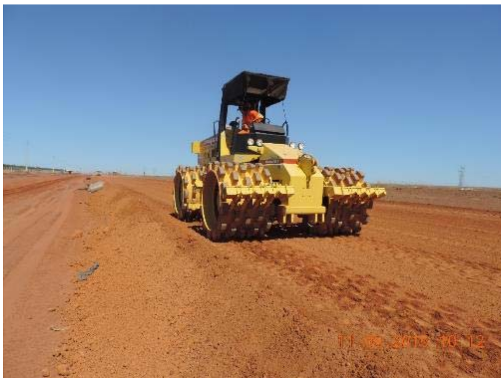
Figura 83 - Compactação da sub-base na duplicação - km 79+400.
