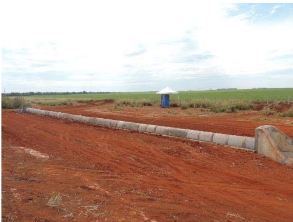
Figura 6 – Instalação das Alas do BSTC de 600mm do Retorno em nível 01 – km 08+000.
