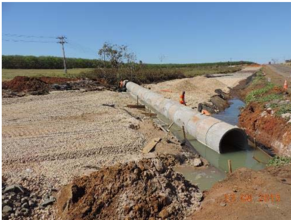
Figura 19 – Execução do BSTC de 1200mm na duplicação – km 23+270.
