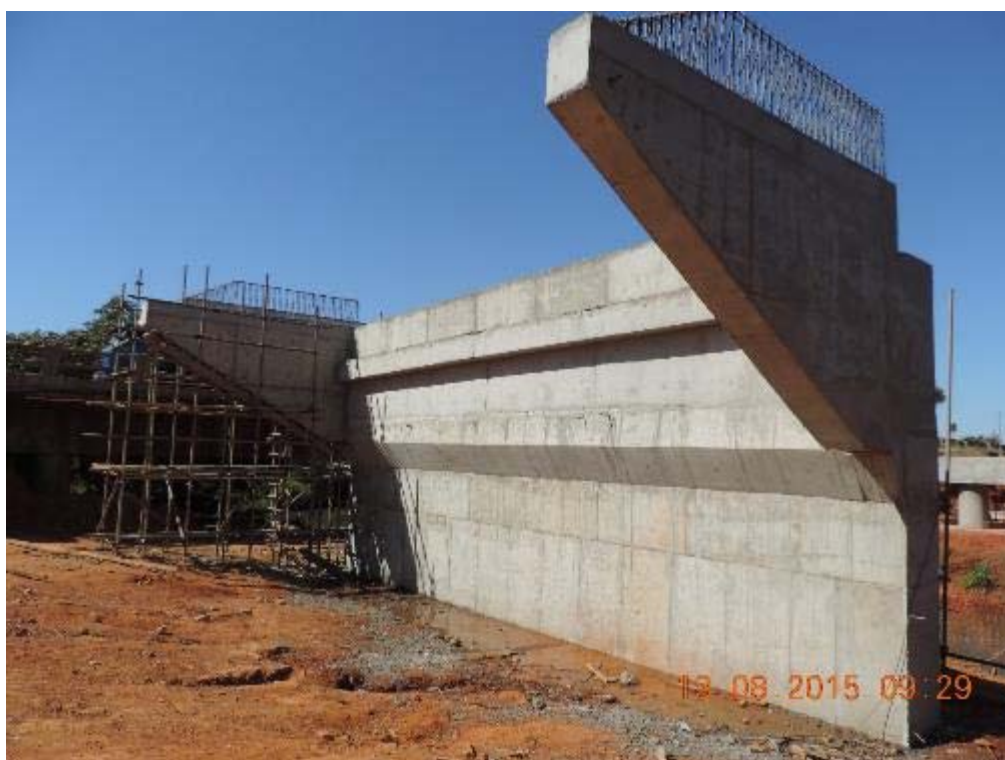
Figura 56 - Vista da ala e encontro norte do rio Ponte de Pedra – km 55+900.
