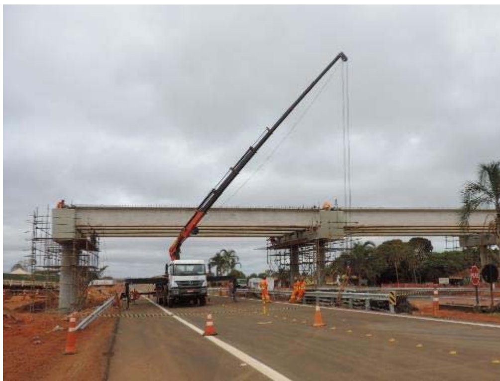
Figura 49 - Lançamento das pré-lajes do Diamante 02 – km 47+700.
