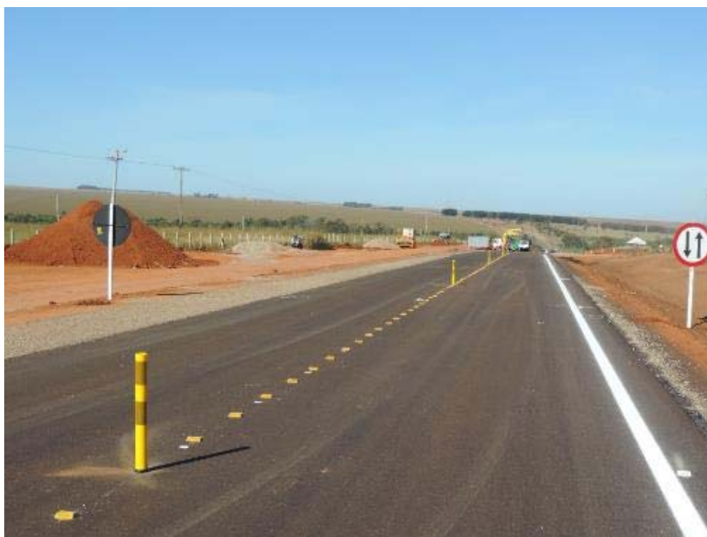
Figura 59 – Instalação de sinalização na duplicação - km 56+720.
