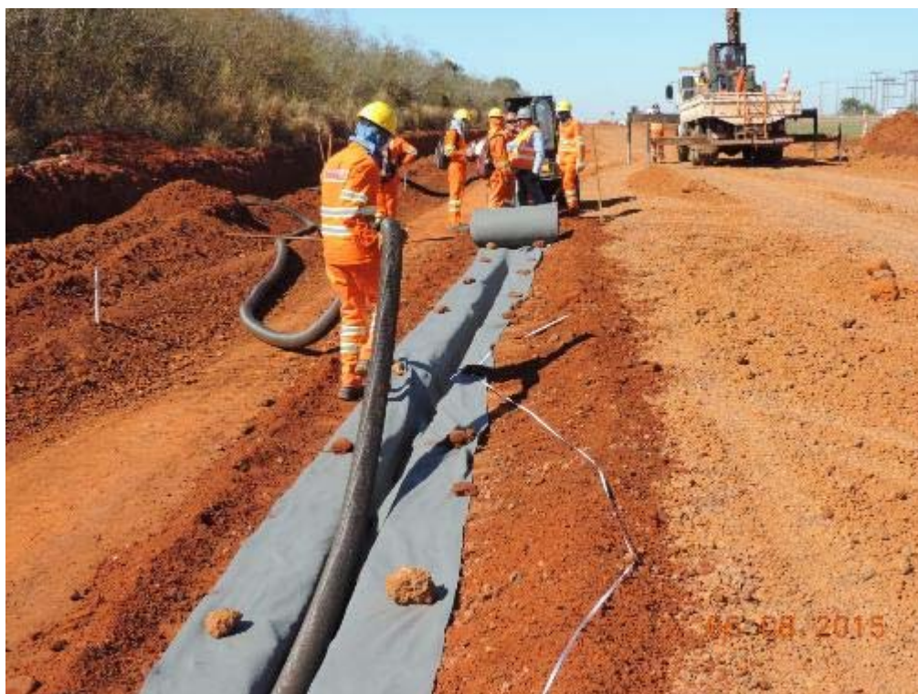
Figura 16 – Execução de dreno do pavimento na duplicação – km 21+810.
