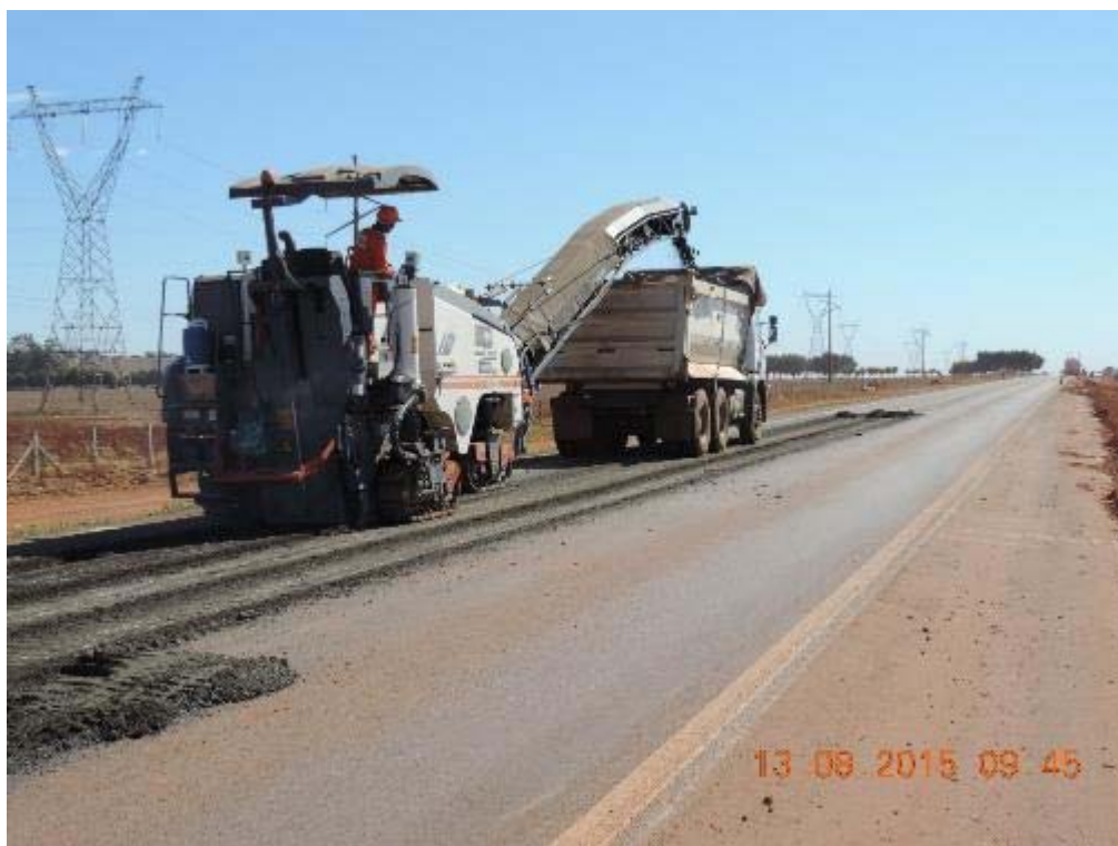
Figura 60 - Fresagem descontínua na recuperação - km 58+980.
