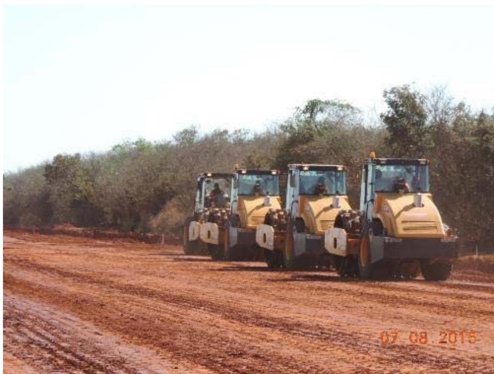
Figura 13 – Compactação da camada de aterro na duplicação - km 18+925.
