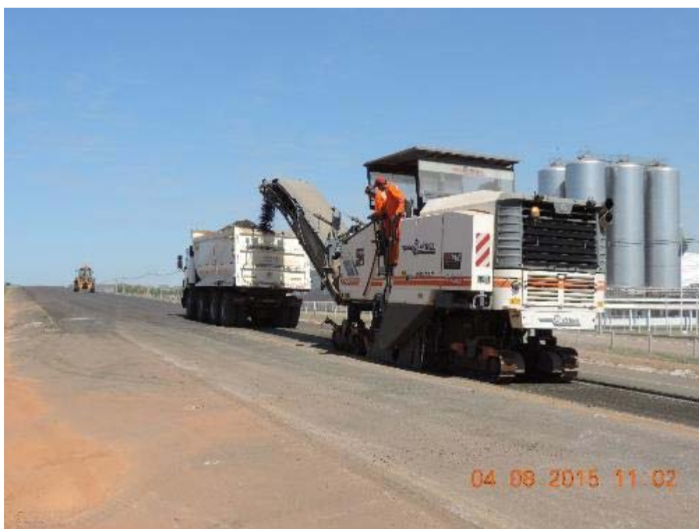
Figura 109 - Fresagem contínua da recuperação - km 116+250.
