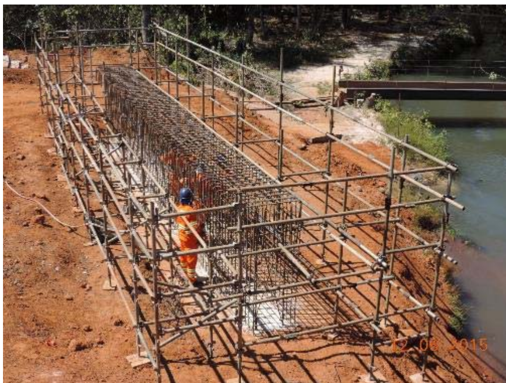
Figura 45 - Armação do encontro E02 na ponte do Rio Cachoeira – km 44+600.
