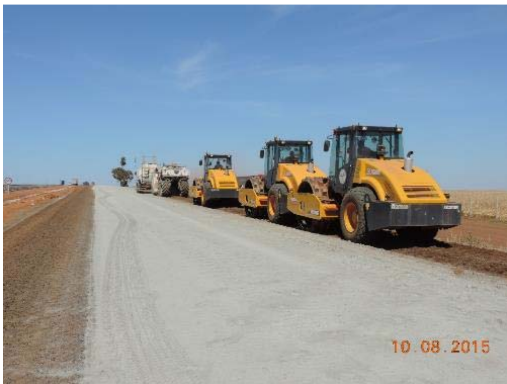
Figura 53 - Reciclagem da base na recuperação - km 49+525.
