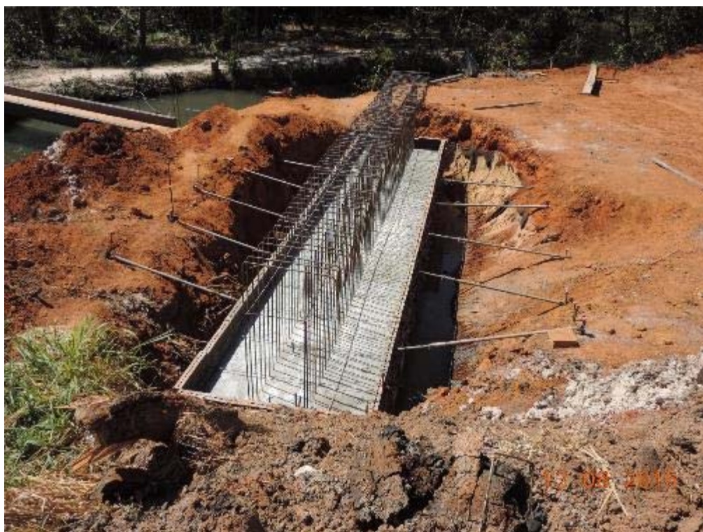
Figura 46 – Bloco E01 concretado na ponte do Rio Cachoeira – km 44+600.
