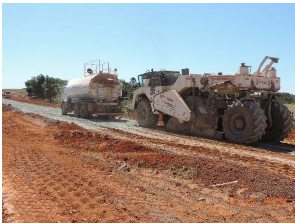
Figura 39 – Base melhorada com cimento na duplicação - km 38+840.
