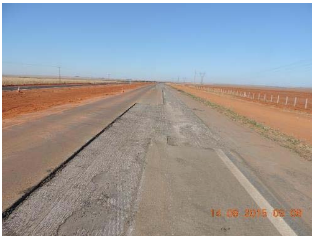
Figura 61 - Fresagem descontínua na recuperação - km 59+140.
