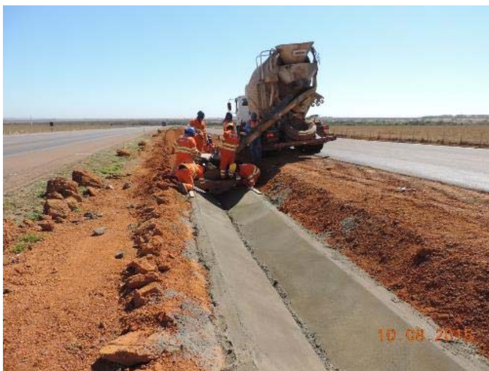
Figura 36 – Execução de SCC na duplicação – km 36+320.
