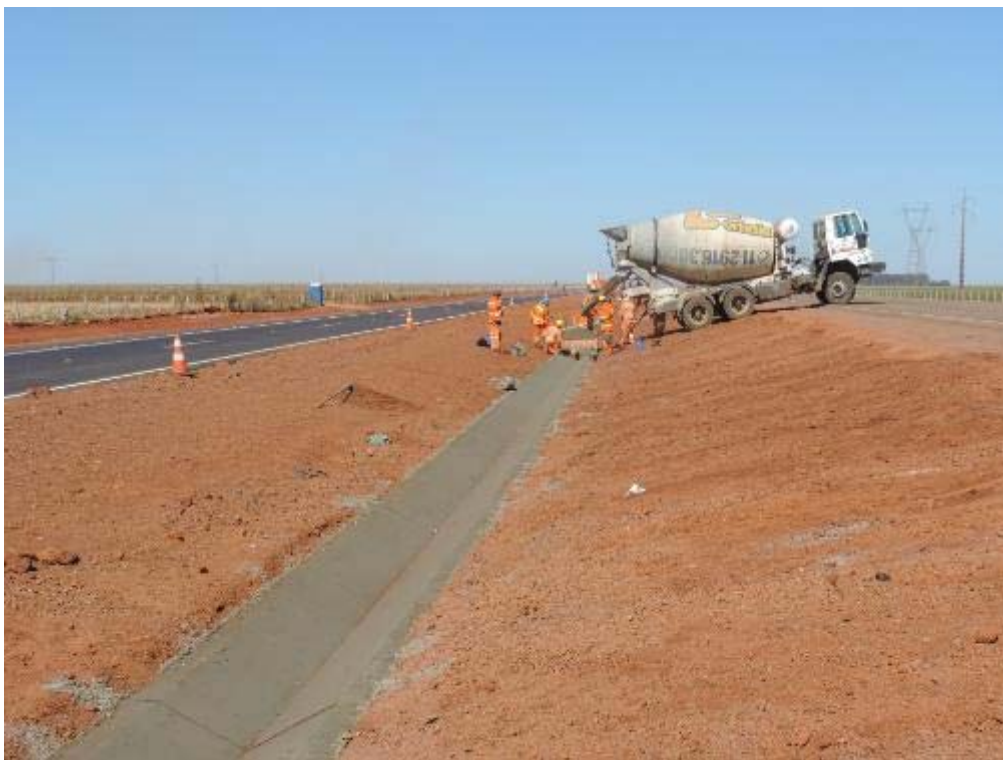
Figura 63 - Sarjeta de canteiro central na duplicação - km 63+380.
