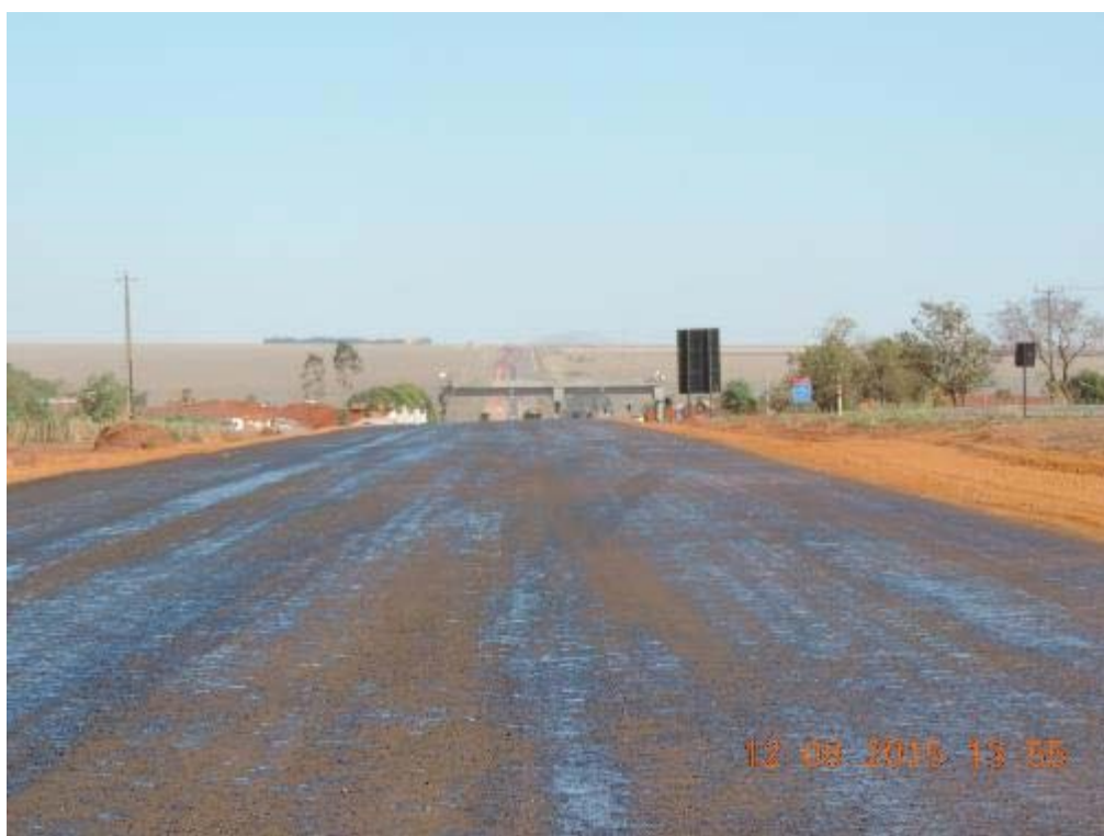
Figura 80 - Imprimação na duplicação - km 77+530.
