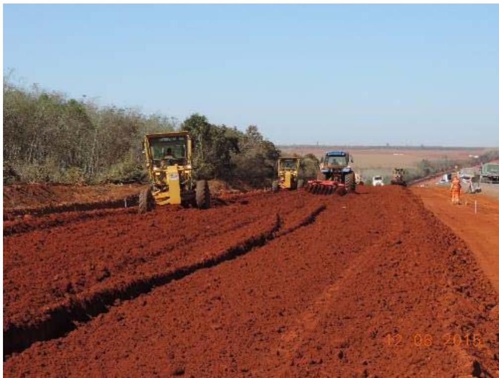
Figura 11 – Tratamento da camada de subleito na duplicação - km 18+200.
