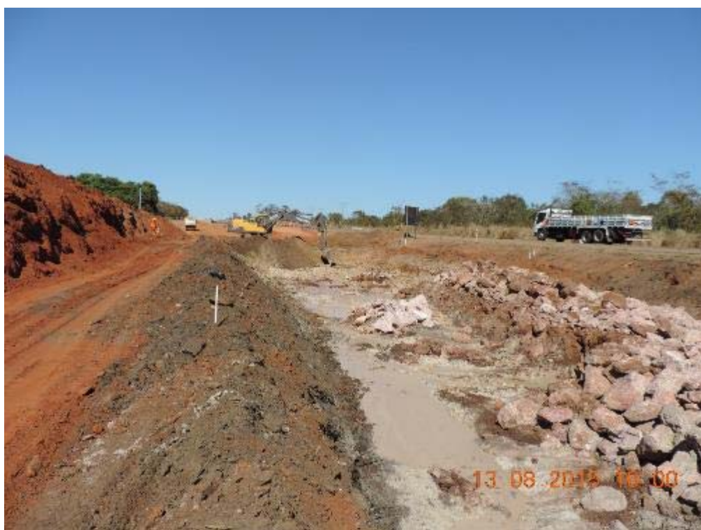
Figura 66 - Remoção de solo saturado na duplicação - km 74+550.
