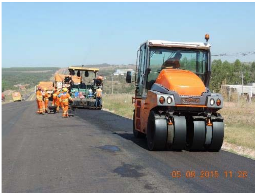
Figura 108 - Camada de CBUQ do acostamento na recuperação - km 115+870.
