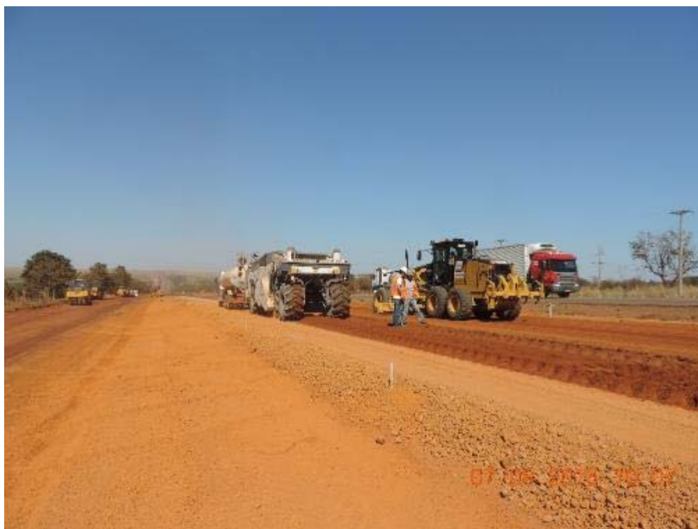
Figura 68 - Base melhorada com cimento na duplicação - km 75+950.
