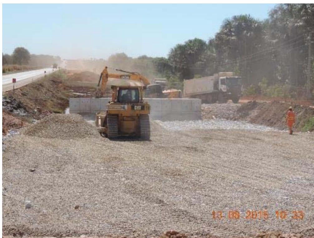
Figura 85 - Brita sobre solo saturado na duplicação - km 81+280.
