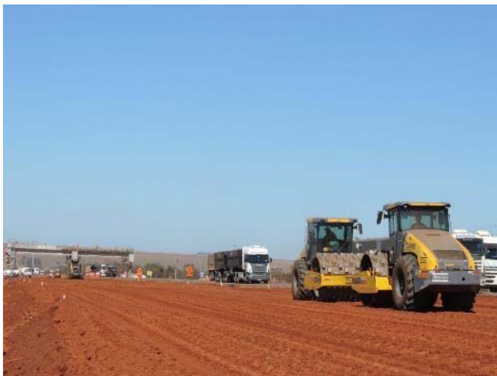
Figura 79 - Compactação de material de aterro na duplicação - km 77+200.
