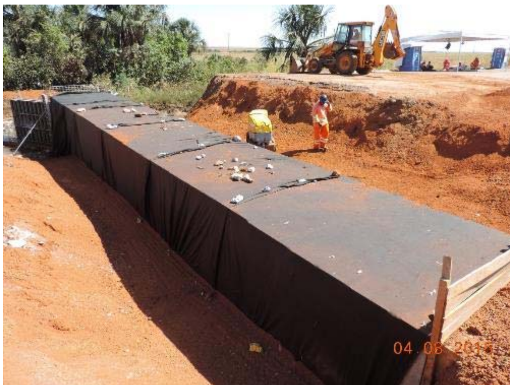
Figura 54 - Reaterro do corpo do BSCC (2,0x2,0m) na duplicação - km 50+350.
