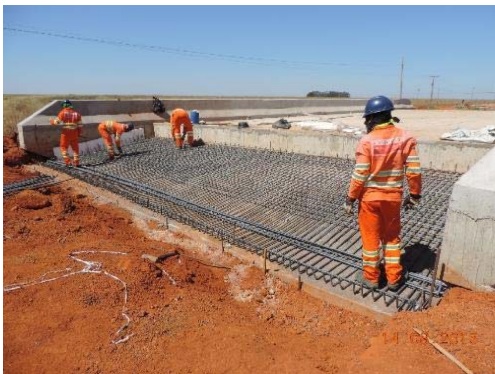
Figura 34 – Armação da laje de transição norte da Passagem sobre a linha férrea – km 34+358.
