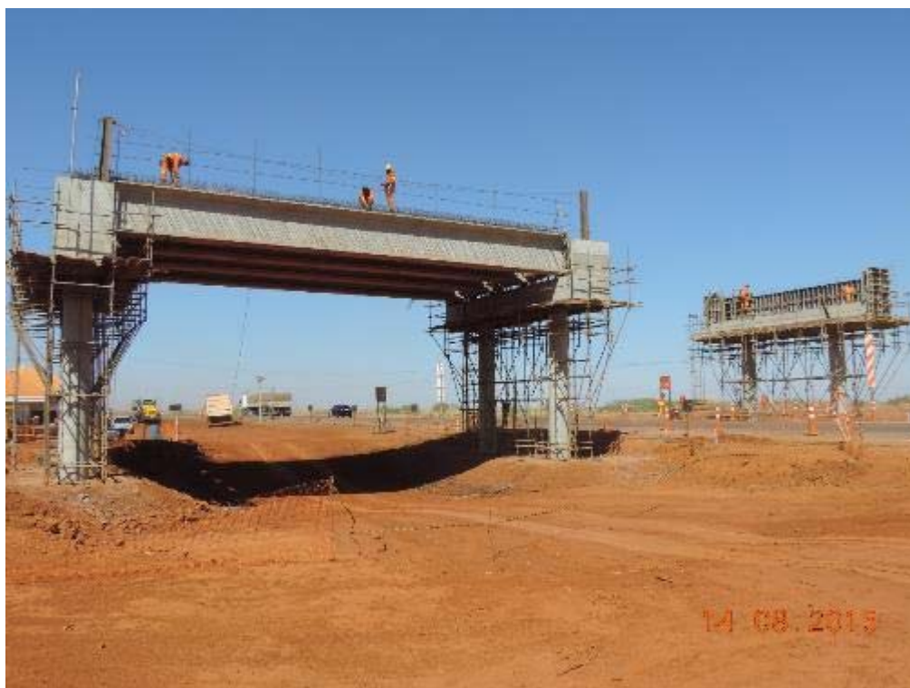
Figura 9 – Armação do tabuleiro direito do Diamante 01 – km 13+800.
