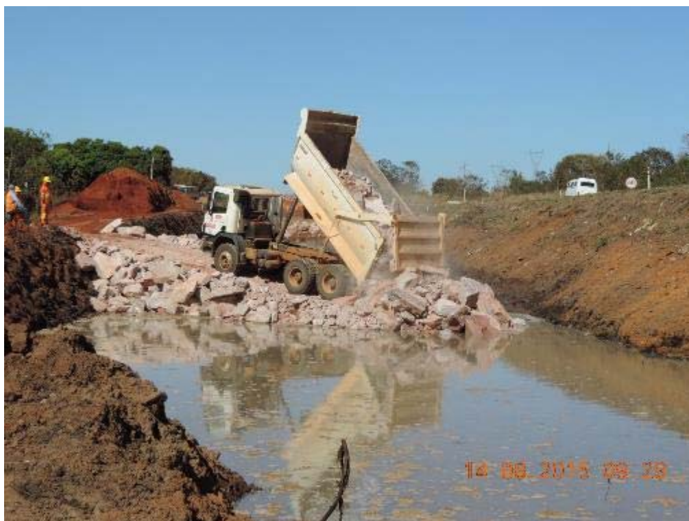
Figura 65 - Rachão sobre solo saturado na duplicação - km 74+550.
