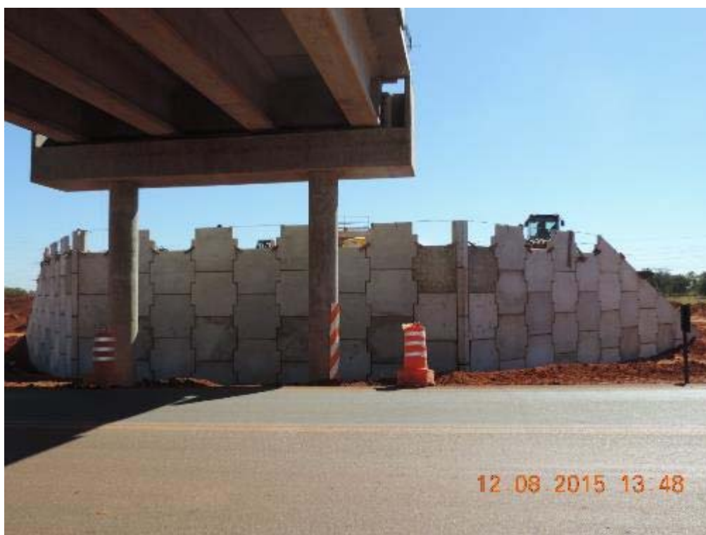
Figura 76 - Muro da terra armada da alça esquerda do Diamante 03 – km 76+900.
