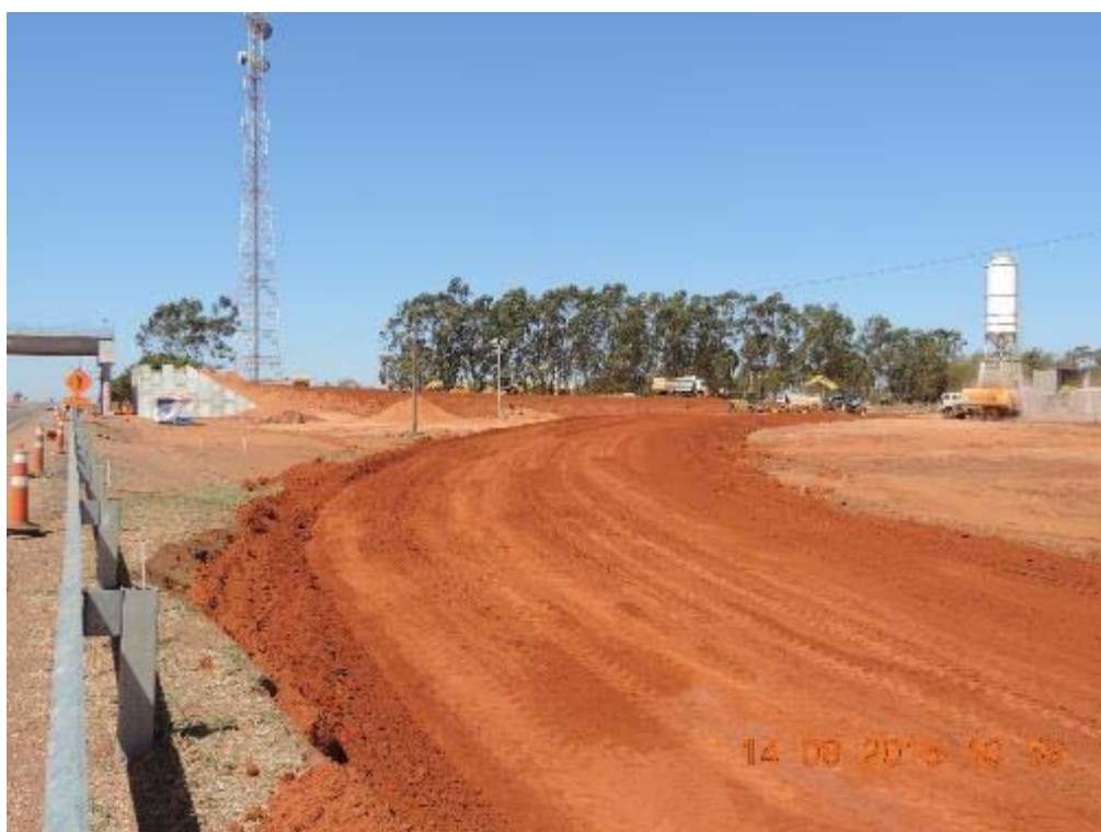
Figura 93 - Terraplenagem na alça esquerda do Diamante 04 – km 94+300.
