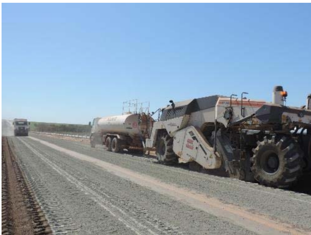
Figura 101 - Base melhorada com cimento na recuperação - km 108+230.
