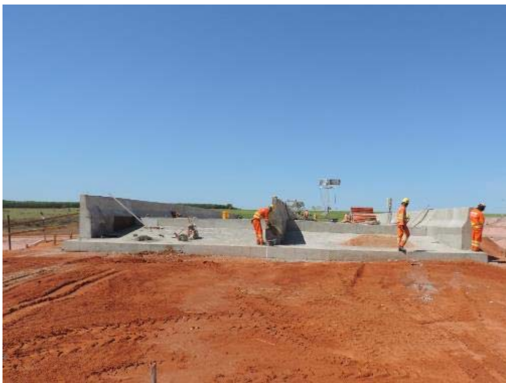
Figura 106 - Execução de acabamentos nas New jersey do Diamante 05 – km 111+000.
