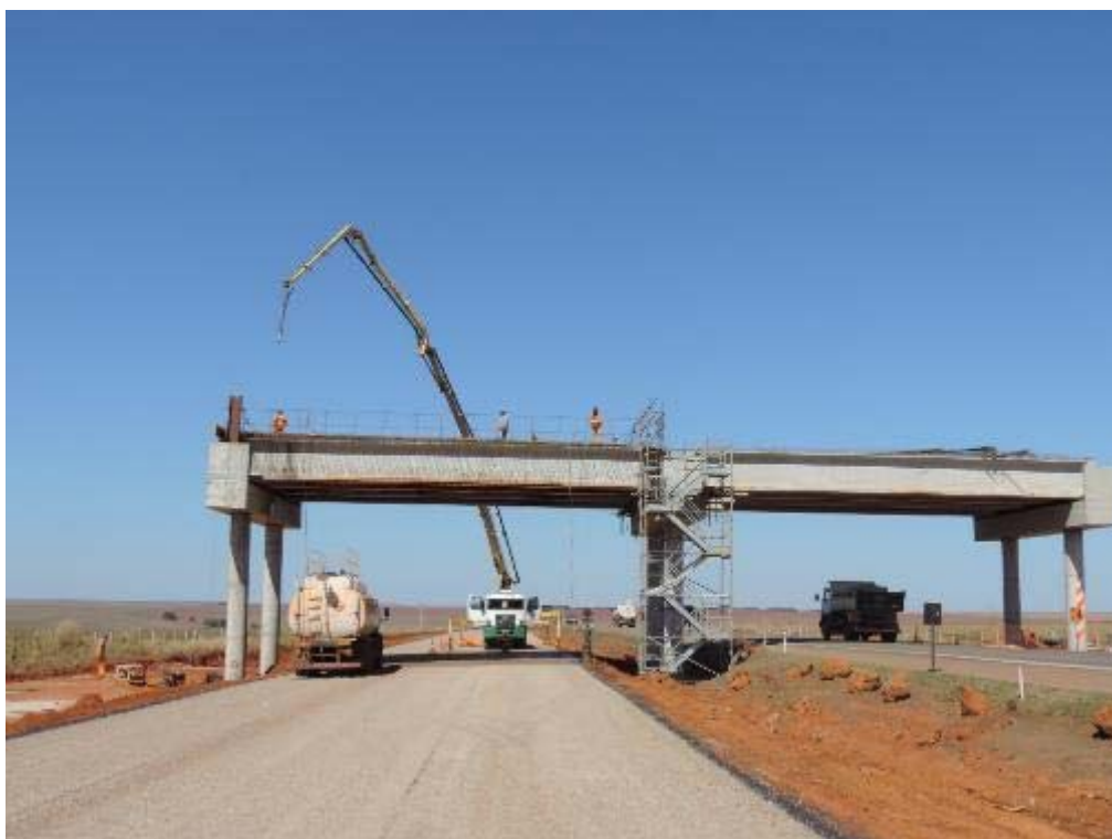
Figura 31 – Mobilização para concretagem do tabuleiro direito do Retorno em desnível 01 – km 32+000.
