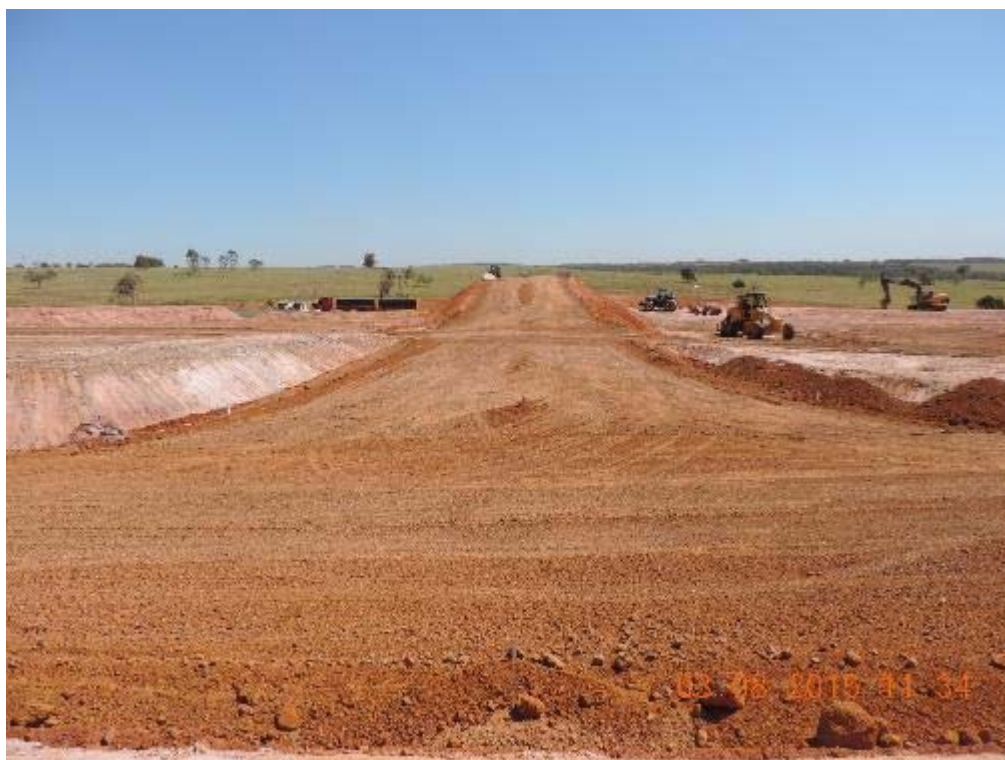
Figura 104 - Base lançada na alça direita do Diamante 05 – km 111+000.
