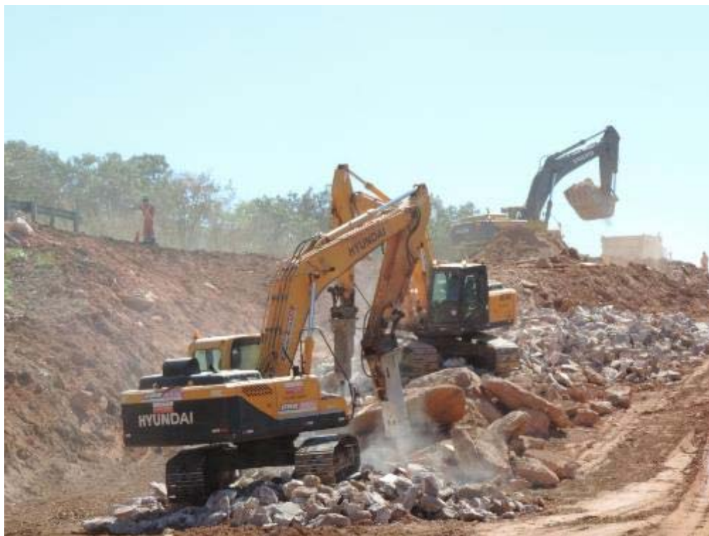
Figura 90 - Apicoamento de rocha na duplicação - km 88+300.
