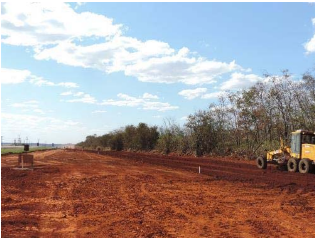
Figura 15 – Tratamento da camada de aterro no Retorno em nível 02 – km 21+000.
