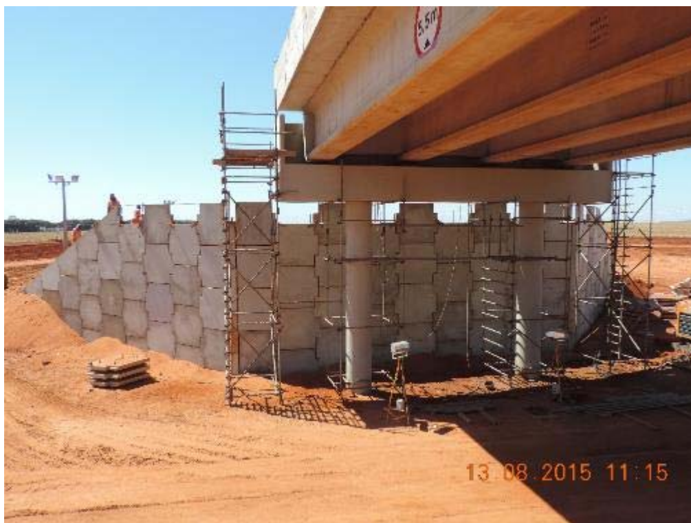
Figura 94 - Muro da terra armada da alça direita do Diamante 04 – km 94+300.
