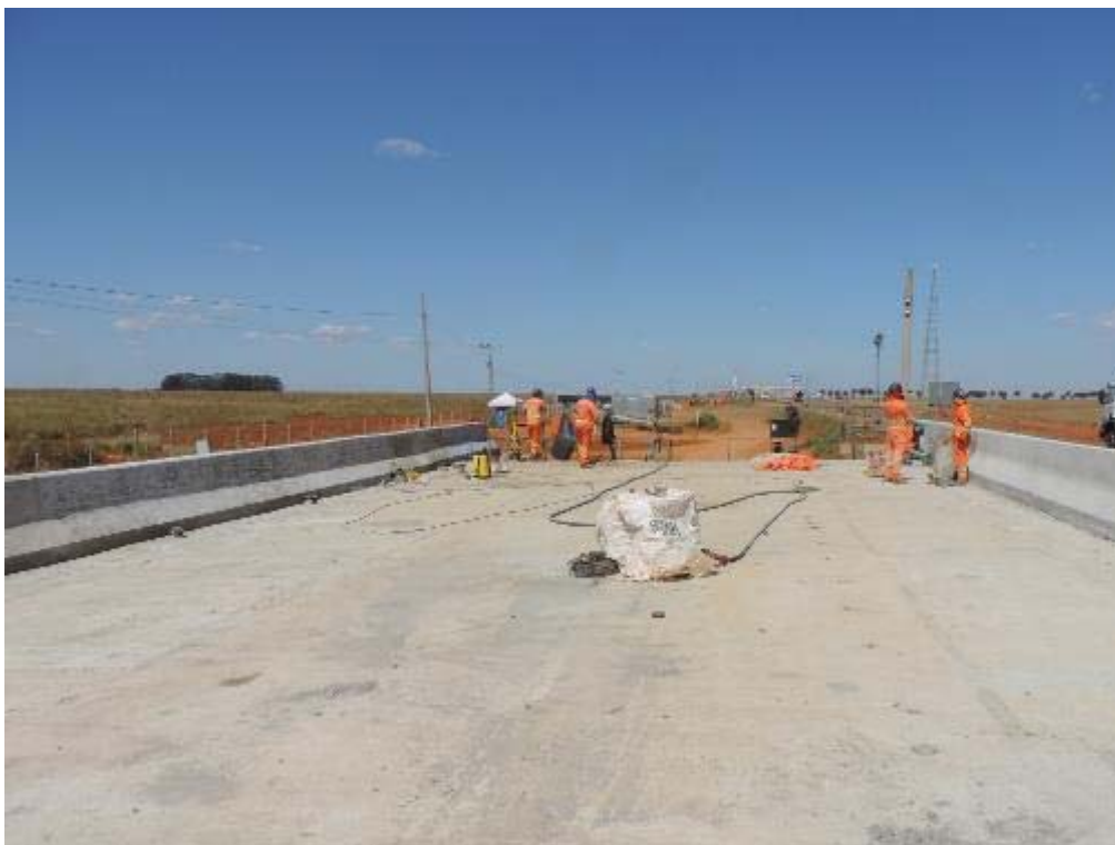
Figura 35 – Acabamento nas New jersey da Passagem sobre a linha férrea – km 34+358.
