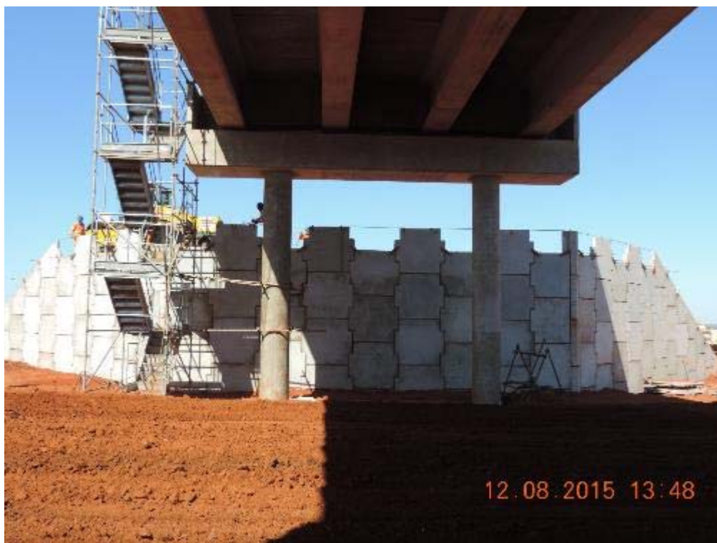
Figura 75 - Muro da terra armada da alça direita do Diamante 03 – km 76+900.
