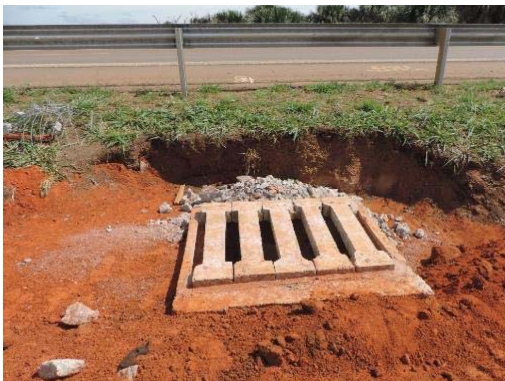
Figura 40 – Caixa coletora do BSTC 800mm na duplicação - km 38+860.
