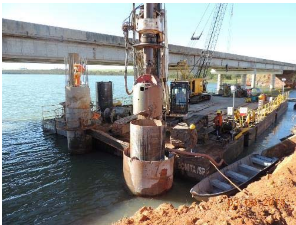
Figura 1 – Escavação de estaca dos pilares na ponte do Rio Correntes – km 0+000
