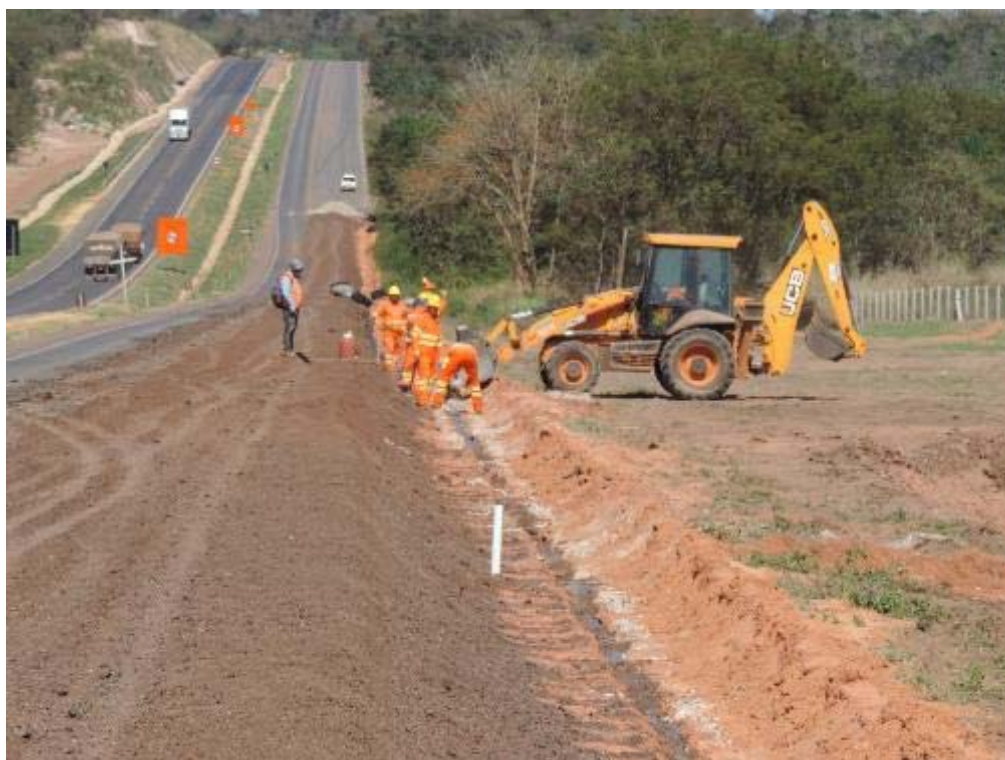
Figura 98 - Dreno do pavimento na recuperação - km 106+710.
