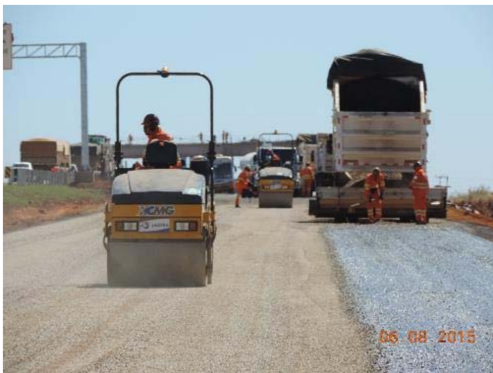
Figura 29 – Primeira camada de TSD na duplicação – km 31+220.
