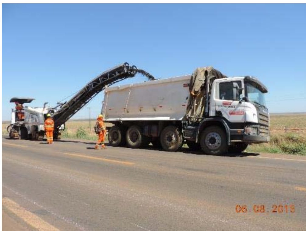
Figura 44 – Execução de fresagem na recuperação - km 40+590.
