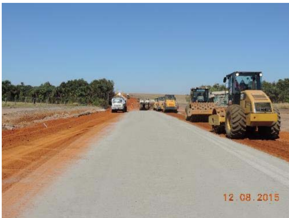
Figura 38 – Sub-base melhorada com cimento na duplicação - km 37+900.
