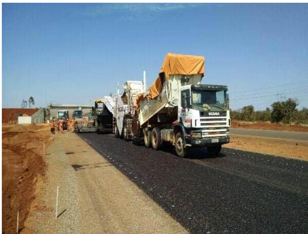
Figura 78 - Primeira camada de CBUQ na duplicação km 76+950.
