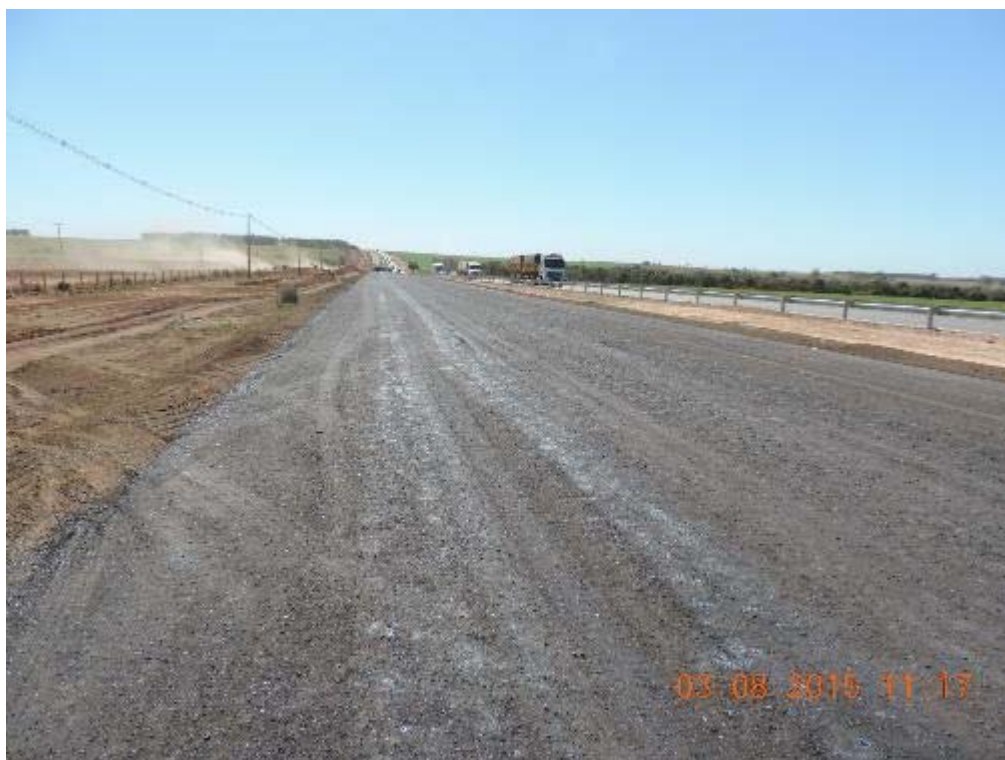
Figura 100 – Imprimação na recuperação - km 108+180.
