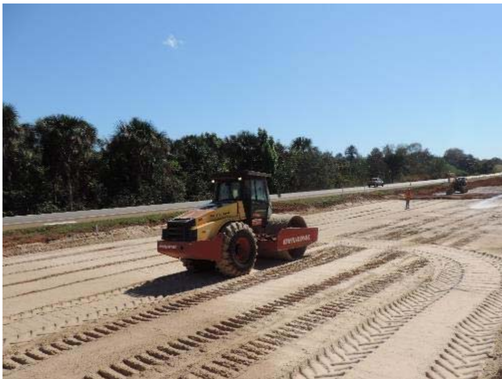
Figura 85 - Compactação de camada de areia sobre solo saturado na duplicação - km 81+000.
