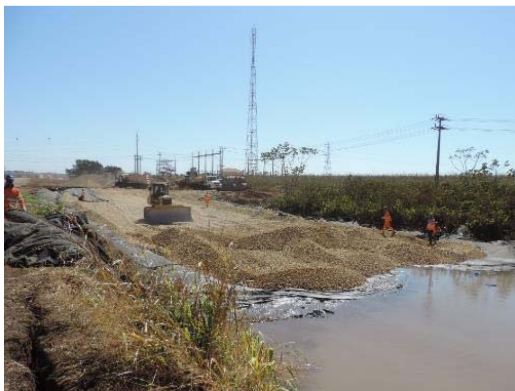
Figura 18 – Lançamento de seixo sobre solo saturado na duplicação – km 23+190.
