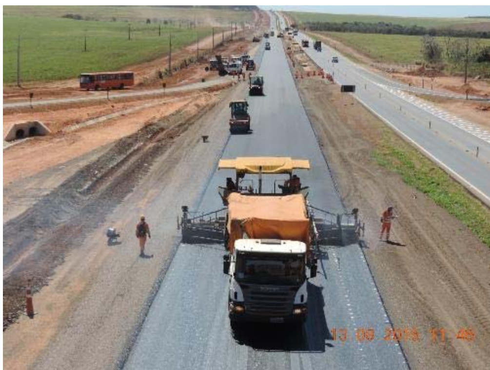
Figura 99 - Segunda camada de CBUQ na recuperação - km 107+250.
