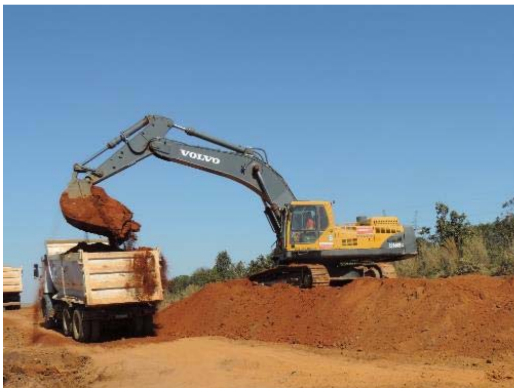
Figura 91 - Escavação de plataforma na duplicação - km 88+830.
