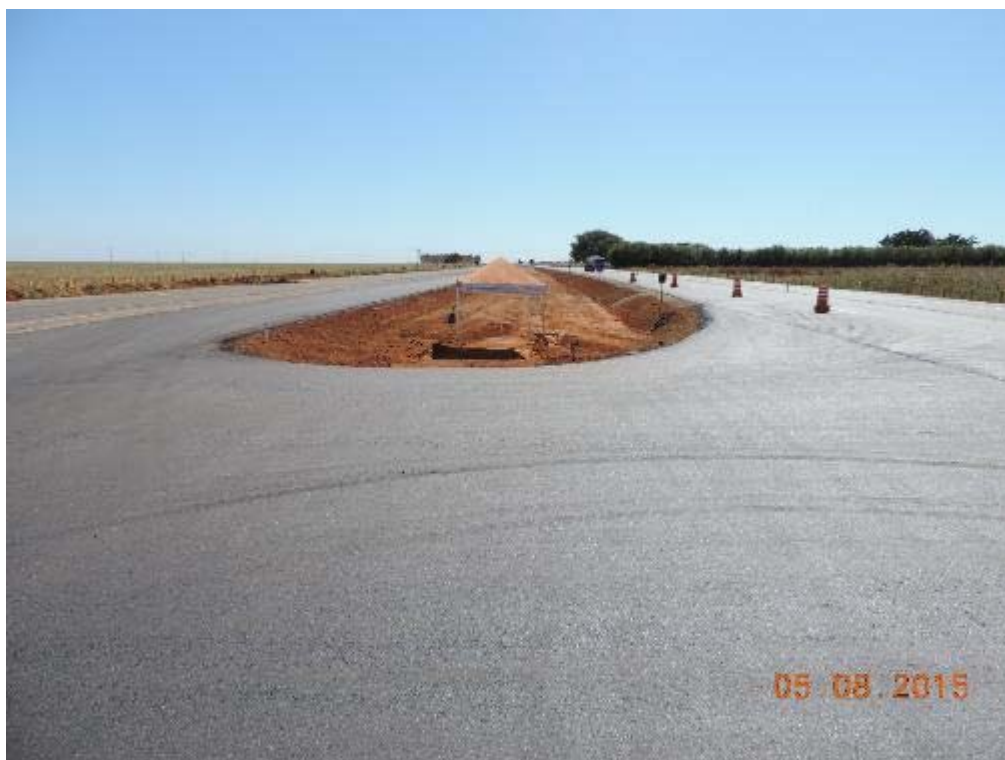
Figura 43 - CBUQ concluído no Retorno em nível 03 – km 39+700.
