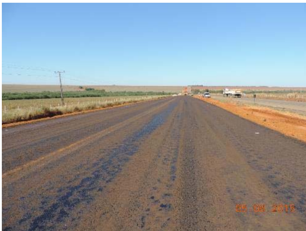
Figura 28 – Imprimação na duplicação – km 31+100.
