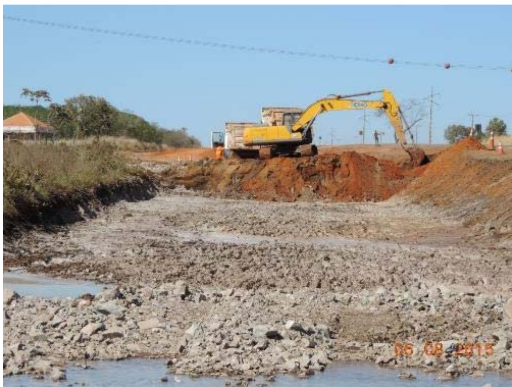
Figura 17 – Escavação de solo saturado na duplicação - km 23+170.
