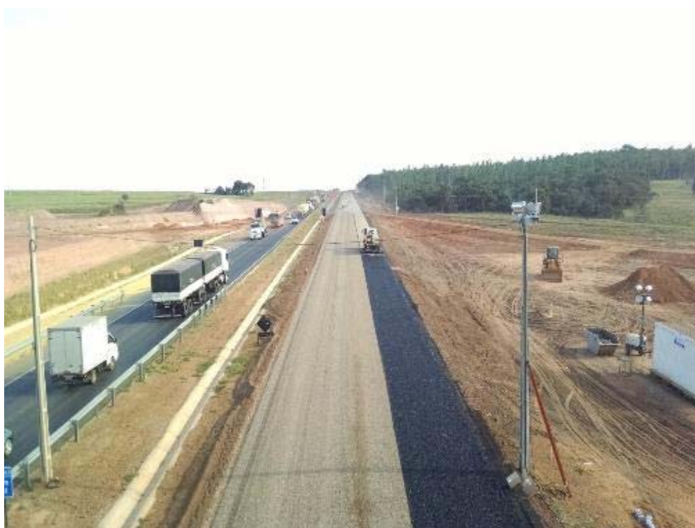
Figura 103 - TSD na recuperação - km 111+000.
