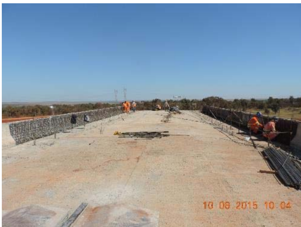
Figura 74 - Armação da New jersey do tabuleiro esquerdo do Diamante 03 – km 76+900.
