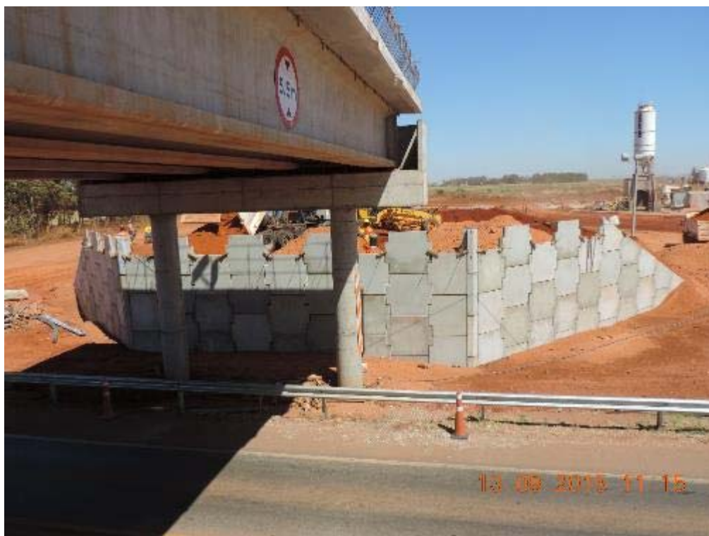
Figura 95 - Muro da terra armada da alça esquerda do Diamante 04 – km 94+300.
