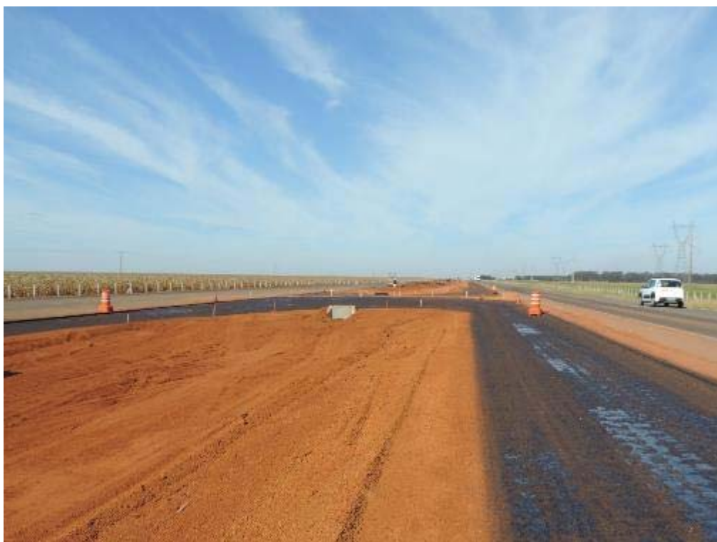
Figura 62 - Imprimação da faixa de desaceleração da pista antiga do Retorno em nível 04 – km 61+900.
