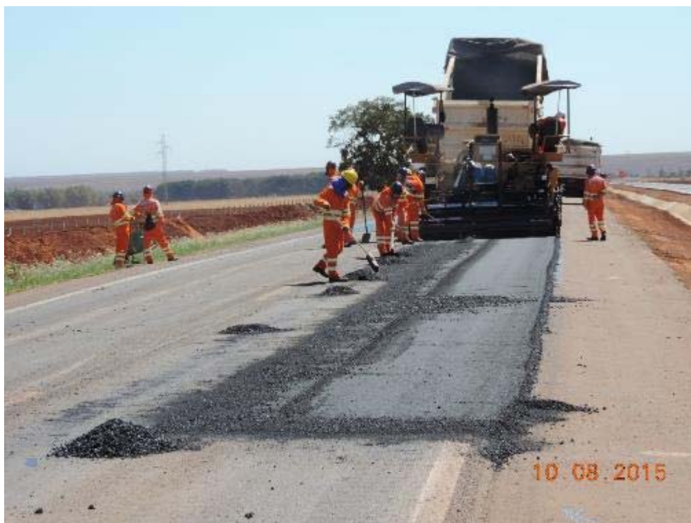
Figura 55 – Recomposição parcial com CBUQ na recuperação - km 52+300.
