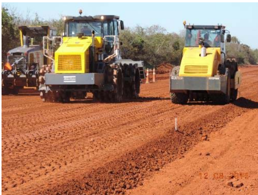
Figura 12 – Compactação da camada de subleito na duplicação - km 18+890.
