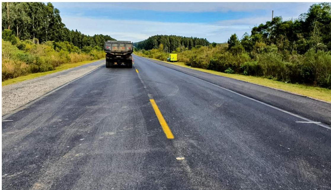
Figura 02 – Serviços de Pavimentação BR-116/RS – Trecho: Pelotas – Jaguarão / km 582,000
