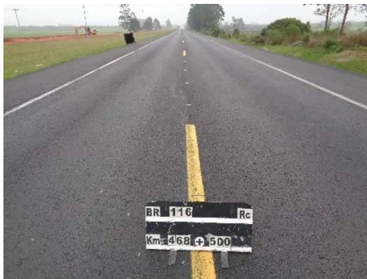
Figura 02 – Serviços de recuperação do pavimento BR-116 km 468+500
