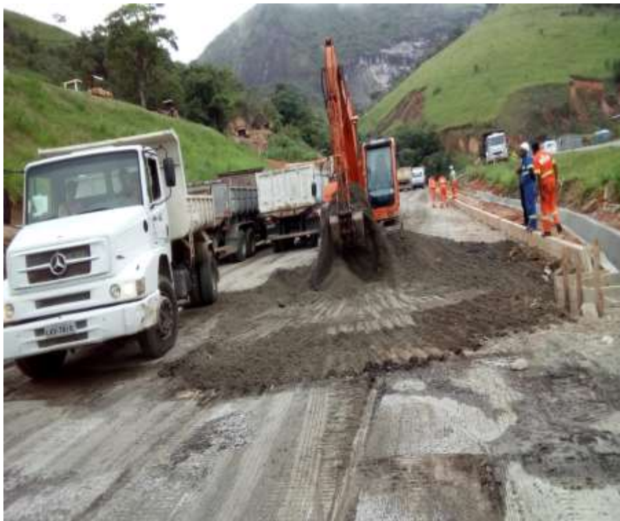
Contenção de encosta - Km 29 - P2 – Remoção da camada granular
