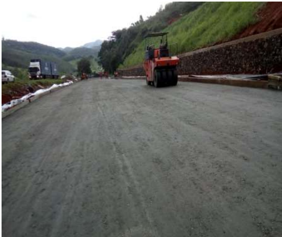
Contenção de encosta - Km 29 - P2 – Execução de base da brita
