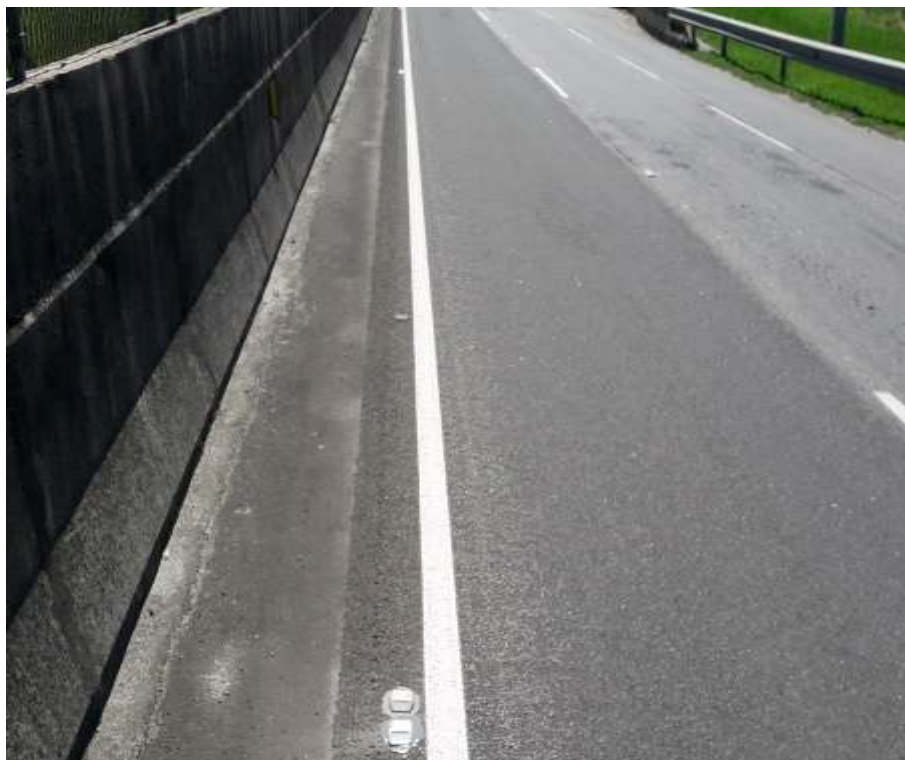
Elementos de Proteção, Contenção e Segurança - Km 120 – P2 – Implantação de tachas
