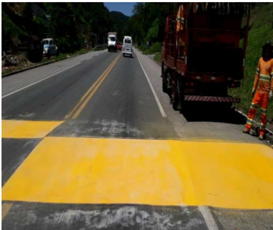
Elementos de Proteção, CONTENÇÃO e Segurança - Km 83,9 – P1 – Pintura de lombada
