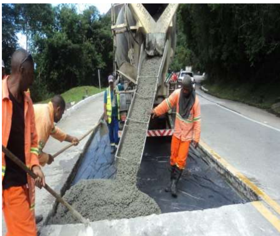
Conservação do pavimento rígido – Km 91 - P1 e P2 – Lançamento de concreto magro
