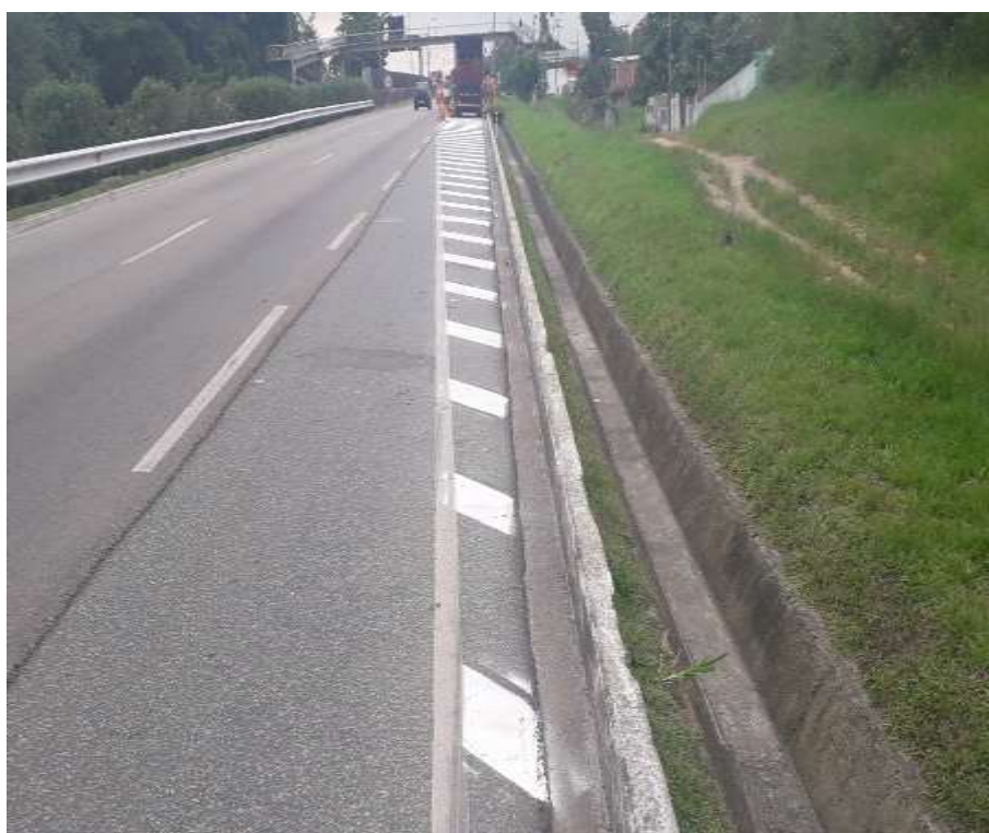
Elementos de Proteção, CONTENÇÃO e Segurança - Km 133,9– P1 – Pintura de zebrado
