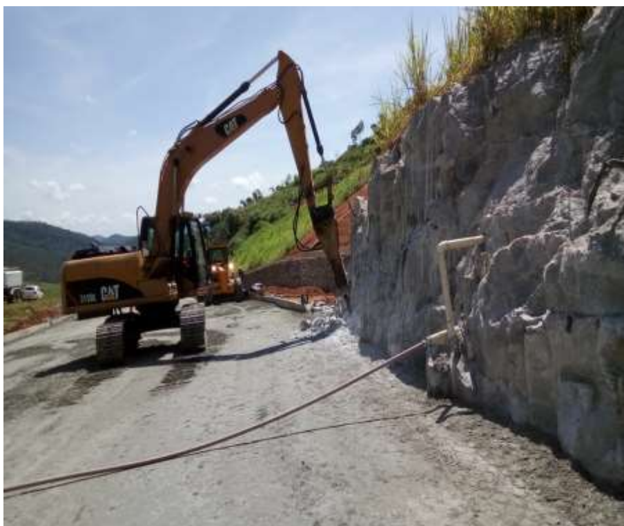
Contenção de encosta - Km 29 - P2 – Demolição bloco de rocha
