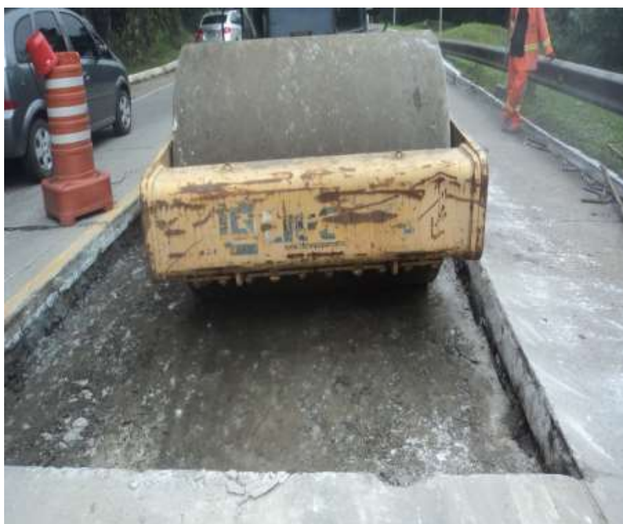
Conservação do pavimento rígido – Km 91 - P1 e P2 – Compactação
