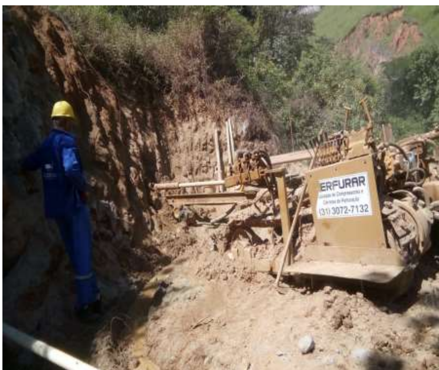
Contenção de encosta - Km 29 - P2 – Execução de dreno profundo simples
