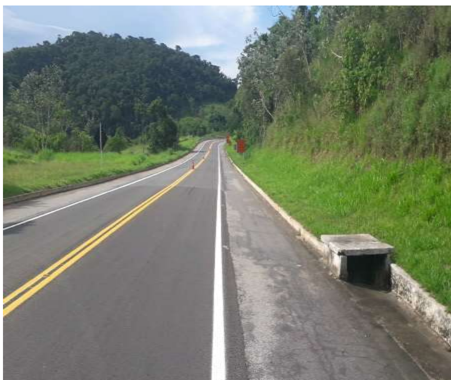
Elementos de Proteção, CONTENÇÃO e Segurança - Km 27,1 – P1 – Pintura de bordo
