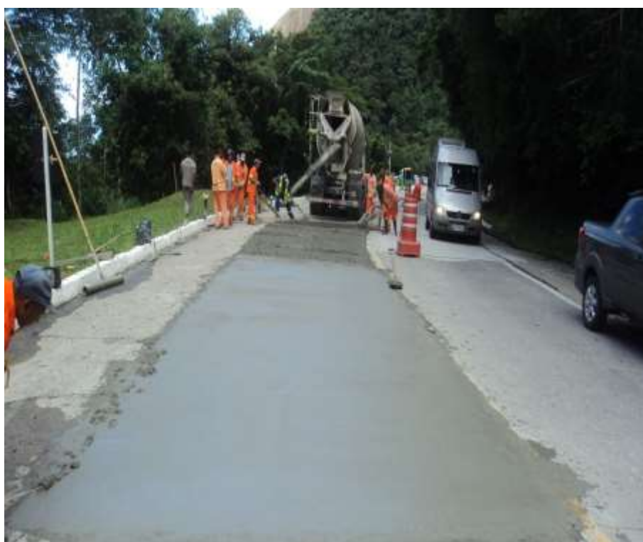
Conservação do pavimento rígido – Km 91 - P1 e P2 – Lançamento de concreto estrutural
