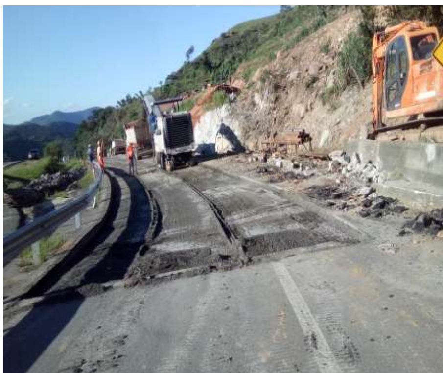
Contenção de encosta - Km 29 - P2 – Execução de fresagem com revestimento betuminoso
