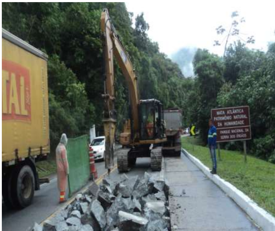
Conservação do pavimento rígido – Km 91 - P1 e P2 – Demolição de placa de concreto
