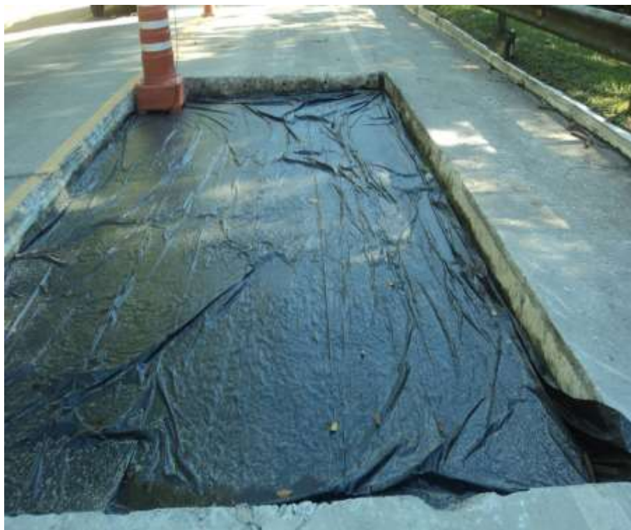
Conservação do pavimento rígido – Km 91 - P1 e P2 – Impermeabilização
