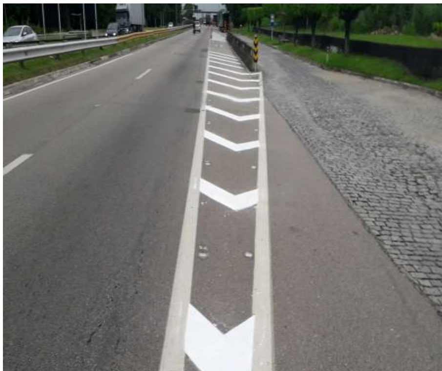
Elementos de Proteção, CONTENÇÃO e Segurança - Km 133,6– P1 – Pintura de zebrado
