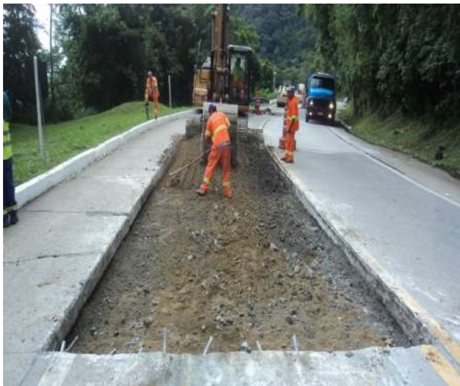
Conservação do pavimento rígido – Km 91 - P1 e P2 – Preparação do fundo
