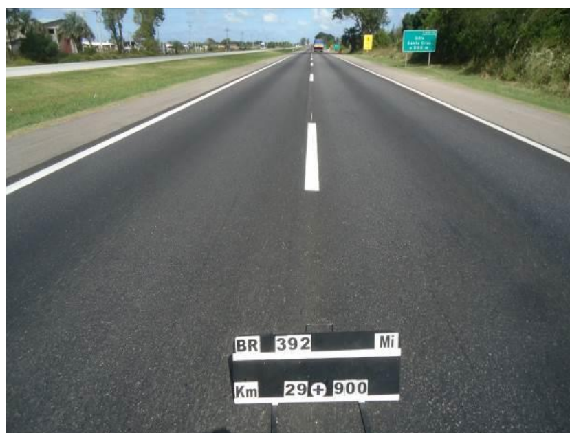
Figura 03 – Manutenção do Pavimento – BR-392/RS
