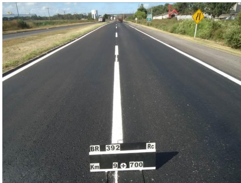
Figura 02 – Manutenção do Pavimento – BR-392/RS
