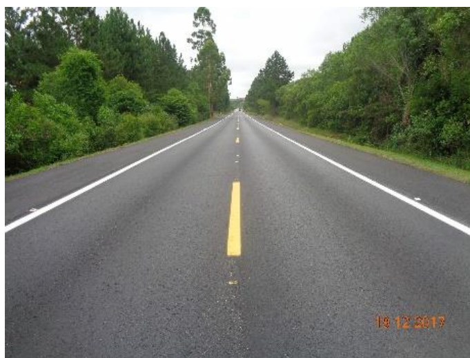
Figura 02 – Serviços de recuperação do pavimento BR-116 km 488+000 ao 495+000
