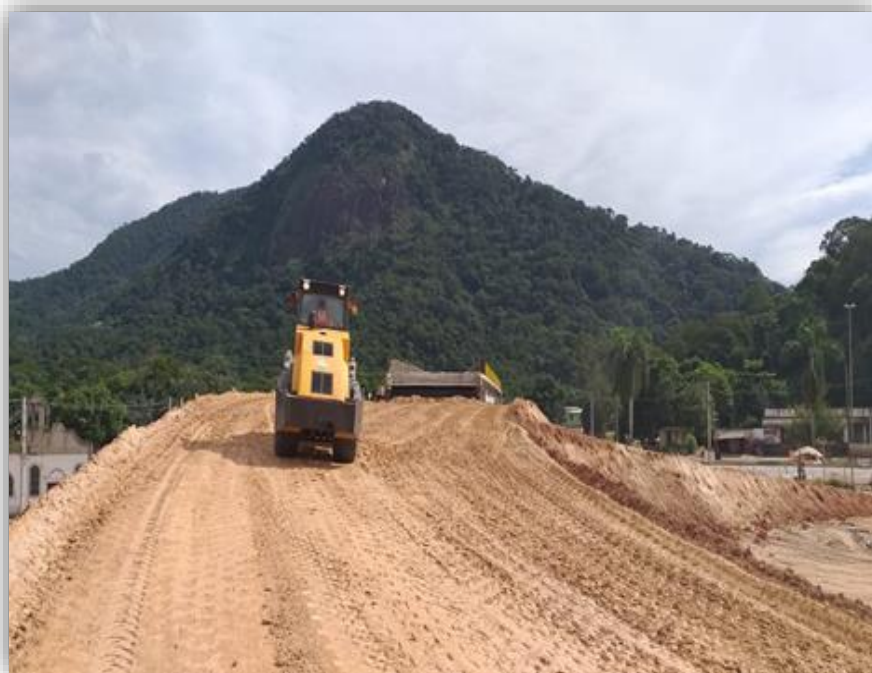
Figura 04 – Homogeneização em camada de aterro - km 236
