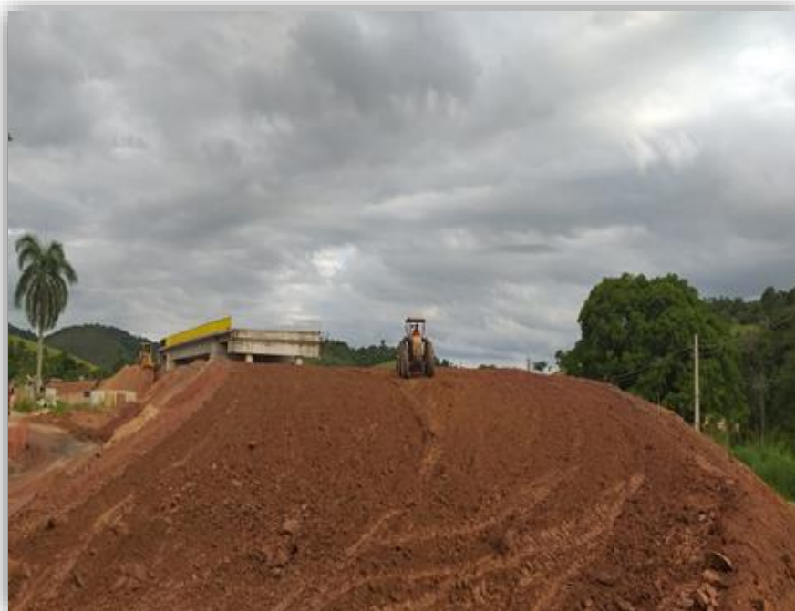
Figura 03 – Homogeneização em camada de aterro - km 236
