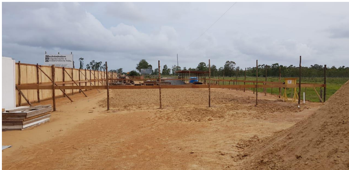
Figura 04 – Serviços de Montagem dos Gabaritos e Locação de Obra – Base Operacional - BR-392/RS – Trecho: Pelotas – Rio Grande / km 033,059
