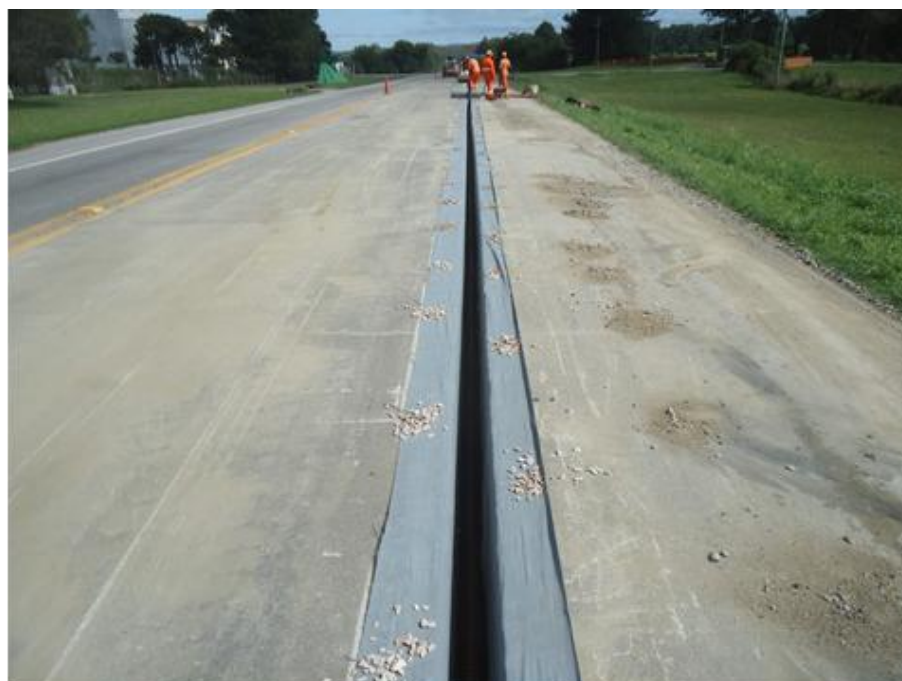
Figura 05 – Drenos de Pavimento
