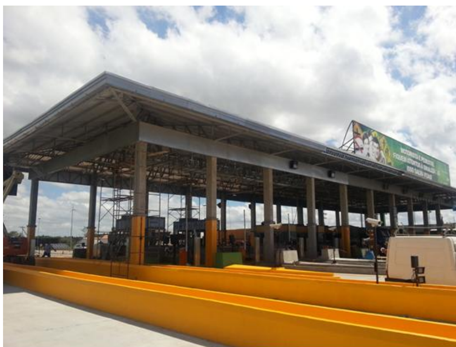
Figura 09 – Ampliação da Praça de Pedágio Capão Seco
