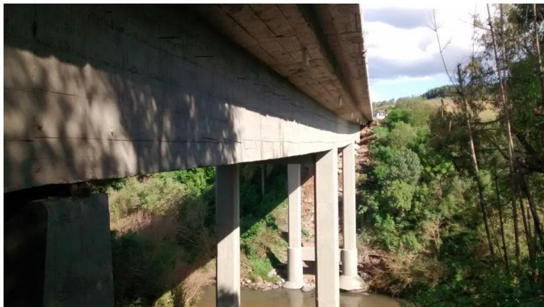
Figura 06 – Obras de Arte Especiais
