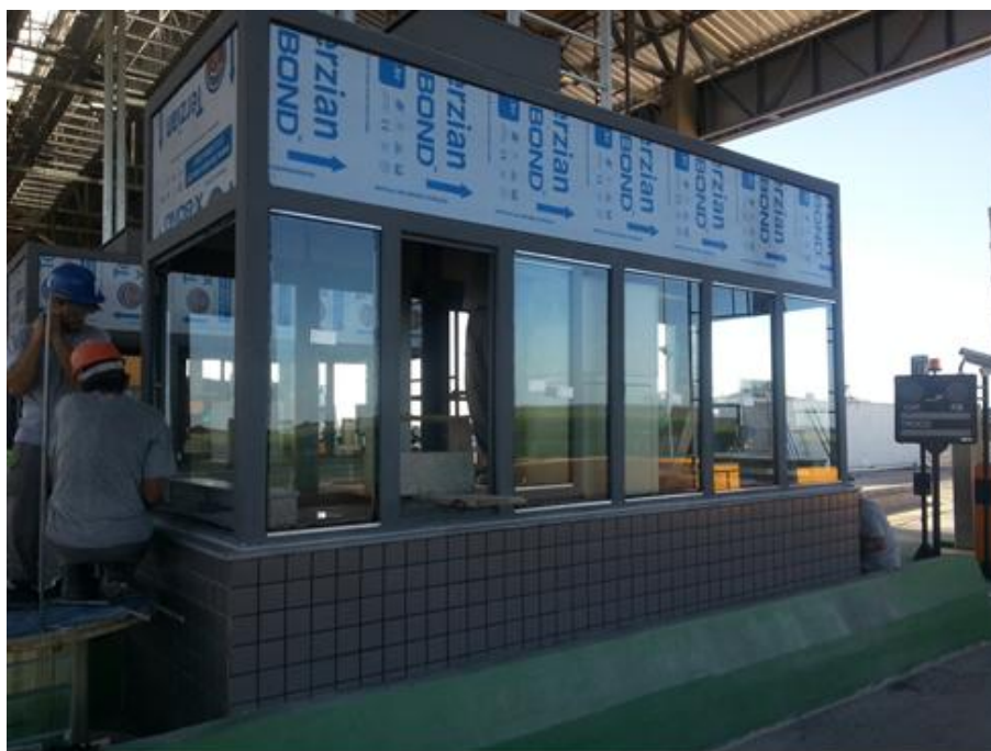
Figura 08 – Ampliação da Praça de Pedágio Capão Seco
