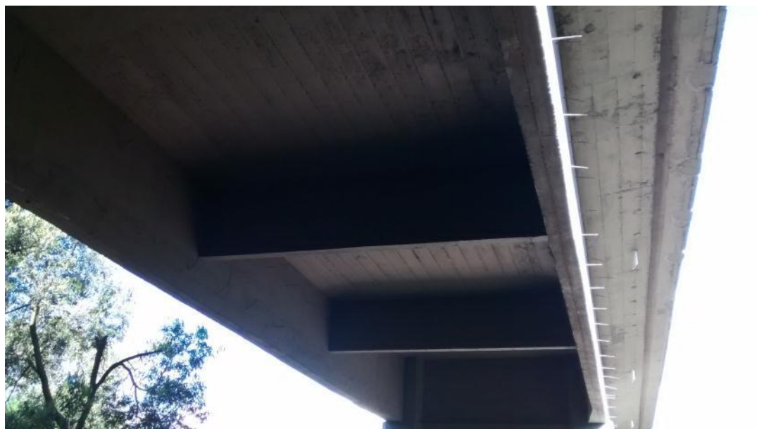
Figura 07 – Obras de Arte Especiais
