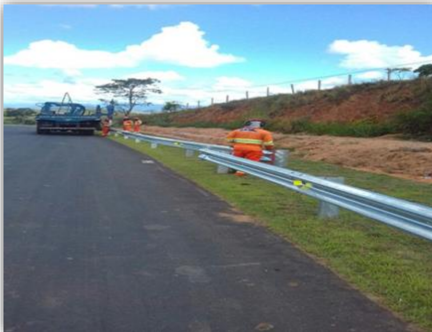
Figura 01 – Implantação de Defesa Metálica
