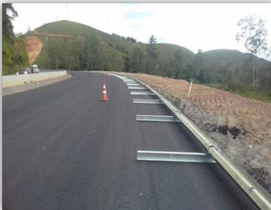
Figura 02 – Implantação de Defesa Metálica
