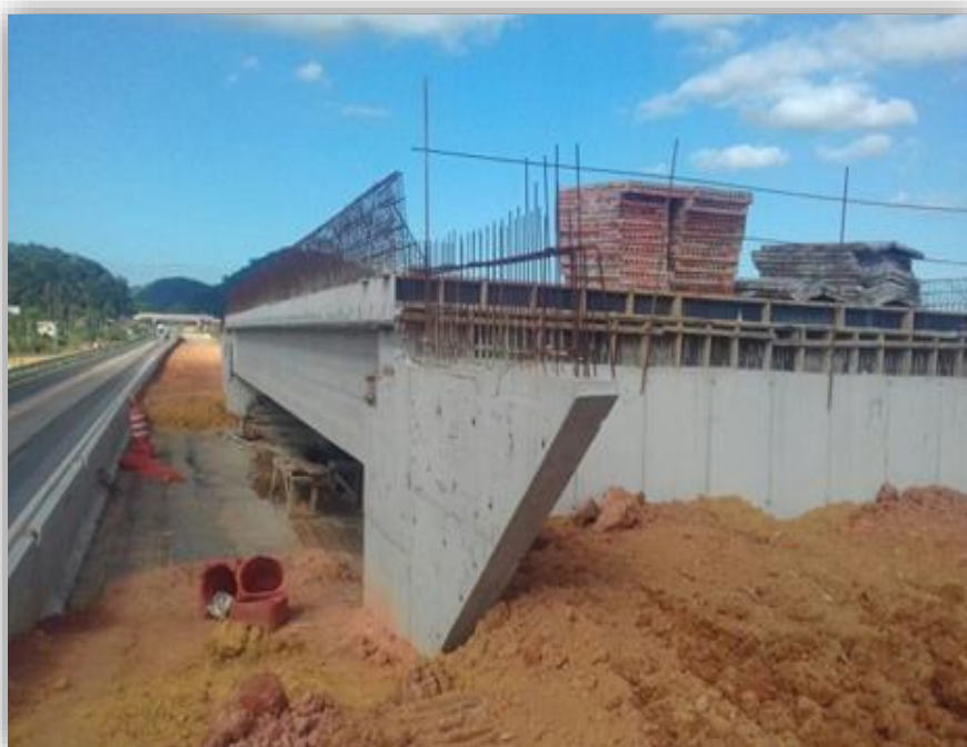
Figura 06 – Desforma da ala – km 244
