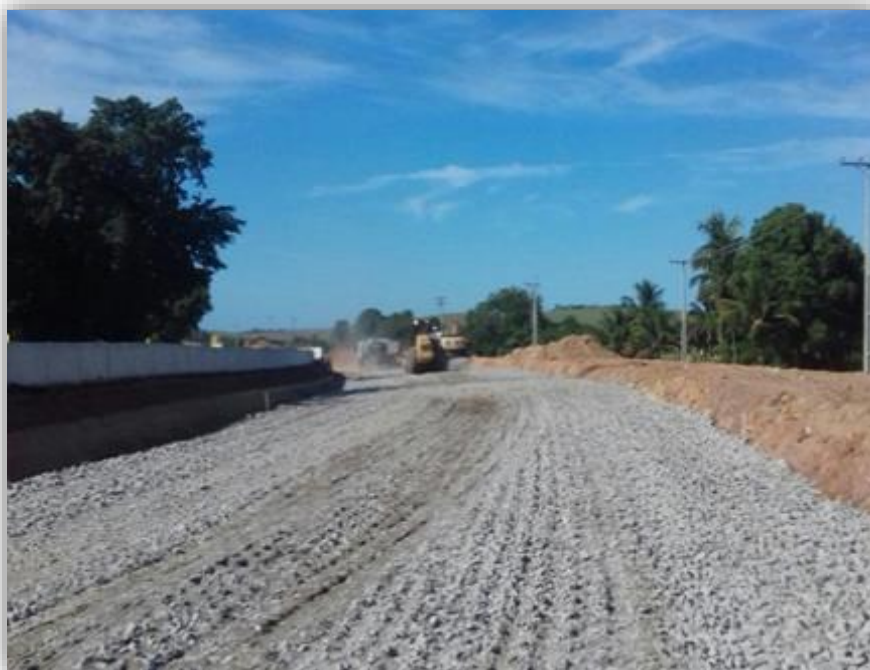
Figura 02 – Pavimentação – Sub-base
