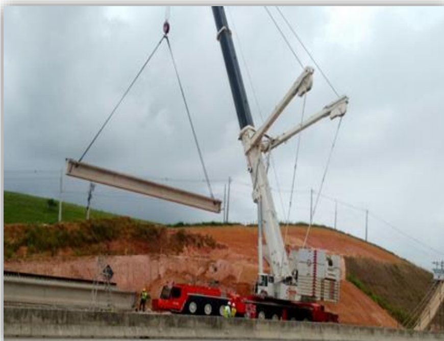
Figura 04 – Lançamento de vigas – km 194
