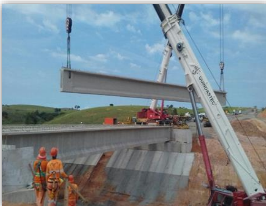
Figura 02 – Lançamento de vigas – km 92,800
