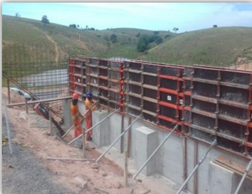
Figura 01 – Forma dos blocos de encontro – km 92,800
