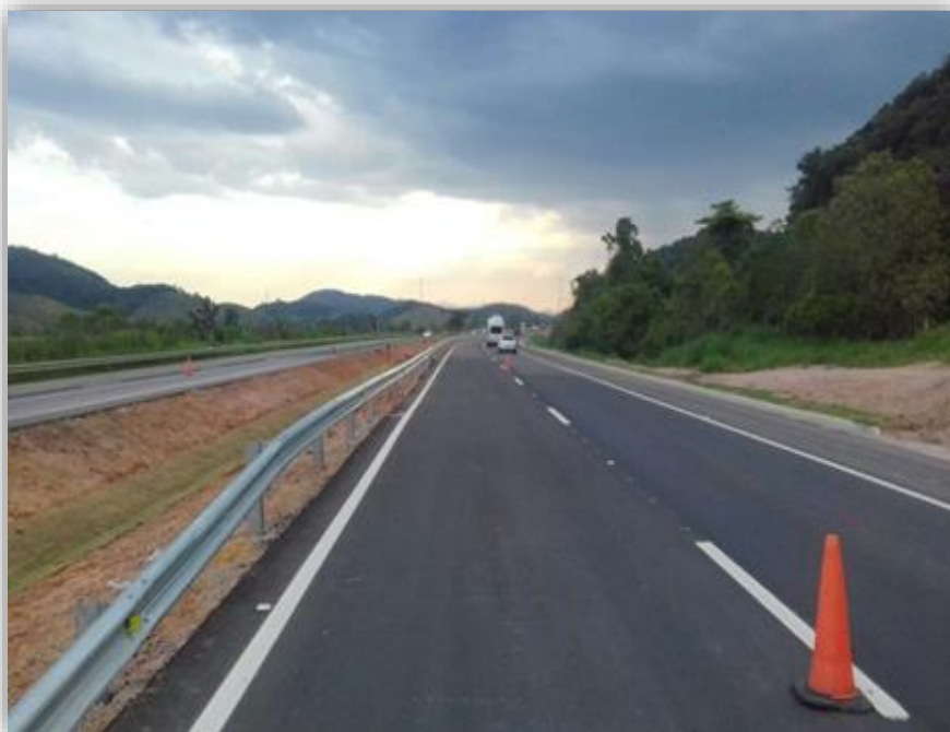
Figura 01 – Implantação de Defesa Metálica
