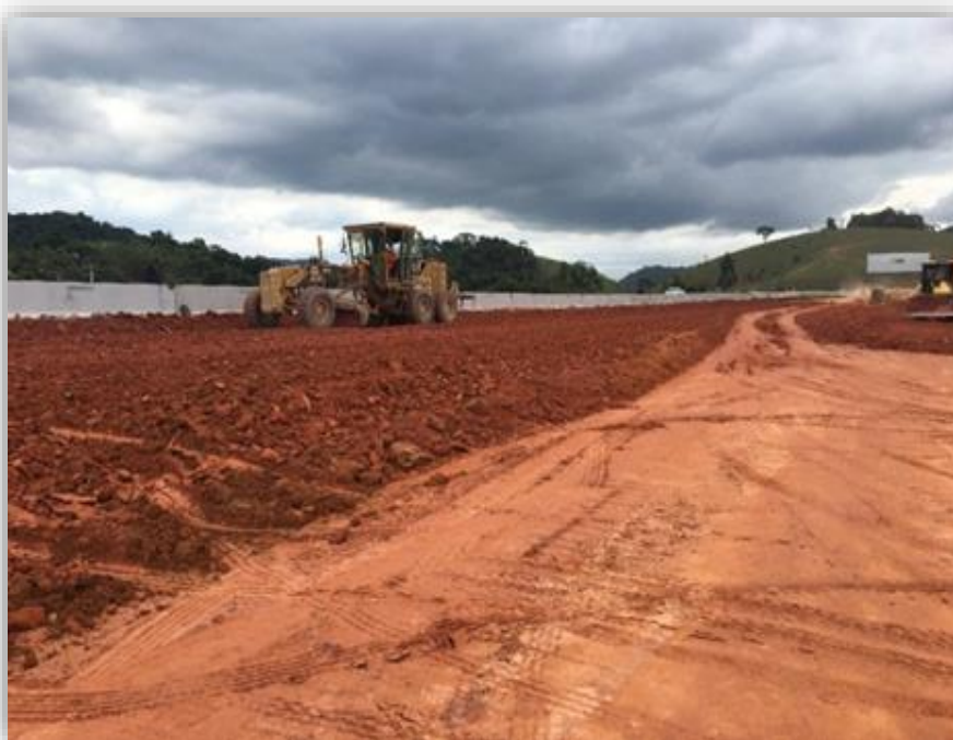
Figura 07 – Aterro de elevação do greide – km 248,1
