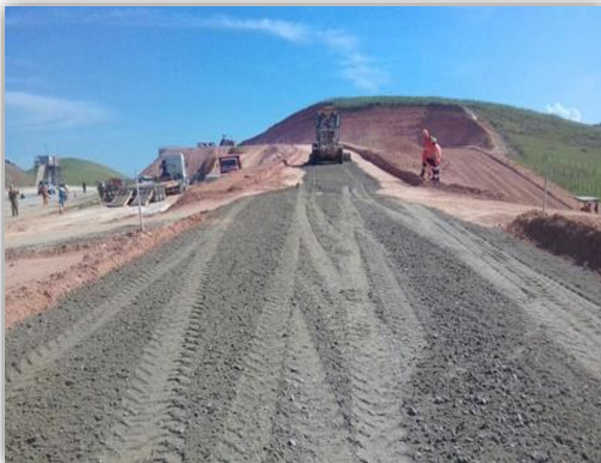
Figura 03 – Aplicação de sub Base – km 194
