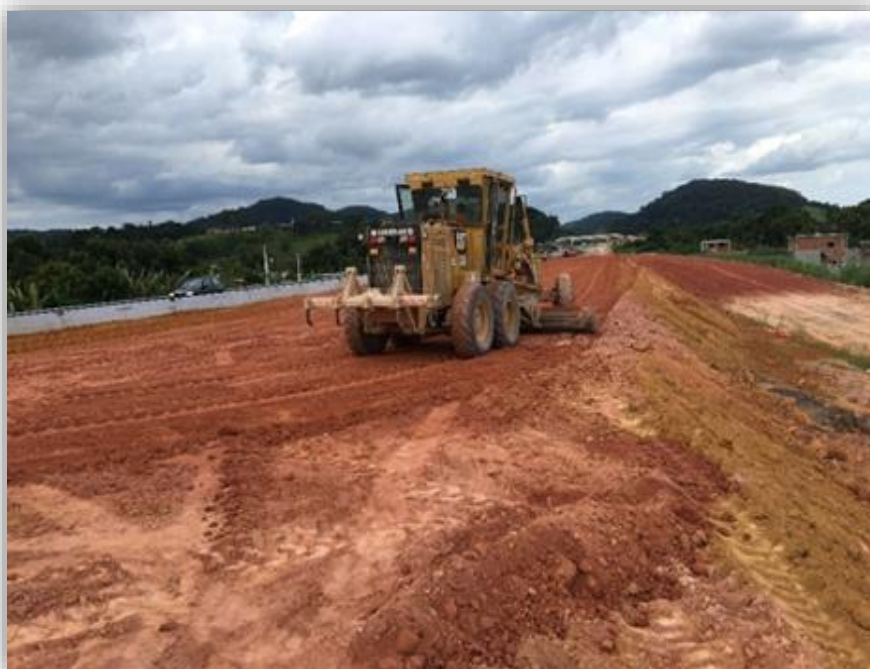
Figura 05 – Aterro de elevação do greide – km 244
