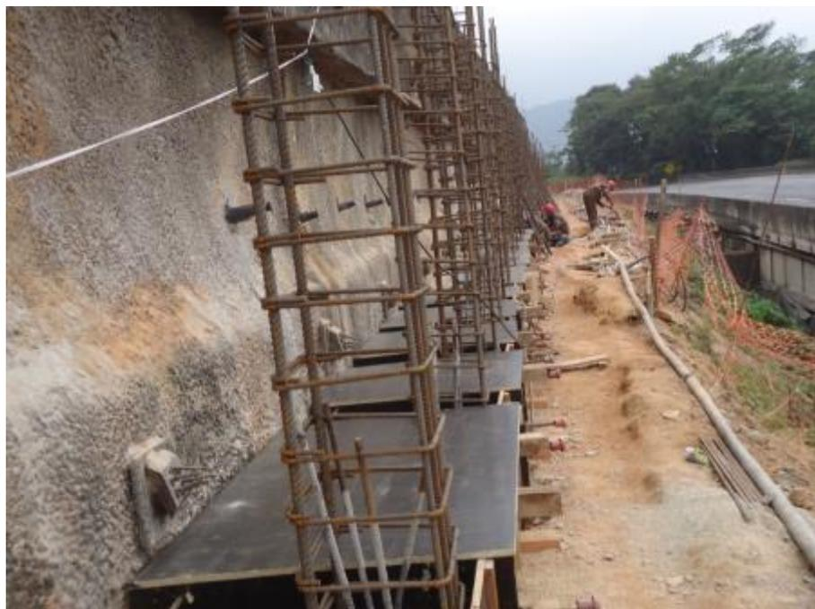
*Figura 04 – Armações dos pilares*
