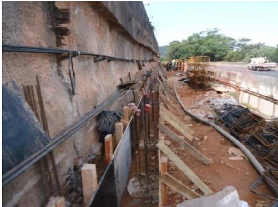
*Figura 06 – Montagem de formas dos pilares*
