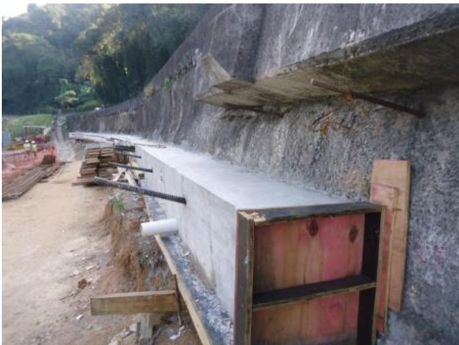
*Figura 02 – Viga de coroamento concretada*
