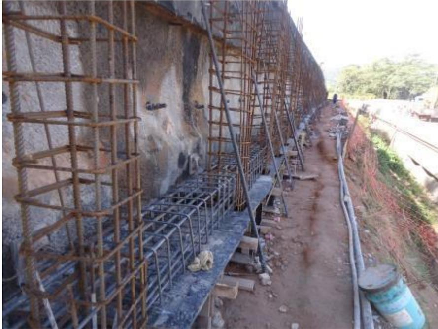
*Figura 05 – Armações dos pilares*
