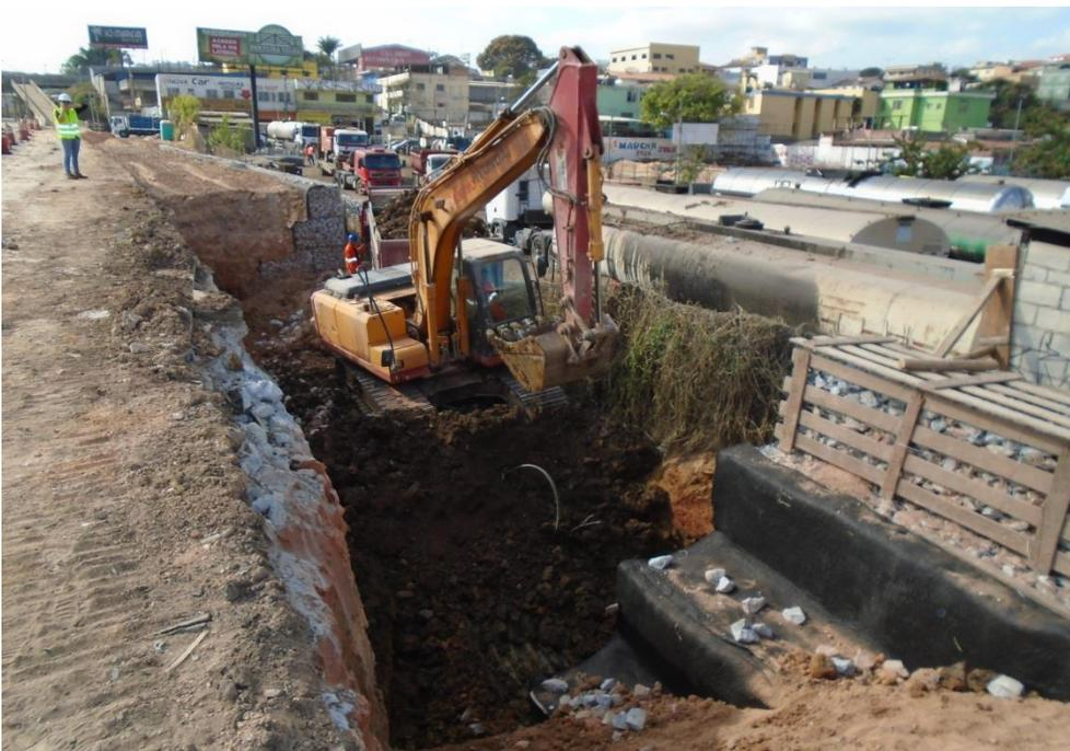
*Figura 04 – Escavação - Muro em Gabião*
