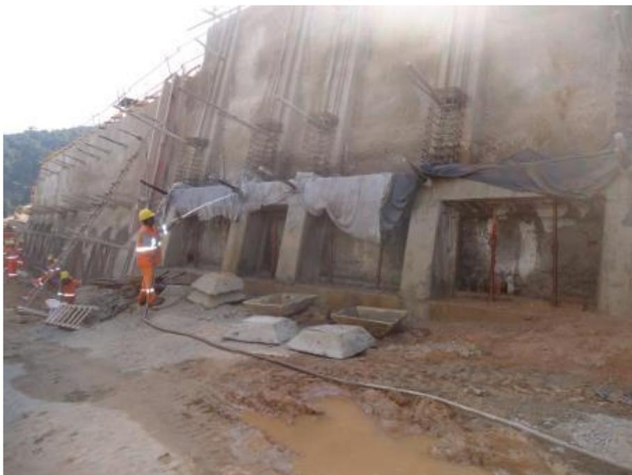
*Figura 02 – Montagem das armações e formas dos pilares no painel E*
