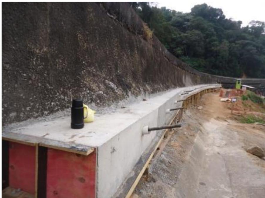
*Figura 01 – Viga de coroamento concretada*
