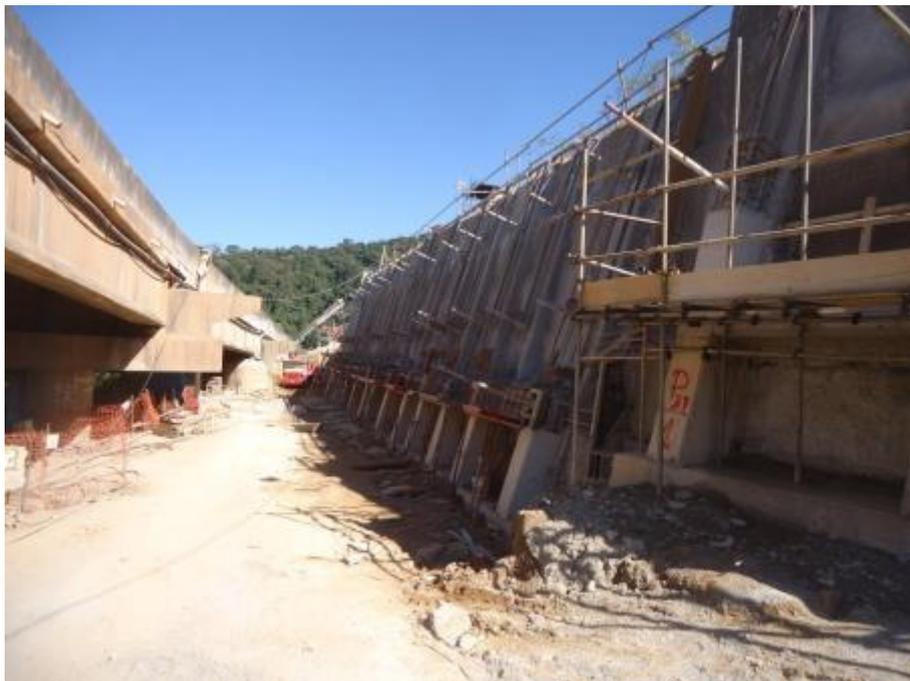
*Figura 05 – Armações e formas dos pilares e viga no painel D*
