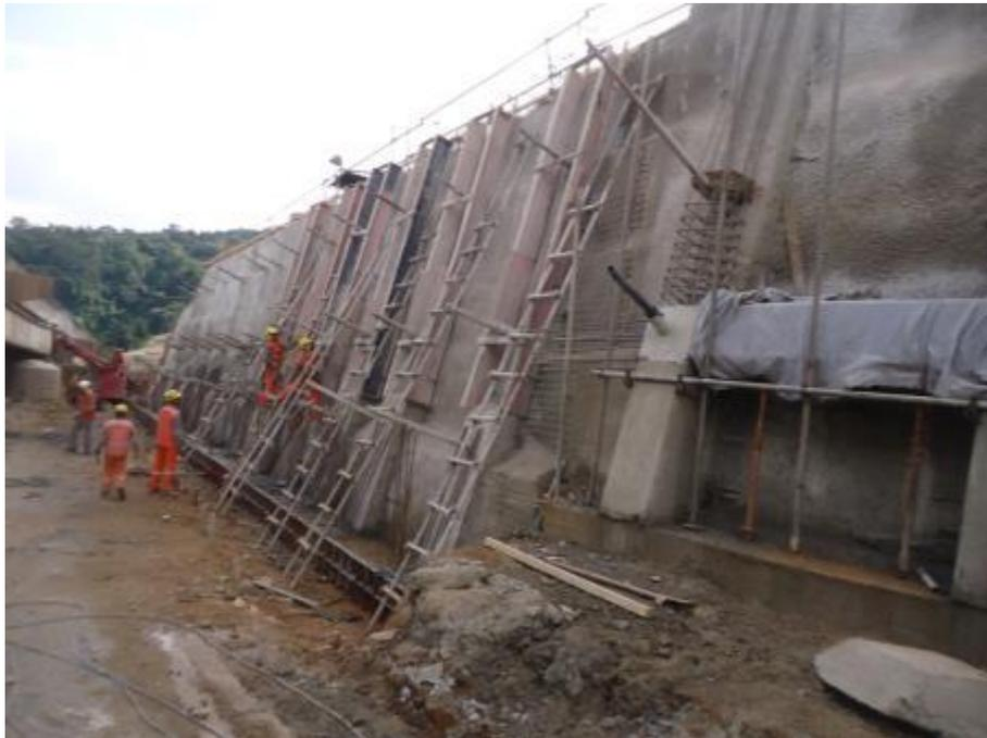
*Figura 03 – Montagem das armações e formas dos pilares no painel D*
