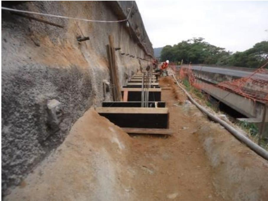
*Figura 03 – Montagem de formas dos pilares*
