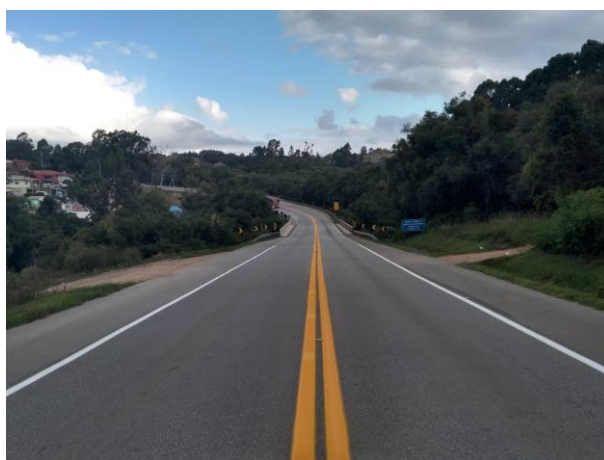
Figura 03 – Serviços de sinalização horizontal BR-392/RS – Trecho: Pelotas – Santana da Boa Vista / km 118,300
