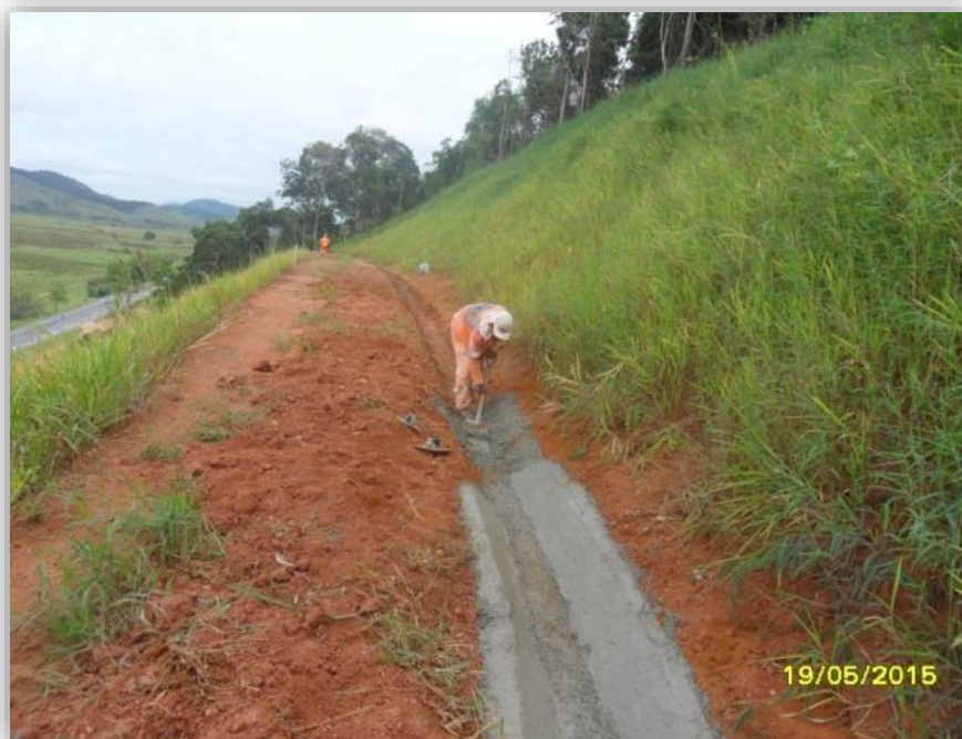
Figura 03 – Concretagem canaleta
