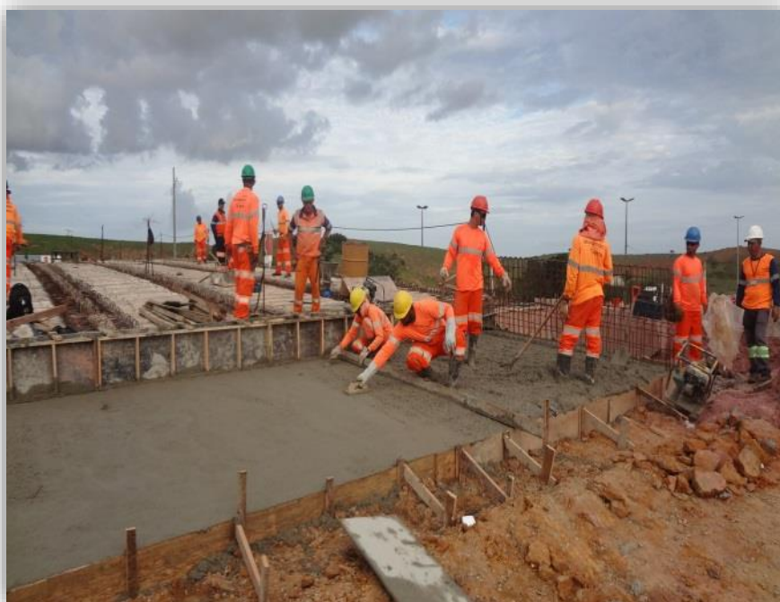
Figura 02 – Concretagem de laje de aproximação do Trevo em Desnível - km 138,500
