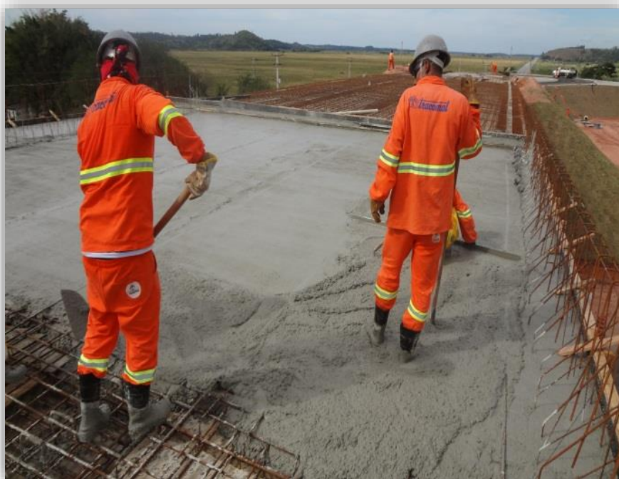
Figura 01 – Concretagem do tabuleiro da OAE do Trevo em Desnível - km 125,000
