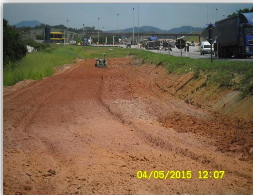
Figura 04 – 2ª Camada de aterro
