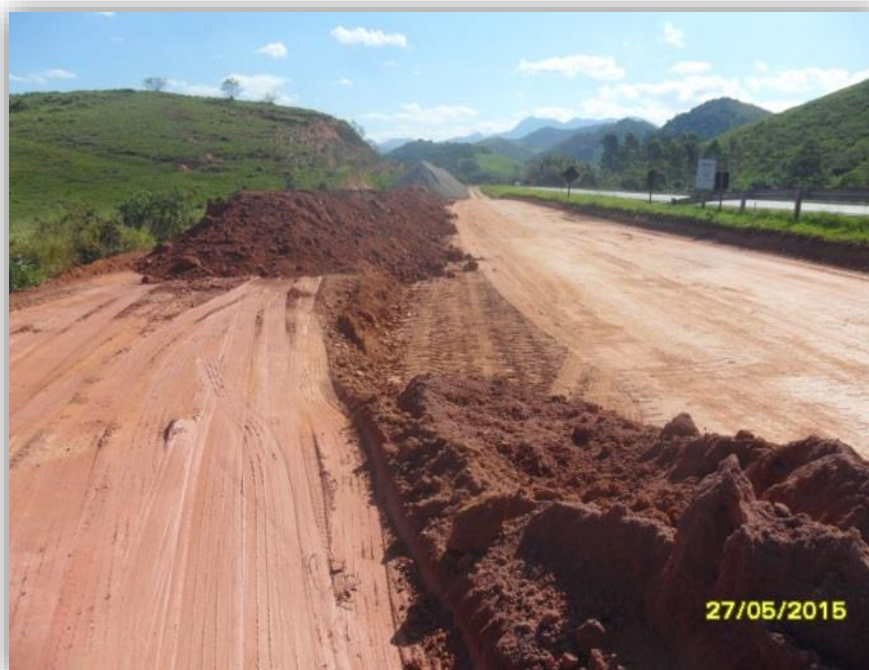
Figura 02 – Camada local de drenagem
