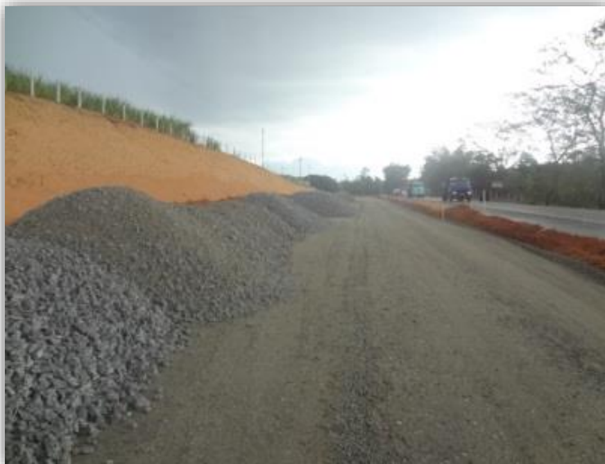
Figura 01 – Lançamento de sub-base
