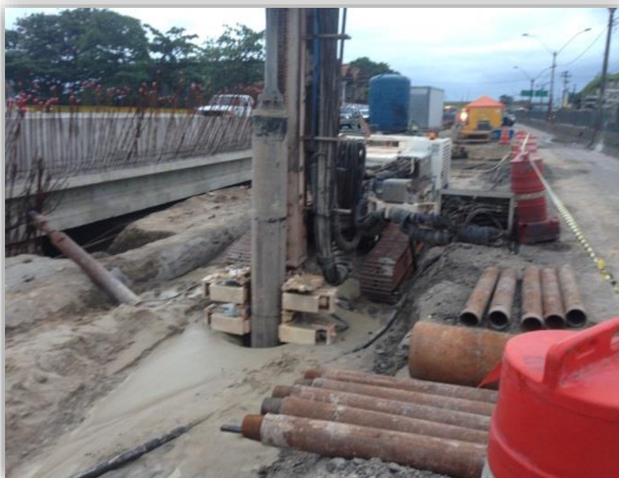
Figura 02 – Reinício estaca raiz da OAE
