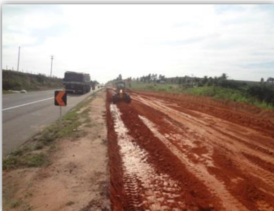
Figura 02 – Regularização da camada de sub-leito
