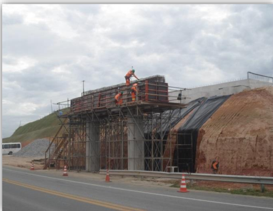
Figura 04 – Montagem das formas do apoio da viga– Obra de Arte Especial - km 253,600
