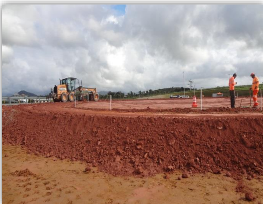
Figura 03 – Aterro de rotatória e elevamento – Trevo em Desnível - km 144,500
