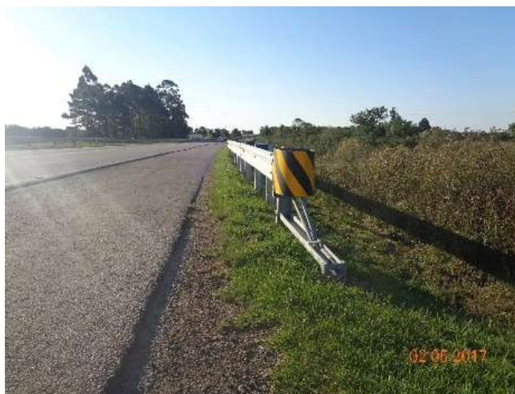
Figura 06 – Implantação defensas metálicas BR-392
