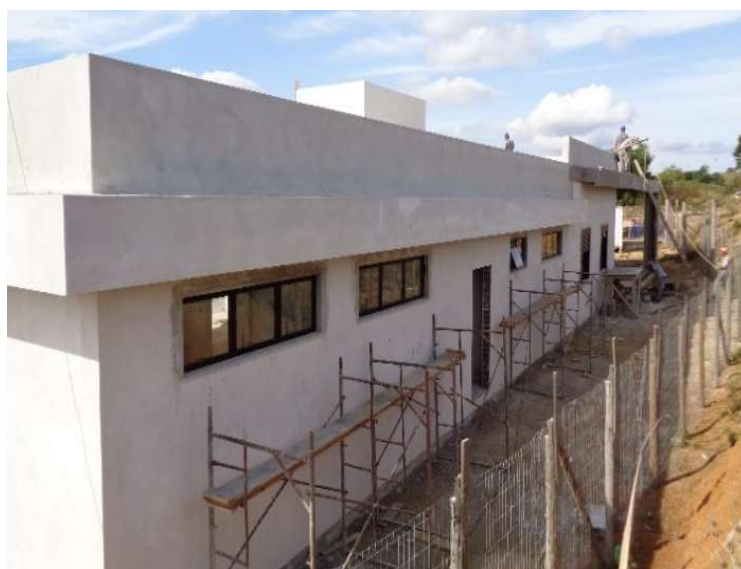
Figura 05 – Construção Bases Operacionais BR-116 km 125+700 LE
