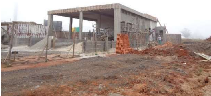
Figura 03 – Construção Bases Operacionais BR-116 km 524+000 LD
