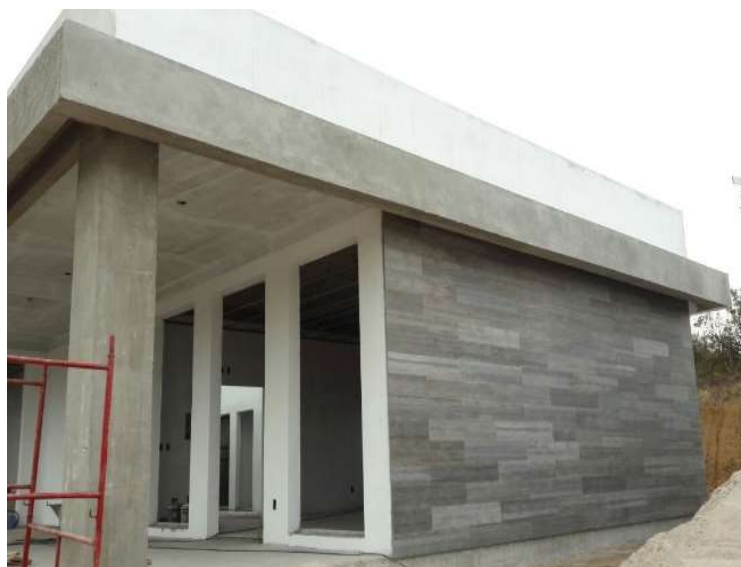
Figura 04 – Construção Bases Operacionais BR-116 km 607+000 LE
