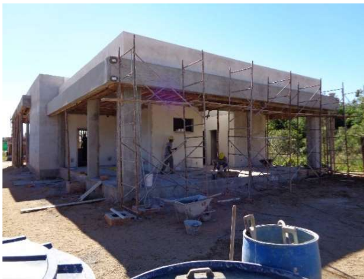
Figura 02 – Construção Bases Operacionais BR-116 km 492+000 LE
