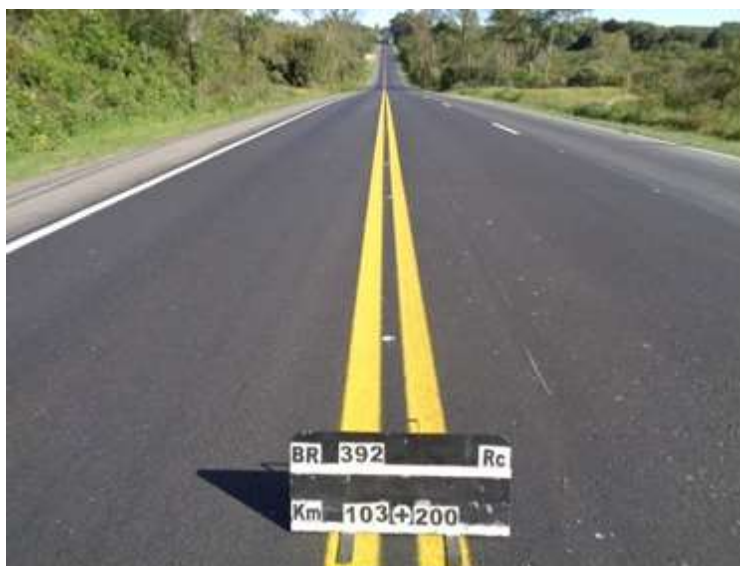
Figura 03 – Recuperação do Pavimento – BR-392/RS
