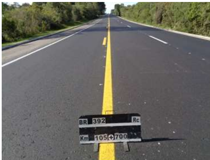
Figura 02 – Recuperação do Pavimento – BR-392/RS
