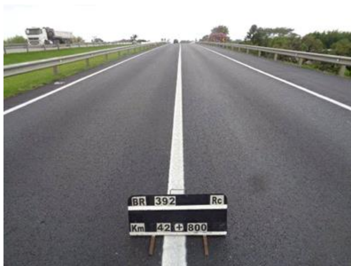
Figura 02 – Serviços de recuperação do pavimento BR-392 km 42+800
