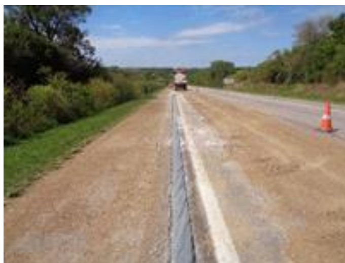
Figura 03 – Drenos de Pavimento BR-392 km 134+000 ao 176+000
