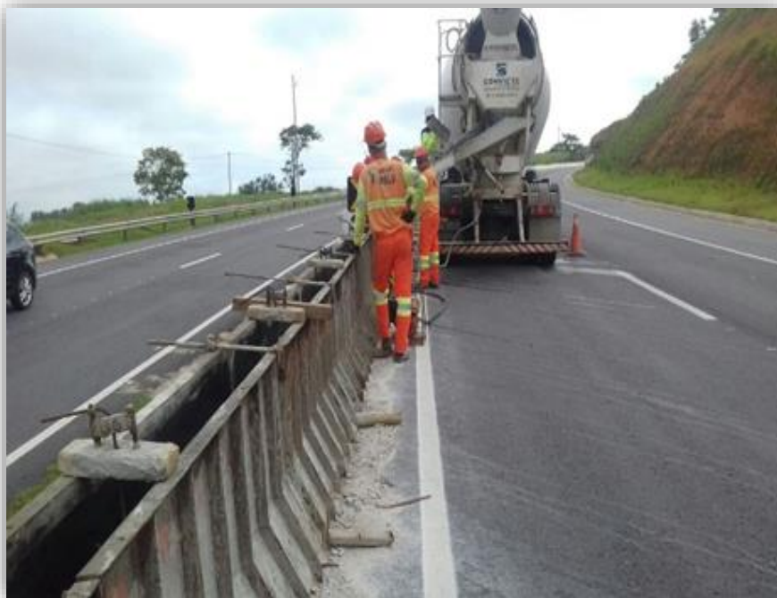
Figura 01 - Concretagem de New Jersey
