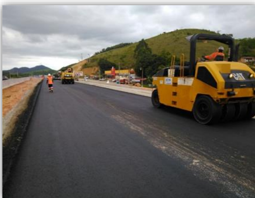
Figura 04 – Aplicação de massa CBUQ (binder) - km 248,1
