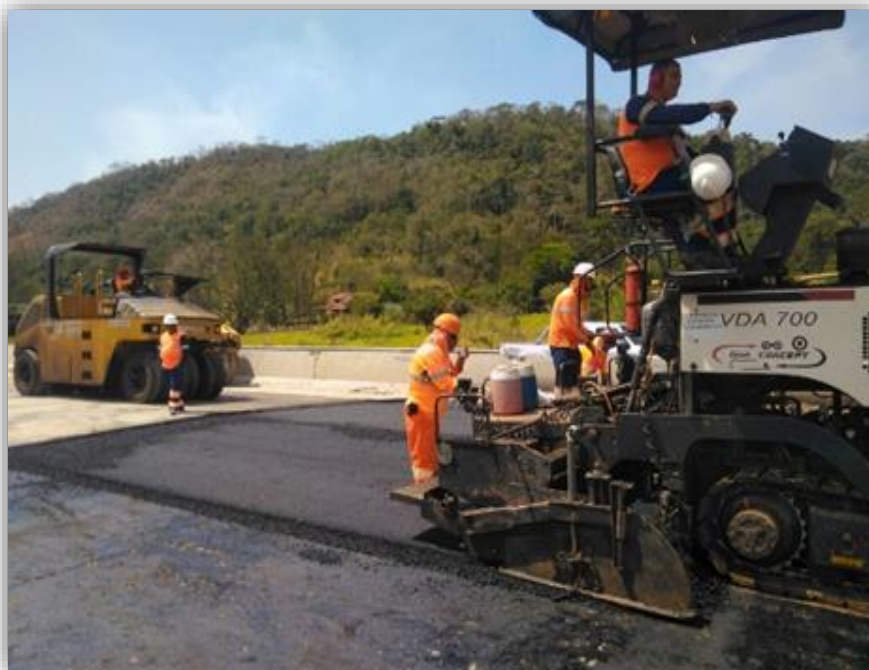
Figura 01 – Aplicação de massa (CBUQ) capa
