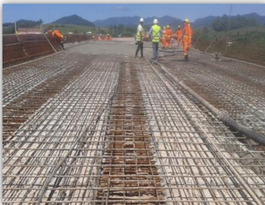
Figura 03 – Armação da laje do tabuleiro pronta - km 244
