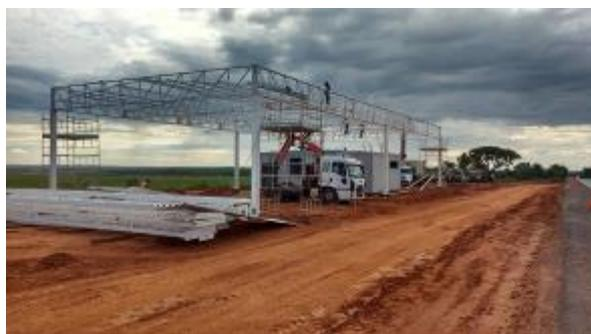
*SAU 9 – Edificação concluída e execução da cobertura metálica*
