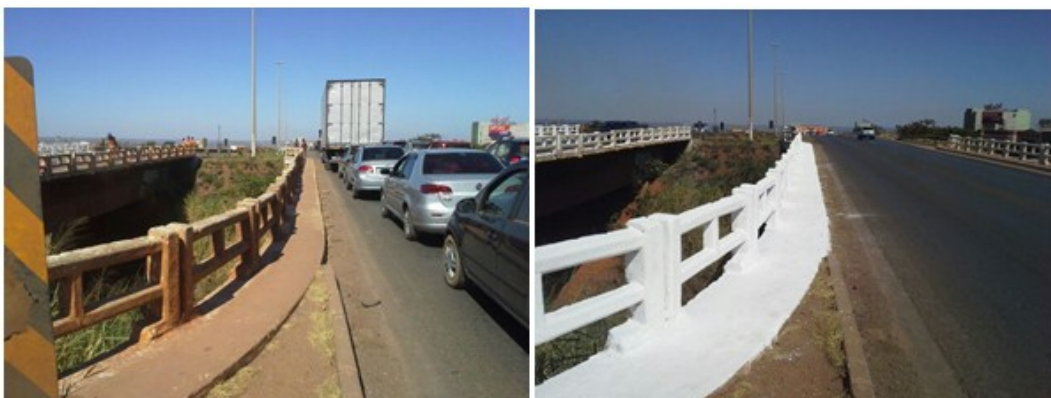
Imagem 4: antes e depois nas frentes de conservação (GO)
