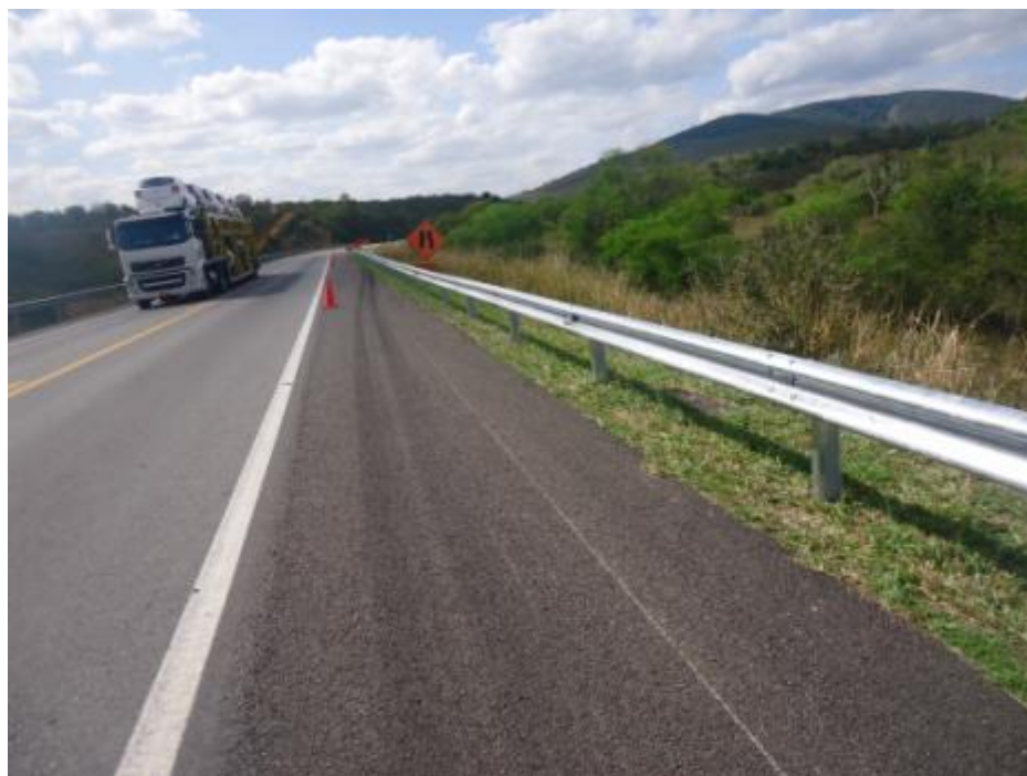
Figura 06 – Implantação de Defensas Metálicas
