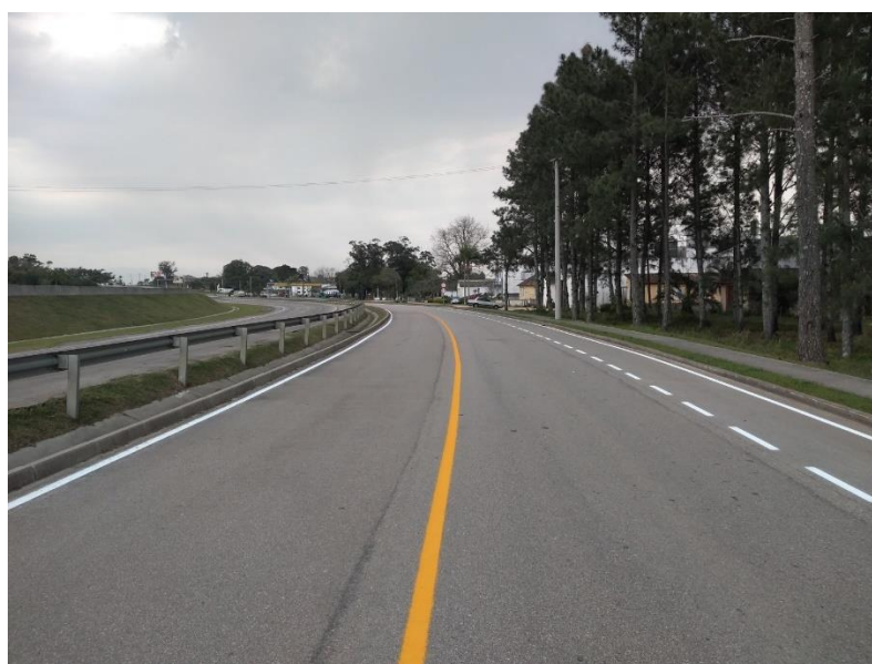
Figura 03 – Serviços de sinalização horizontal BR-116/RS Contorno de Pelotas / km 514+000
