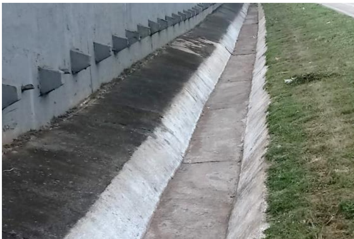
Figura 13: Limpeza e desobstrução de dispositivo de drenagem. (BR-364) Km 574
