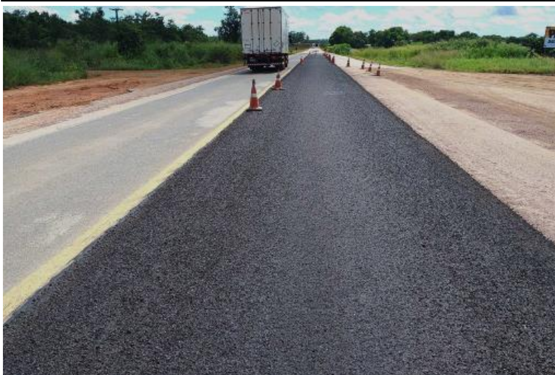
Figura 26: Aplicação de microrrevestimento. (BR-163) km 737 ao 738
