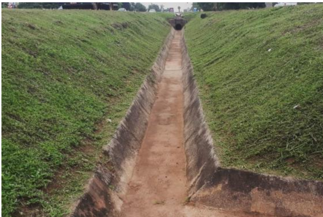
Figura 30: Limpeza e desobstrução de dispositivo de drenagem. (BR-163) Km 833
