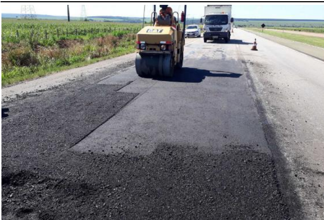
Figura 6: Execução de reparo localizado. (BR-163) Km 072
