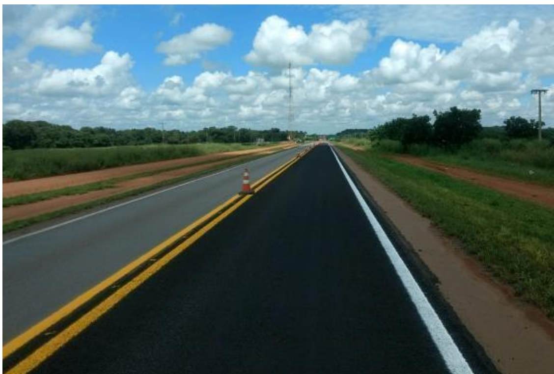
Figura 23: Aplicação de microrrevestimento. (BR-163) km 686 ao 691
