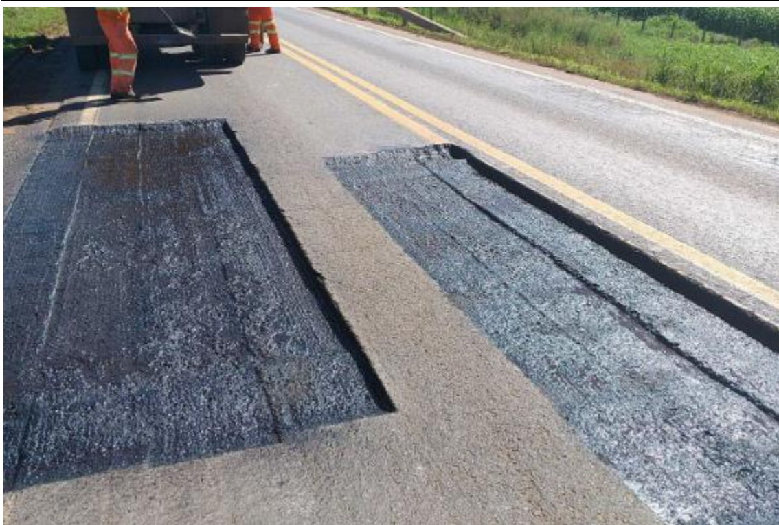
Figura 20: Execução de reparo localizado. (BR-163) Km 644,800
