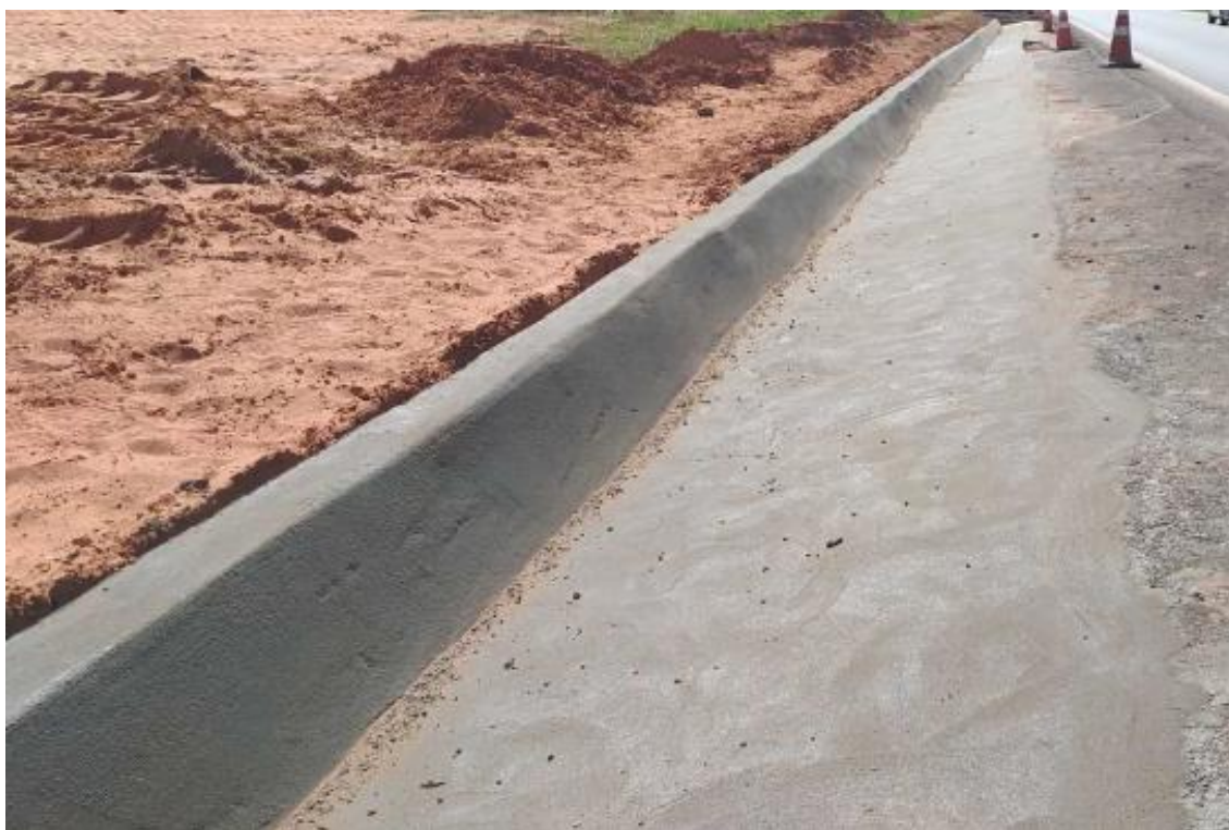
Figura 15: Implantação de sarjeta trapezoidal. (BR-163) Km 562
