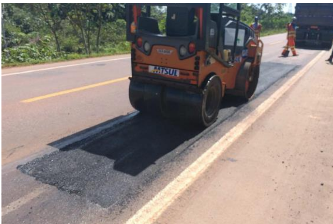
Figura 28: Execução de reparo localizado. (BR-163) km 790,600
