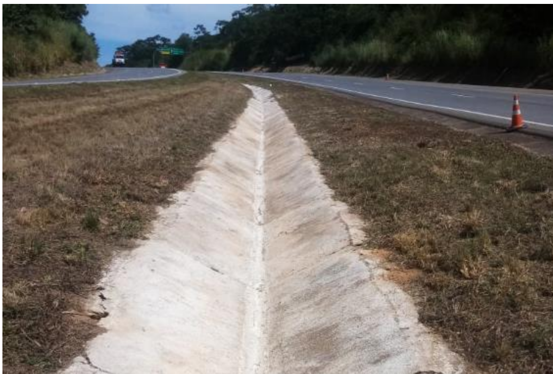
Figura 14: Execução de roçada mecanizada e limpeza e desobstrução de canaleta de canteiro central. (BR-364) Km 573 ao 576
