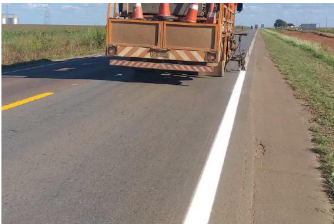
Figura 17: Revitalização de sinalização horizontal. (BR-163) Km 612 ao 617
