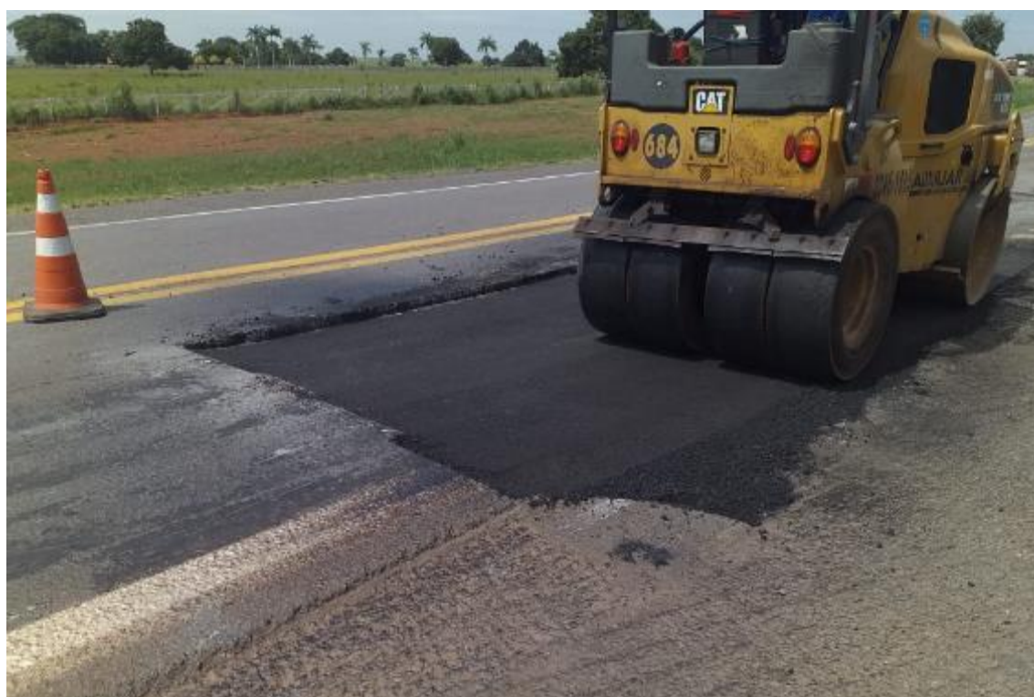
Figura 9: Execução de reparo localizado. (BR-364) Km 451,200
