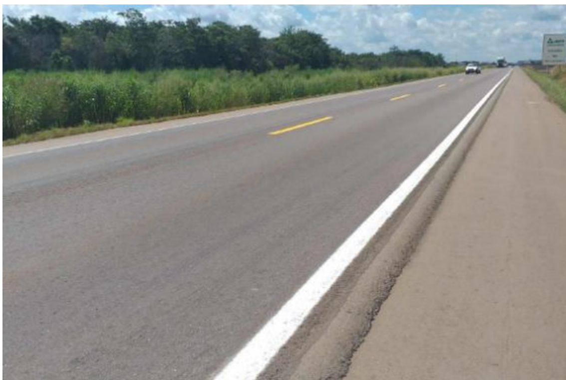
Figura 25: Revitalização de sinalização horizontal. (BR-163) Km 709 ao 712
