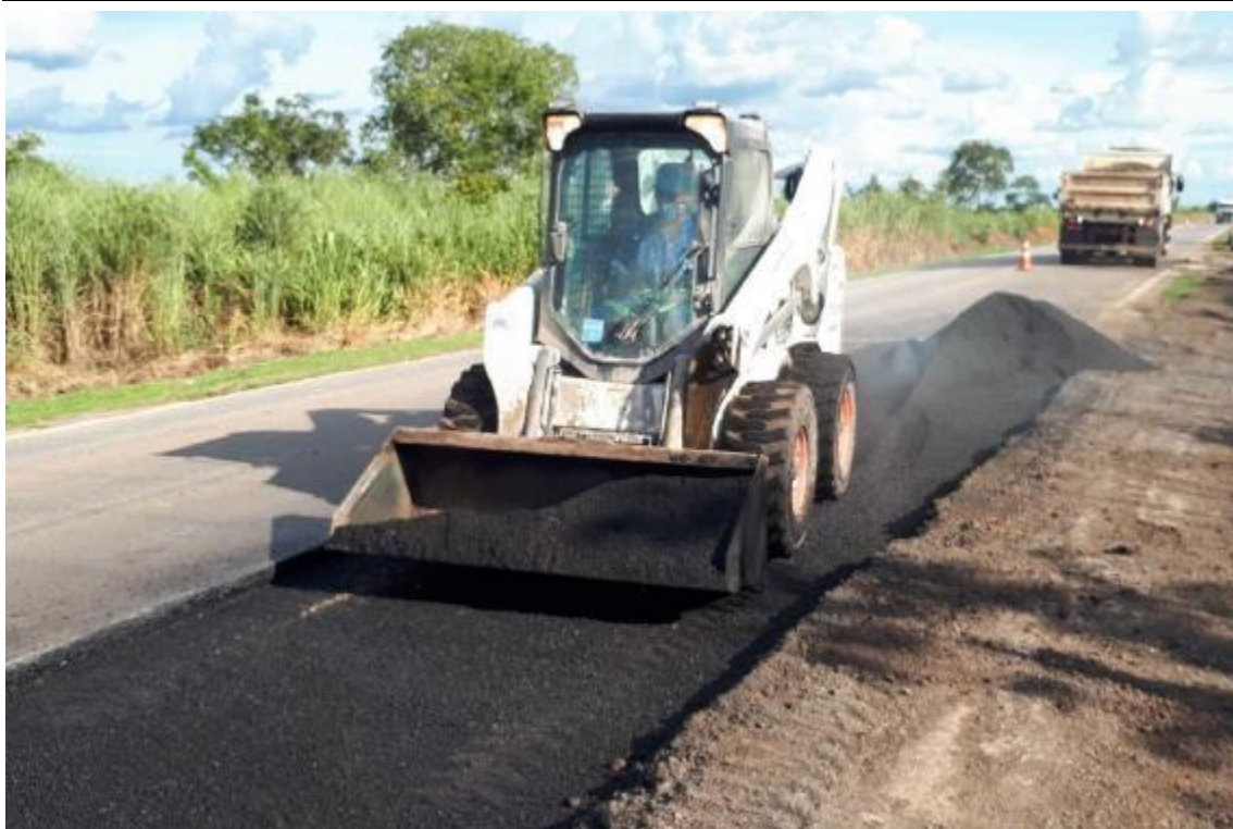
Figura 10: Execução de reparo localizado. (BR-364) Km 516
