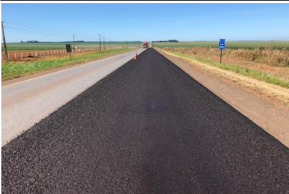
Figura 16: Aplicação de microrrevestimento. (BR-163) km 584 ao 584,400
