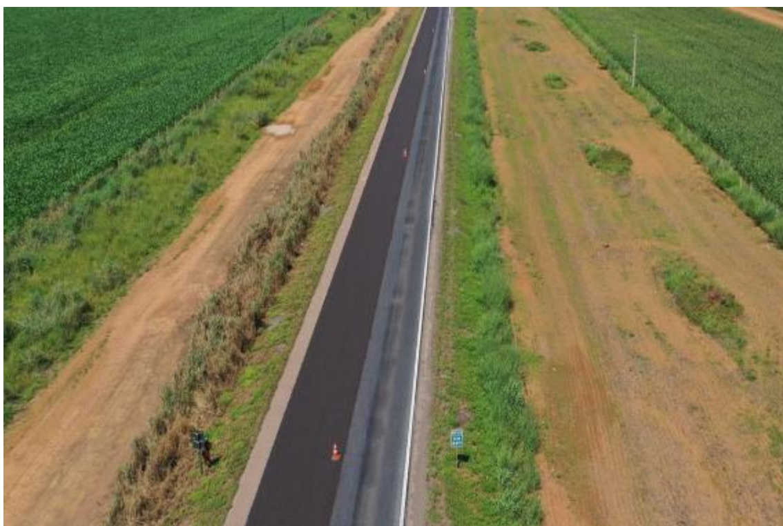
Figura 21: Aplicação de microrrevestimento. (BR-163) km 656 ao 657
