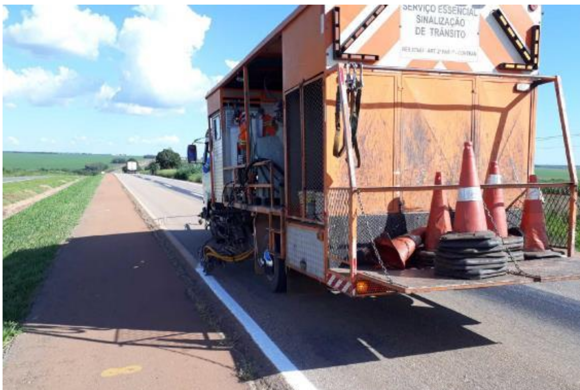
Figura 3: Revitalização de sinalização horizontal. (BR-163) Km 016 ao 018
