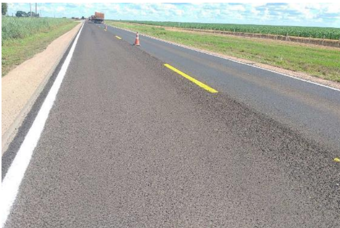
Figura 19: Revitalização de sinalização horizontal. (BR-163) Km 642 ao 645
